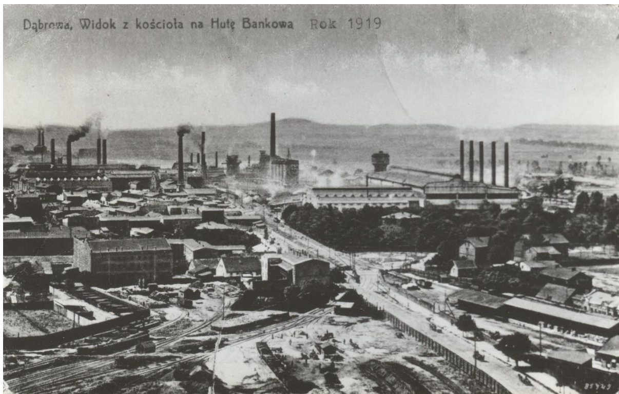
Zdj.61 Fotografia węzła kolejowego
