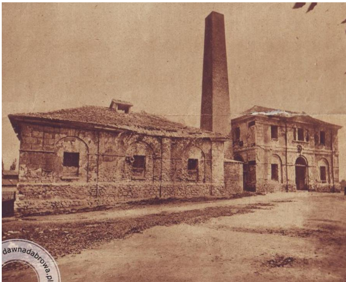
Zdj.9 Szyb wodny w miejscu Resursy.
