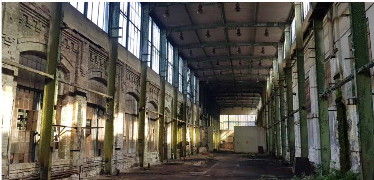
Fot. 4 - Budynek H4 - wnętrze
