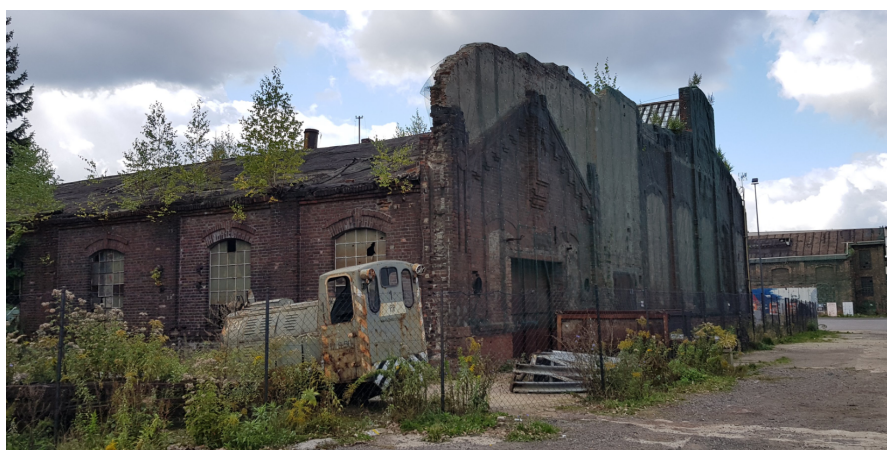
Fot. 1 - Budynek H1 - widok z zewnątrz
