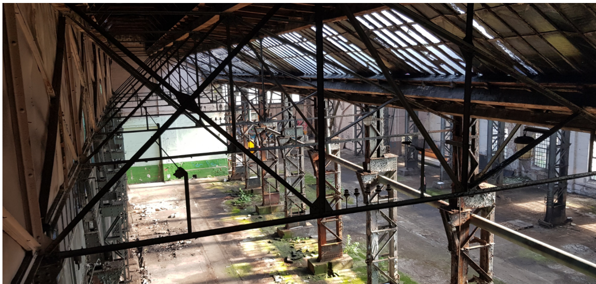
Fot. 7 - Budynek H8 - widok wnętrza
