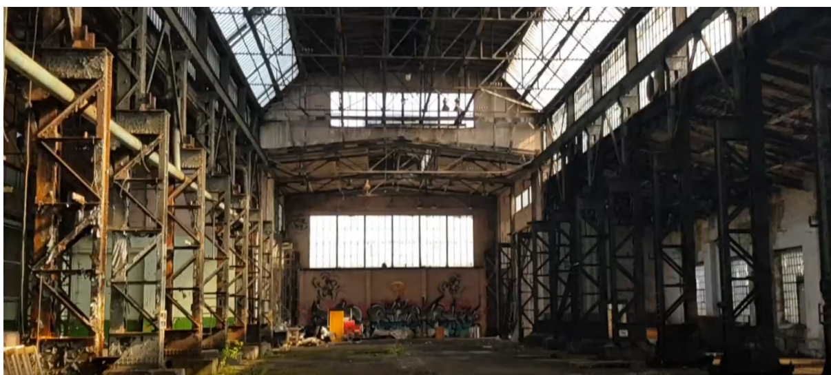
Fot. 8 - Budynek H8 - widok wnętrza
