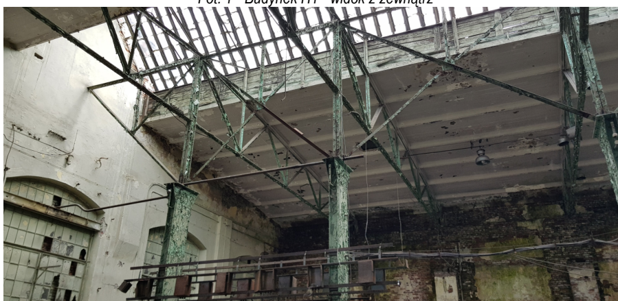
Fot. 2 - Budynek H1 - widok dachu od wewnątrz
