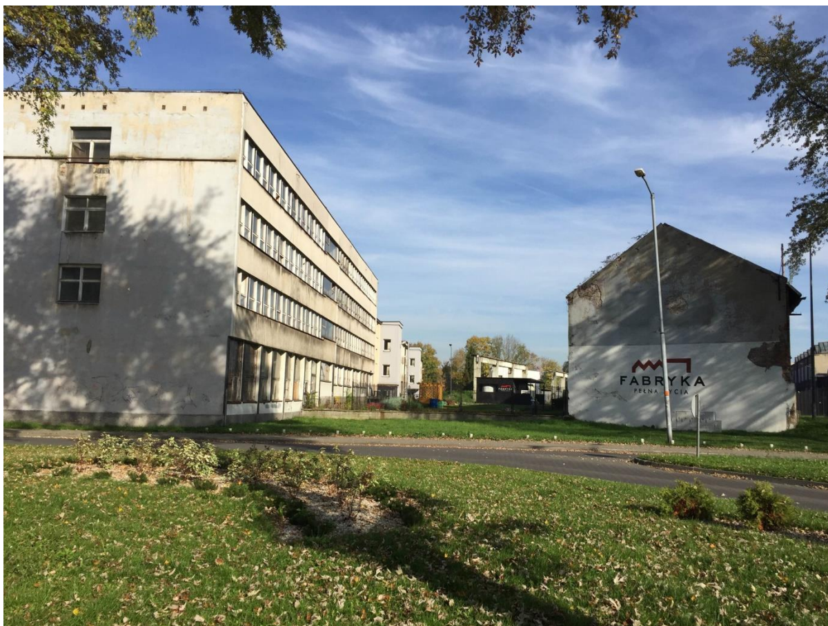
Widok na przestrzeń z ogrodem społecznym, fot. Sylwia Widzisz-Pronobis (56)
