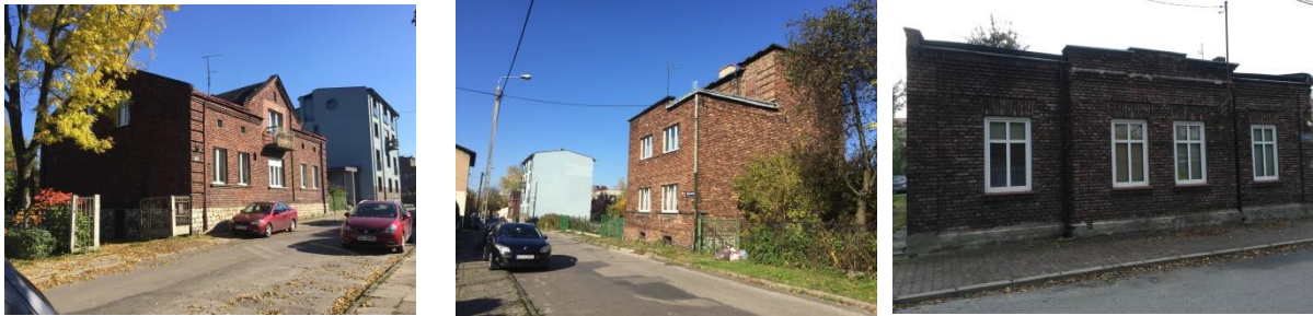
Zabudowa ceglana, fot. S. Widzisz-Pronobis (23)
