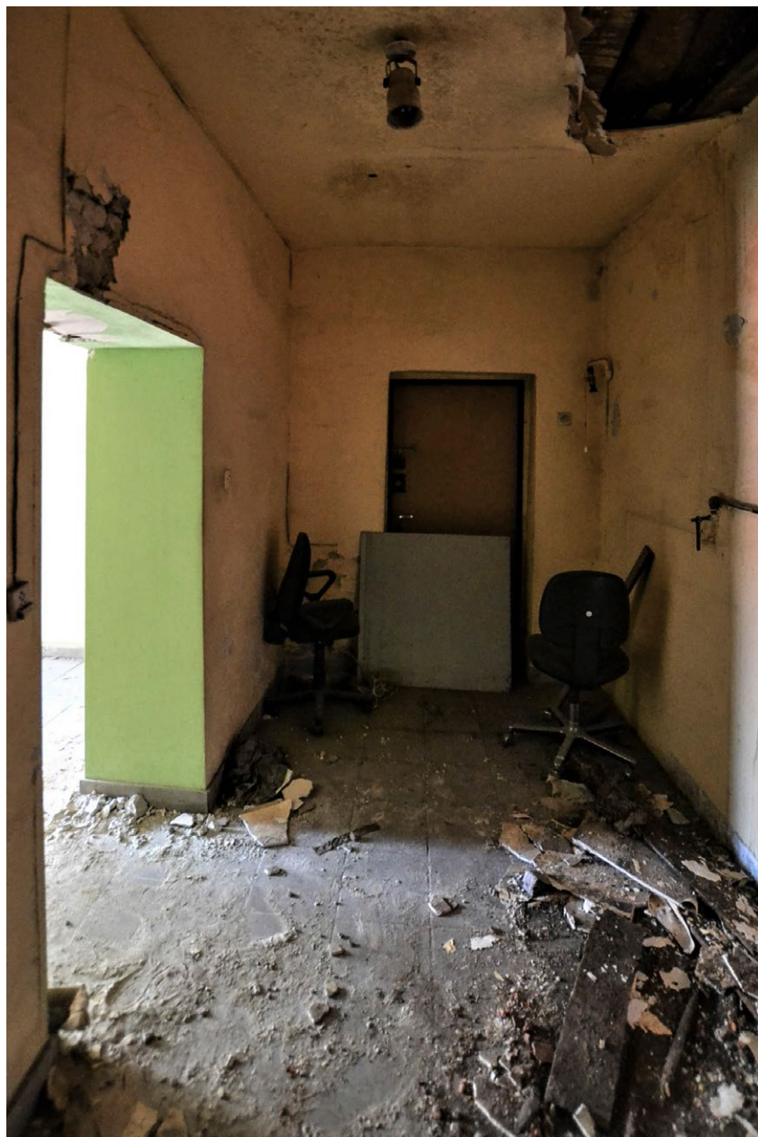
Lokal użytkowy przy ulicy Prądzyńskiego 20 – przed i po remoncie Fot. Lucyna Maury, Wrocławska Rewitalizacja
