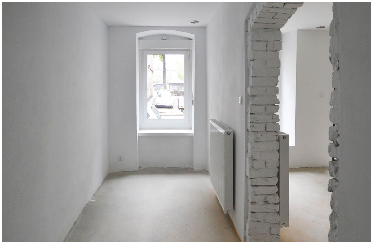
Lokal po remoncie, w którym zastosowano tradycyjne tynki cementowo-wapienne. Fot. Lucyna Maury, Wrocławska Rewitalizacja
