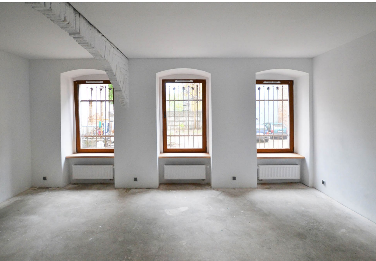
W lokalu przy ulicy Komuny Paryskiej 82/4 zachowano okna. W celu poprawy wentylacji wyposażone zostały w nawietrzaki. Fot. Lucyna Maury, Wrocławska Rewitalizacja
