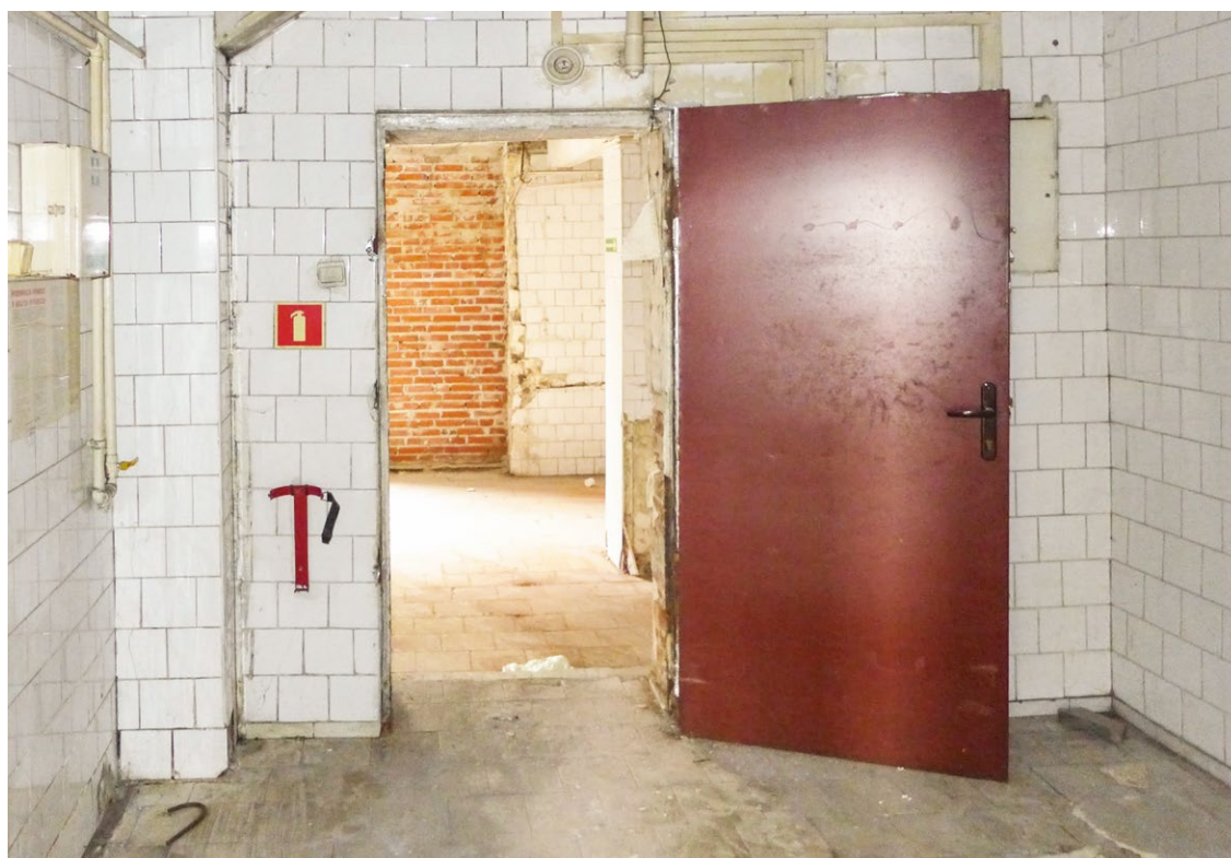
Wstępna inwentaryzacja architektoniczno-budowlana i ocena stanu technicznego lokalu to niezbędny krok w przygotowaniu zamówień na prace projektowe i oszacowaniu kosztów całego zamierzenia. Fot. Paweł Wojdyłak, Wrocławska Rewitalizacja
