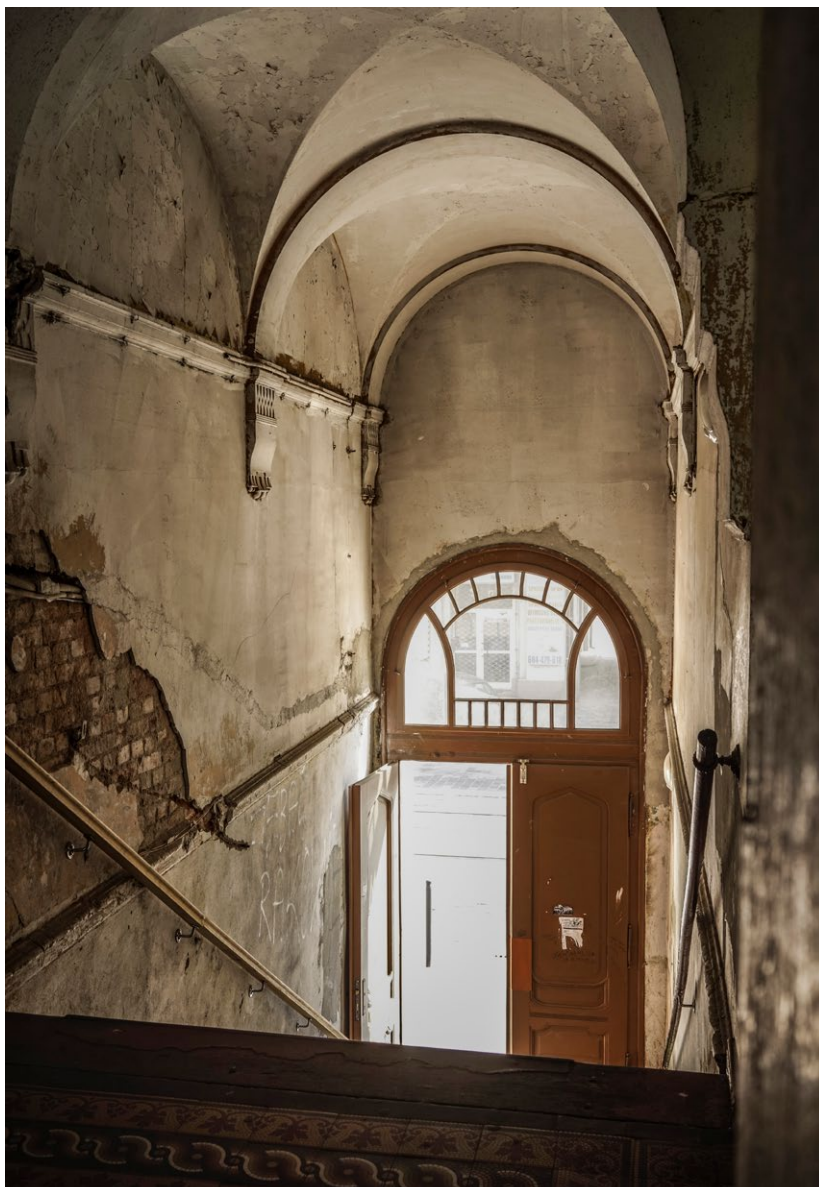
Zwykle zachwycamy się bogato zdobionymi elewacjami XIX- wiecznych kamienic. Ale równie fascynujące są klatki schodowe tych budynków. Fot. Thomas Arns
