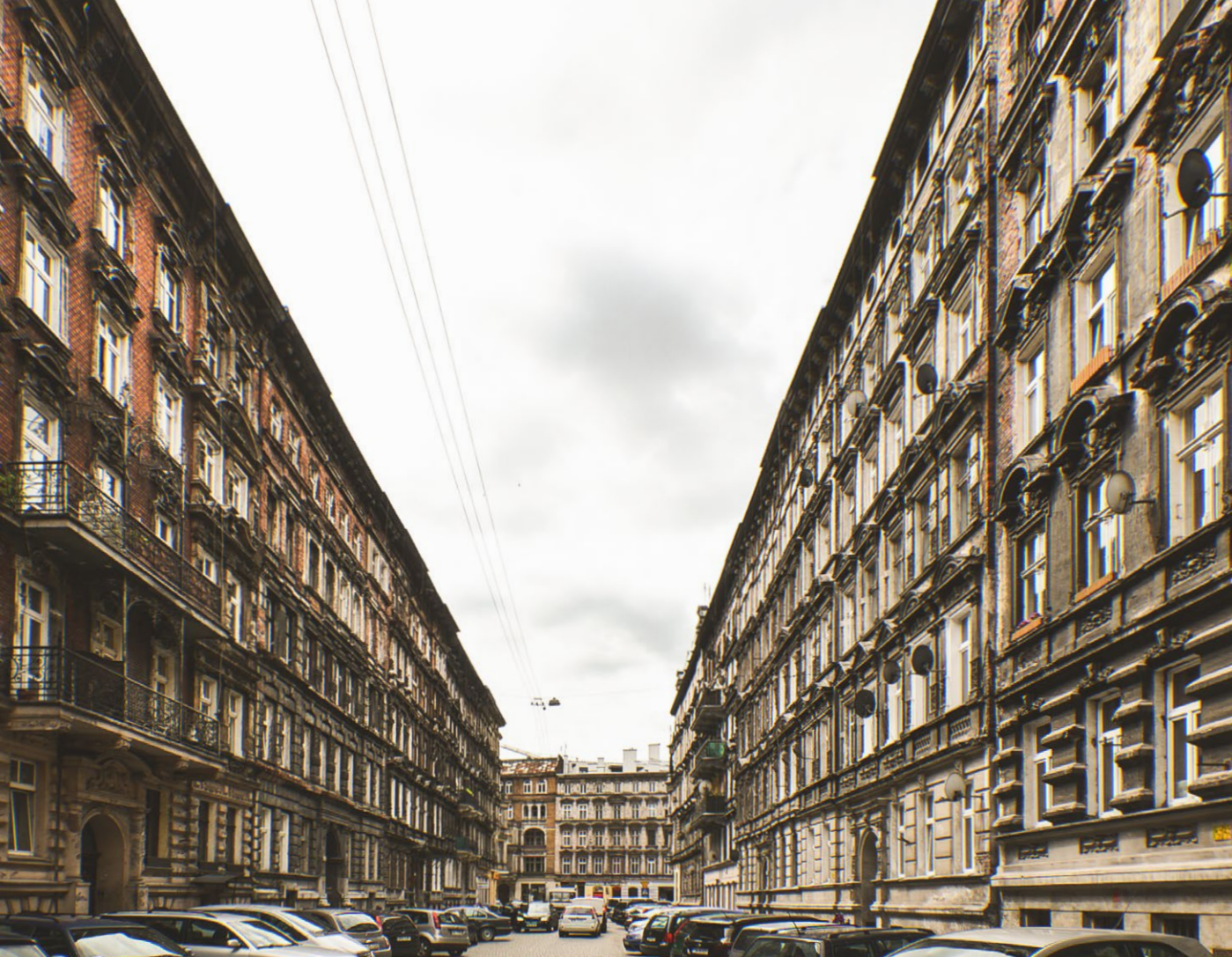
Ulica Miernicza na Przedmieściu Oławskim dzięki swojej historycznej, od lat niezmienniej zabudowie jest tak niezwykła, że niejednokrotnie stanowiła kulisy do filmów. Dopiero niedawno rozpoczęły się remonty pojedynczych kamienic. Fot. Wroclawska Rewitalizacja
