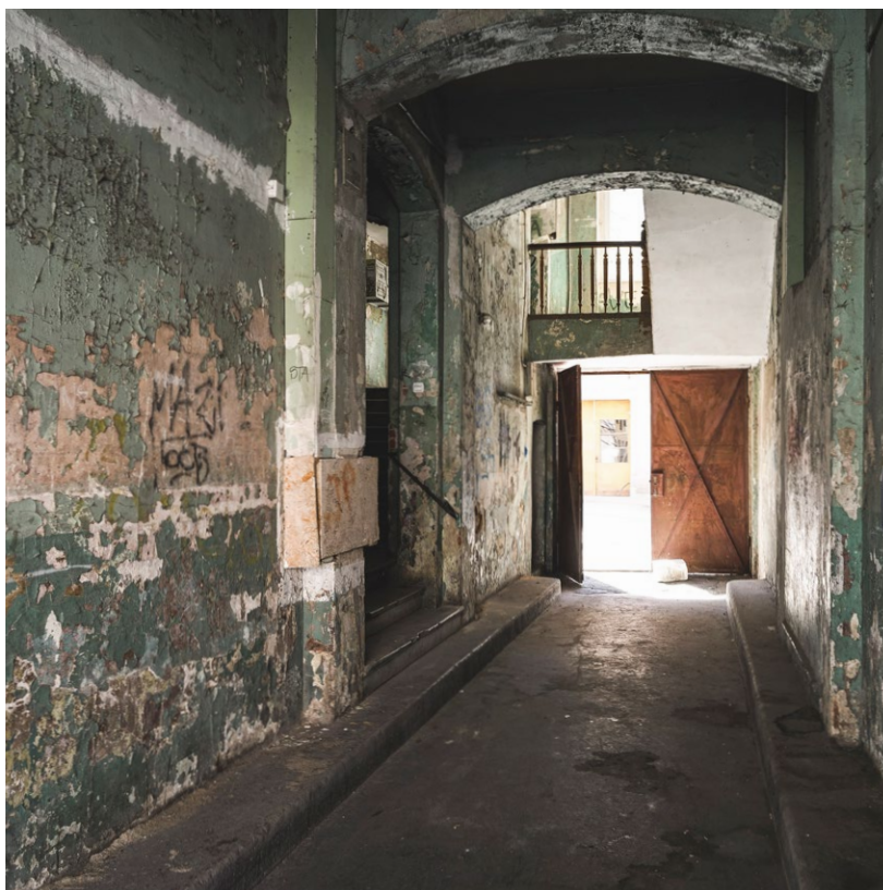
Typowy dla XIX-wiecznej wrocławskiej kamienicy przejazd bramny na podwórze. Fot. Thomas Arns
