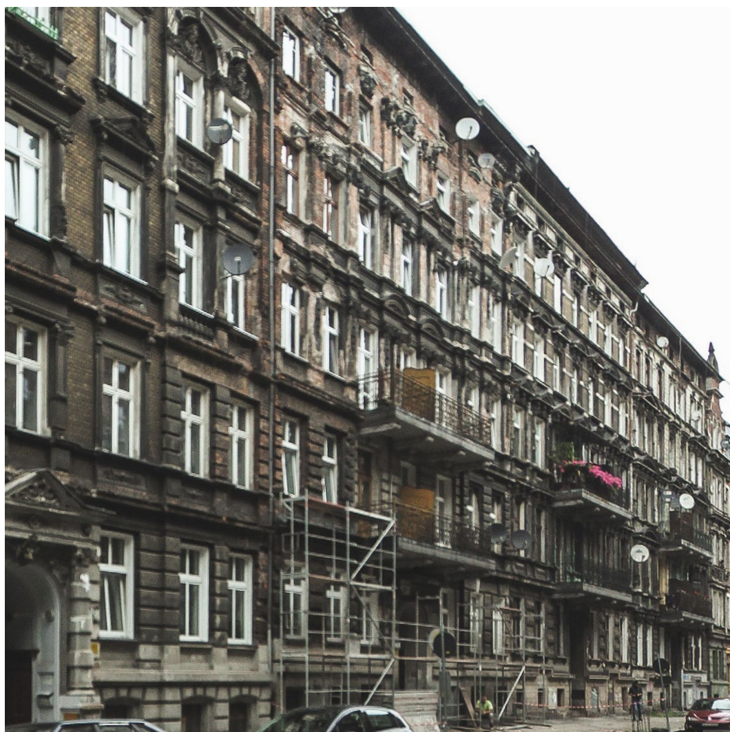
Kamienica przy ul. Mierniczej 7 przed remontem w 2018 r. Fot. Artur Busz, Wrocławska Rewitalizacja
