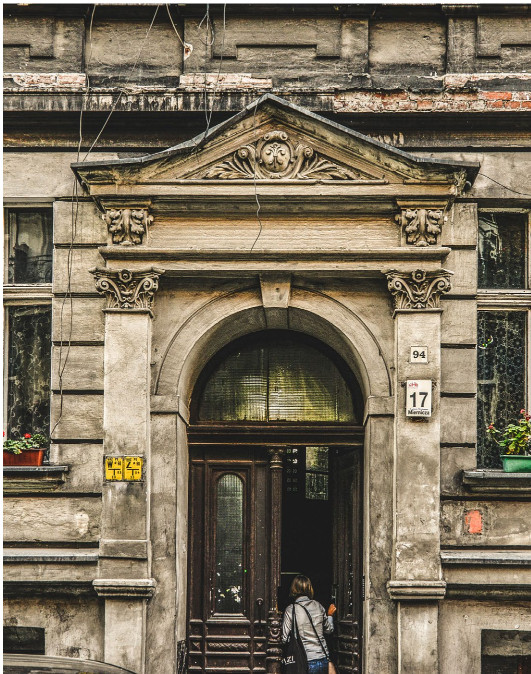
Wejście do kamienicy przy ulicy Mierniczej na Przedmieściu Oławskim. Fot. Artur Busz, Wrocławska Rewitalizacja
