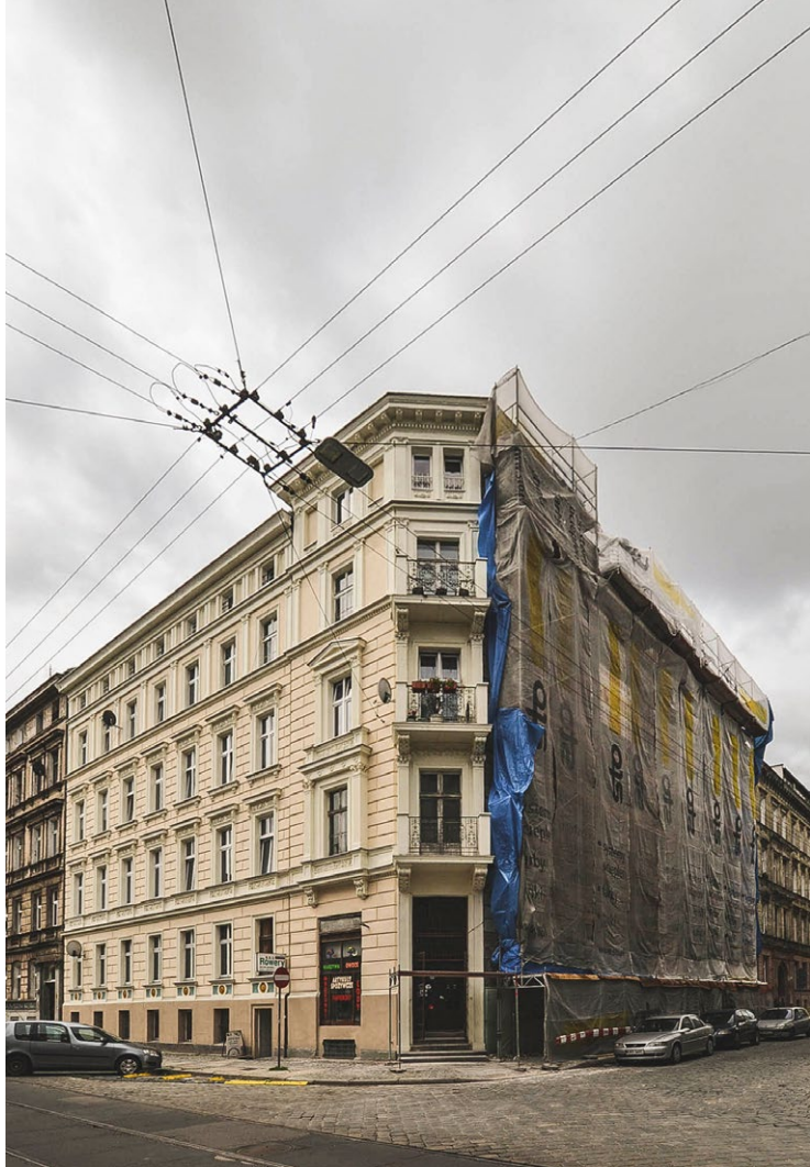
Remont kamienicy to nie tylko wydatek - to również podniesienie wartości nieruchomości i zapewnienie komfortu mieszkaniowego na kolejne dziesięciolecia. Dlatego coraz więcej wspólnot mieszkaniowych decyduje się na ten krok. Fot. Lucyna Maury, Wrocławska Rewitalizacja
