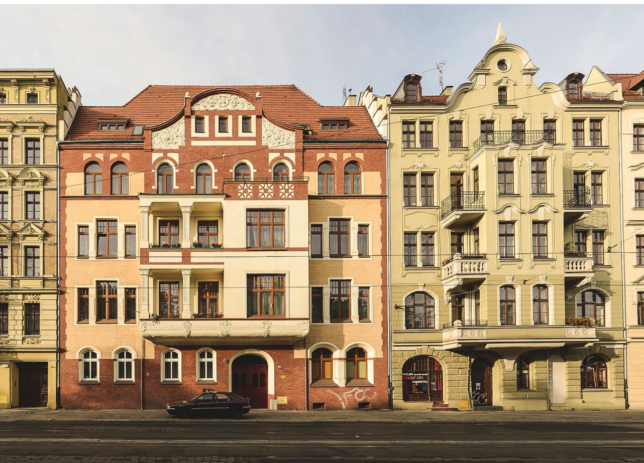
Powstały w tym samym okresie, a reprezentują niezwykłą różnorodność i bogactwo detalu. Wyremontowane elewacje XIX-wiecznych kamienic na Nadodrze we Wrocławiu. Fot. Thomas Arns
