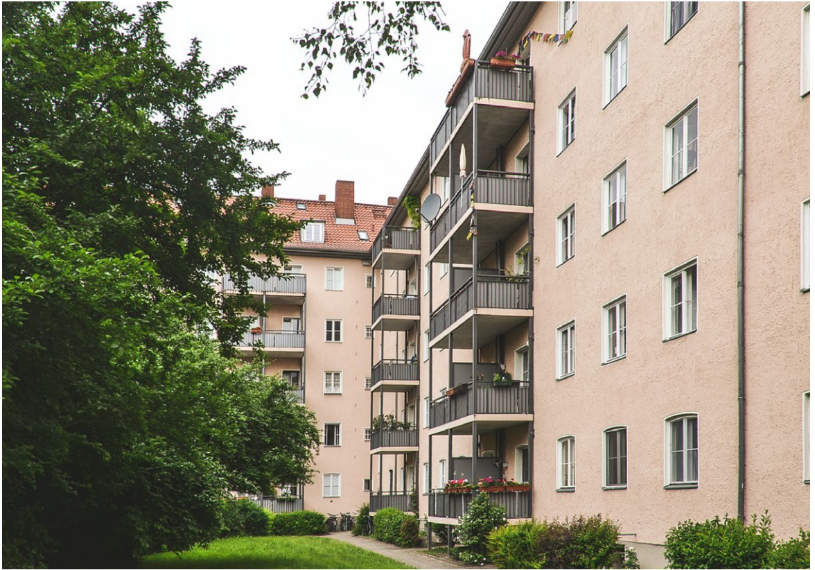
W tym kwartale w berlińskiej dzielnicy Friedenau balkony dostawiono do elewacji podwórkowej. Dzięki temu mieszkańcy zyskali dodatkową przestrzeń i możliwość aktywniejszych kontaktów sąsiedzkich. Fot. Lucyna Maury, Wrocławska Rewitalizacja
