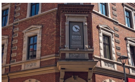
Narożna kamienica neorenesansowa. ul. Reja 2
