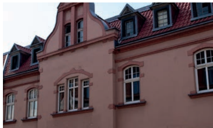
Wykusz kamienicy z przełomu XIX i XX wieku. ul. Sobieskiego 21
