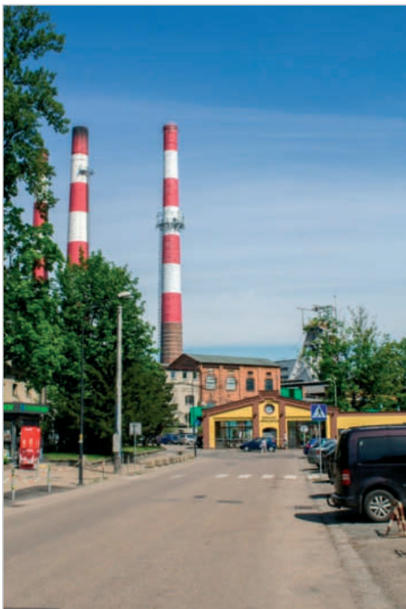
Kopalnia Węgla Kamiennego „Chwałowice”
