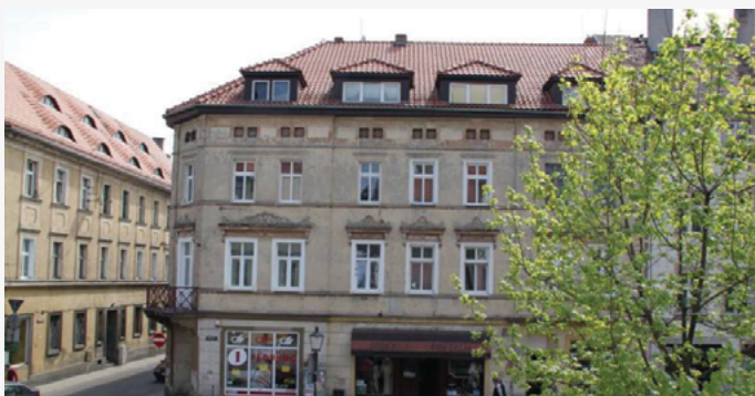
ul. Mikołaja przed remontem
