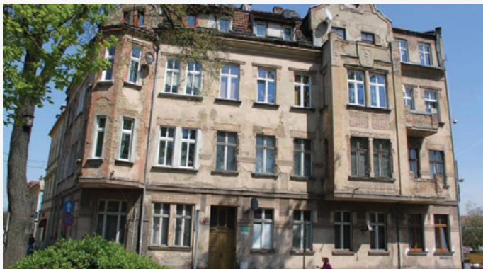
ul. Żymierskiego przed remontem
