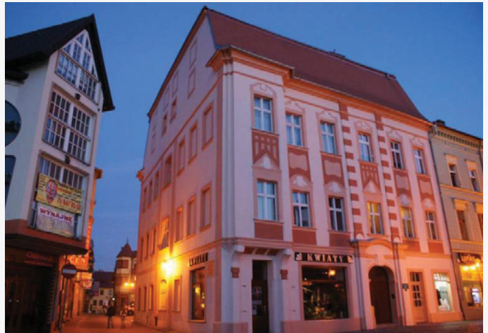
ul. Bracka po remoncie
