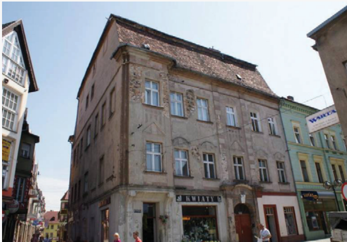
ul. Bracka przed remoncie
