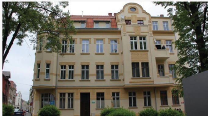
ul. Żymierskiego po remoncie
