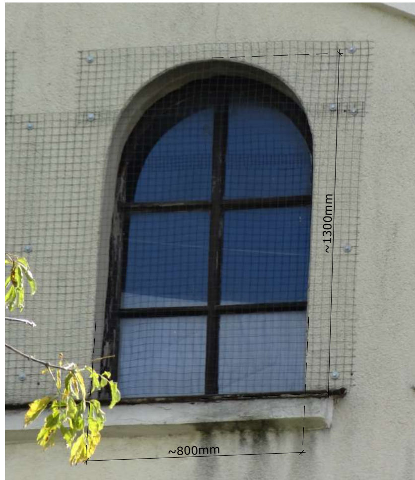
Fot. 1: Stolarka okienna, typ O-60. Widok z podstawowymi wymiarami stolarki. Źródło: Fotografia. Autorzy opracowania (OUTIN Architektura).
