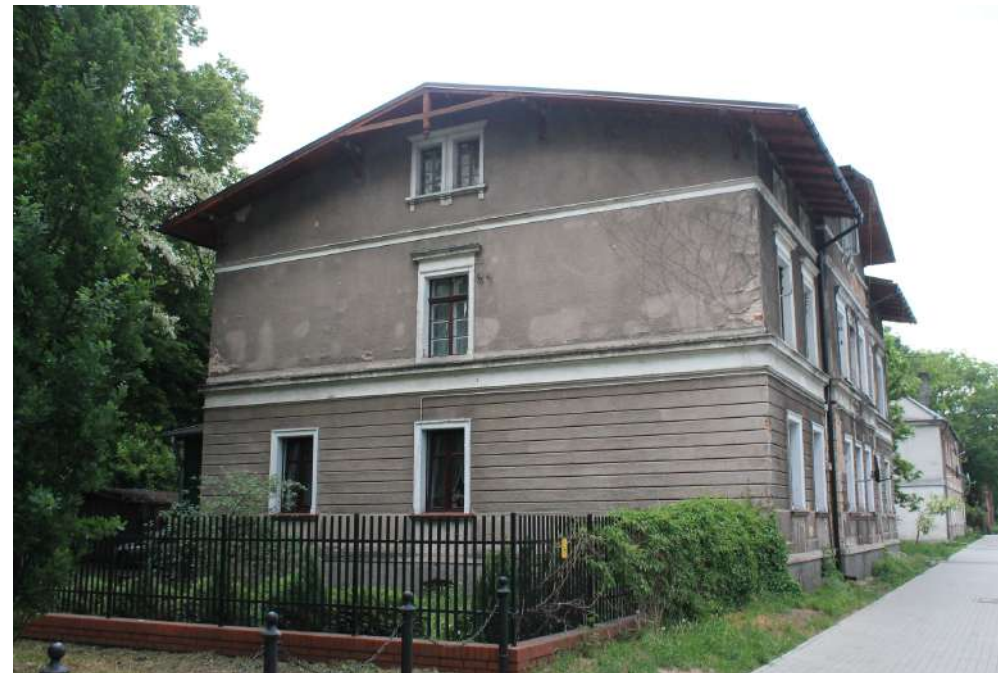
Fot. 2: Budynek przy ul. Żeromskiego 10. Elewacja zachodnia Źródło: Fotografia. Autorzy opracowania (OUTIN Architektura)
