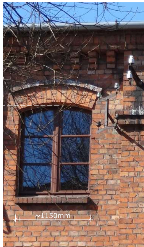
Fot. 1: Stolarka okienna, typ O-20. Widok z podstawowymi wymiarami stolarki (widok zewnętrzny).
