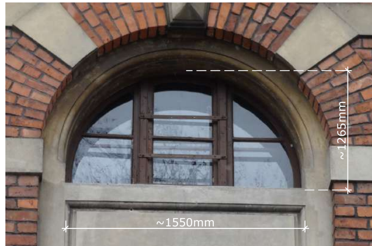
Fot. 1: Stolarka okiennej, typ O-25. Widok z podstawowymi wymiarami stolarki (widok zewnętrzny).
