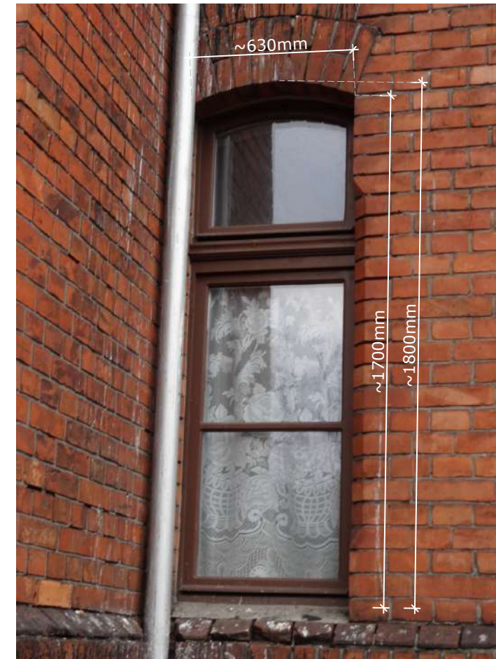
Fot. 2: Okno O-47 z podstawowymi wymiarami istniejącej stolarki okiennej (otwór okienny w świetle muru). Źródło: Fotografia. Autorzy opracowania (OUTIN Architektura).
