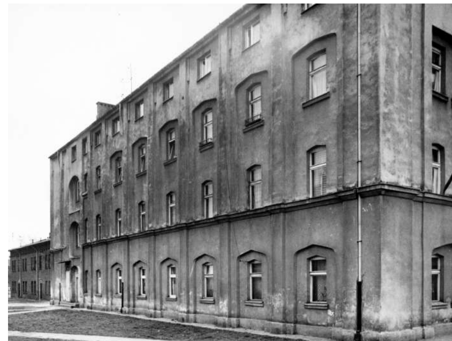
Fot. 4: Dom, ul. Mireckiego 70. Widok elewacji tylnej: północnej.
