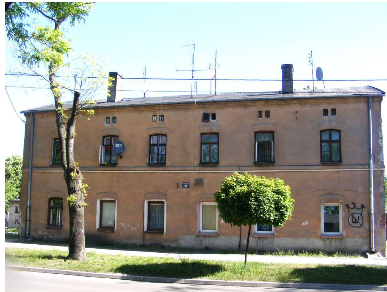
Fot. 2: Budynek, ul. Limanowskiego 18. Elewacja.
