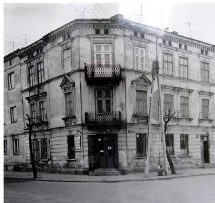
Fot. 2: Dom, ul. Kościuszki 29. Źródło: Fotografia. Dokumentacja Konserwatorska PKZ Warszawa 1976. Archiwum WUOZ w Warszawie.
