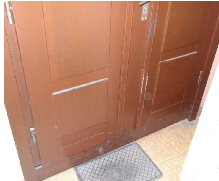
Fot. 4: Stolarka drzwiowa, typ D-03. Detal. Płyciny (filąg, kaseton) od strony wewnętrznej. Źródło: Fotografia. Autorzy opracowania (OUTIN Architektura).
