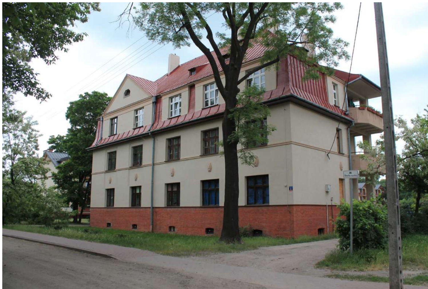
Fot. 1: Dom, ul. Farbiarska 2. Widok elewacji frontowej. Źródło: Fotografia. Autorzy opracowania (OUTIN Architektura).
