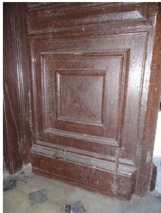
Fot. 4: Stolarka drzwiowa, typ D-02. Detal. Rzeźbiona dekoracja płyciny (filągu, kasetonu) o charakterze geometrycznym widok od strony wewnętrznej. Źródło: Fotografia. Autorzy opracowania (OUTIN Architektura).
