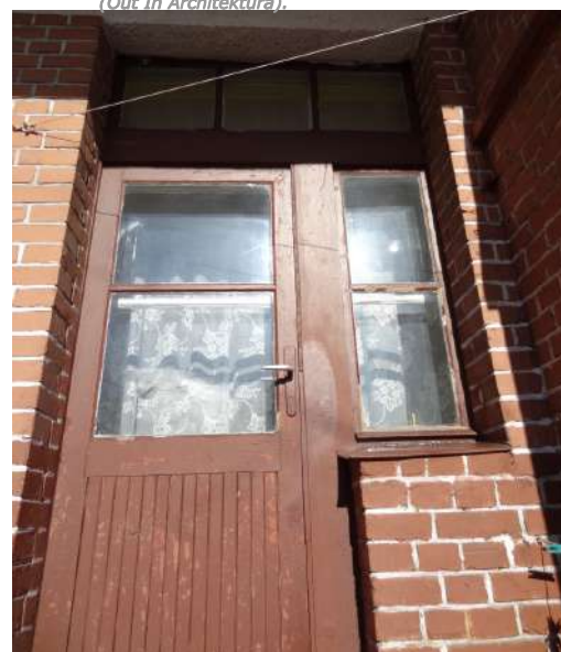
Fot. 3: Stolarka drzwiowa, typ D-17. Detal. Źródło: Fotografia. Autorzy opracowania (OUTIN Architektura).
