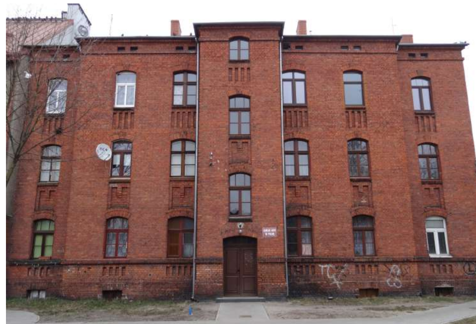
Fot. 1: Budynek, ul. 1 Maja 57. Elewacja od podwórza. Widok obecny. Źródło: Fotografia. Autorzy opracowania (OUTIN Architektura).
