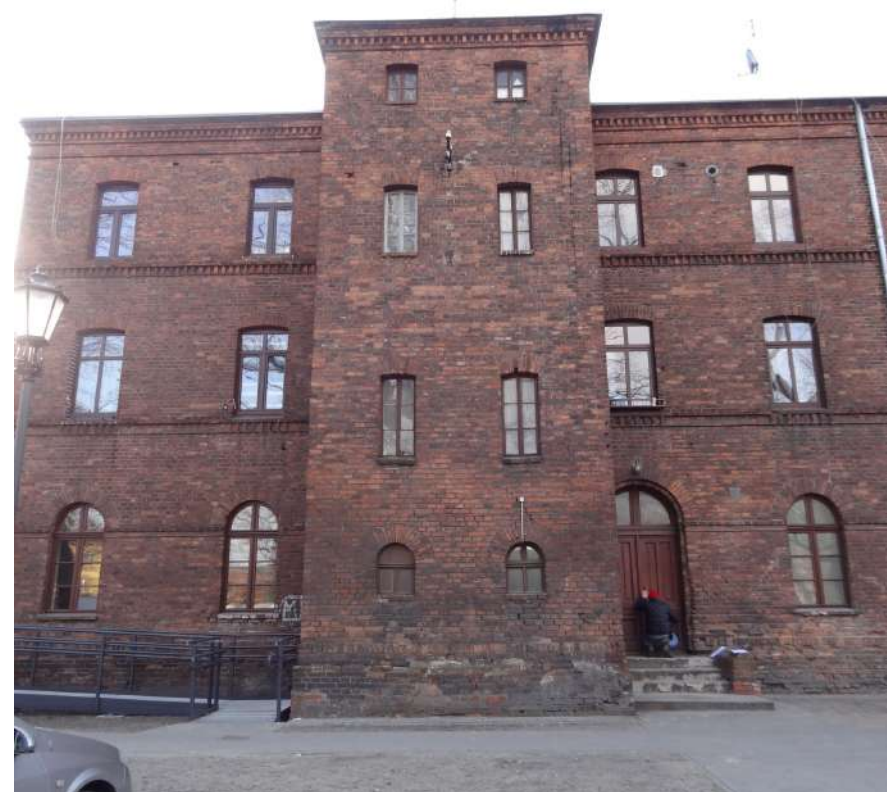
Fot. 3: Budynek, ul. 1 Maja 52. Fragment elewacji obecnie. Źródło: Fotografia. Autorzy opracowania (OUTIN Architektura).
