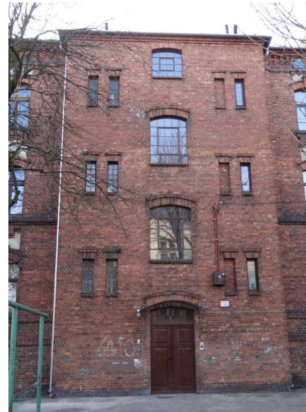
Fot. 2: Budynek, ul. Kościelna 4. Fragment elewacji.
