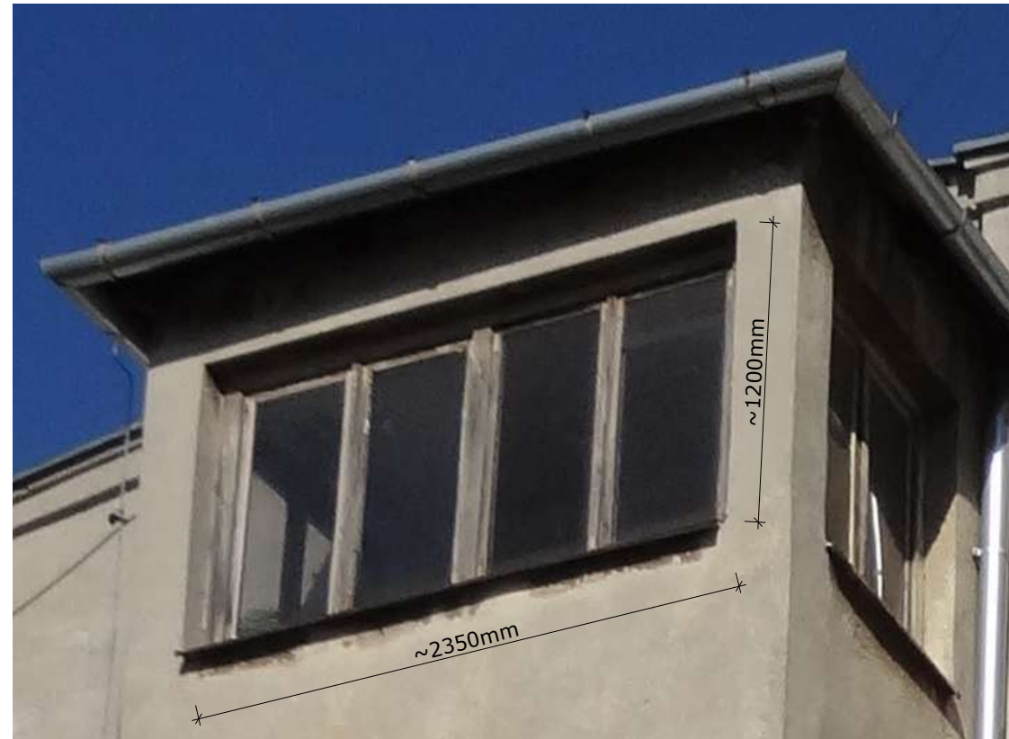
Fot. 1: Okno O-50 z podstawowymi wymiarami istniejącej stolarki okiennej. Widok od zewnątrz (otwór okienny w świetle muru).
