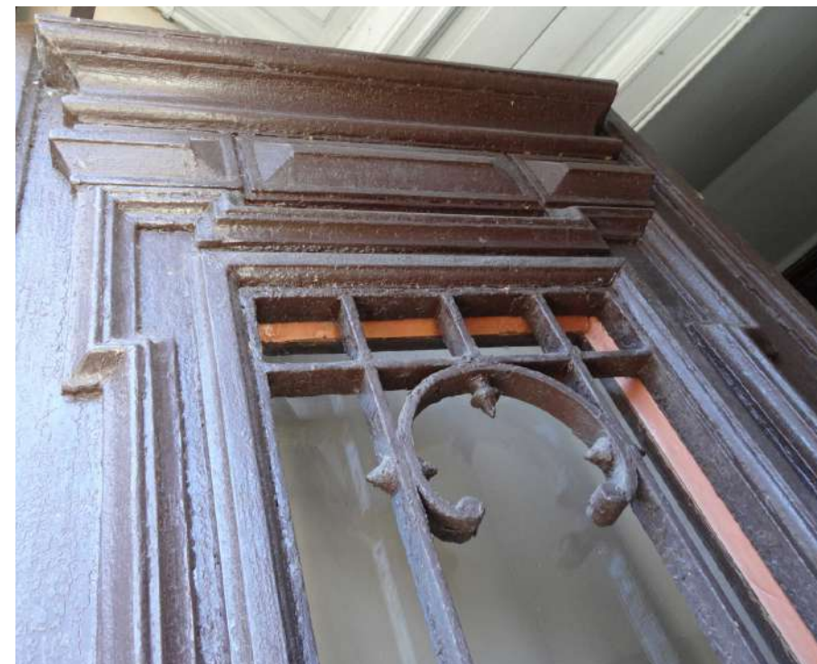
Fot. 5: Stolarka drzwiowa, typ D-02. Detal. Rzeźbiona dekoracja skrzydła: przeszlenie z kratą stalową. Źródło: Fotografia. Autorzy opracowania (OUTIN Architektura).
