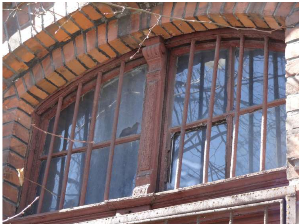
Fot. 1: Stolarka drzwiowa, typ D-13. Detal: naświetle z rzeźbionym słupkiem stałym. Źródło: Fotografia. Autorzy opracowania (OUTIN Architektura).
