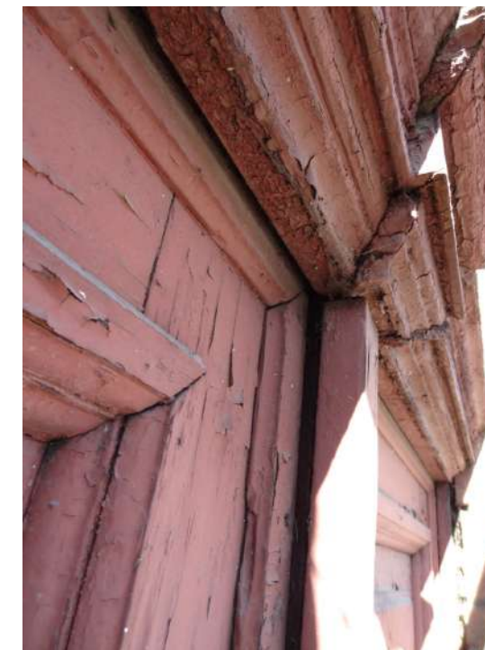
Fot. 3: Stolarka drzwiowa, typ D-13. Detal: belka ślepienna, listwa przymykowa, pływina. Źródło: Fotografia. Autorzy opracowania (OUTIN Architektura).
