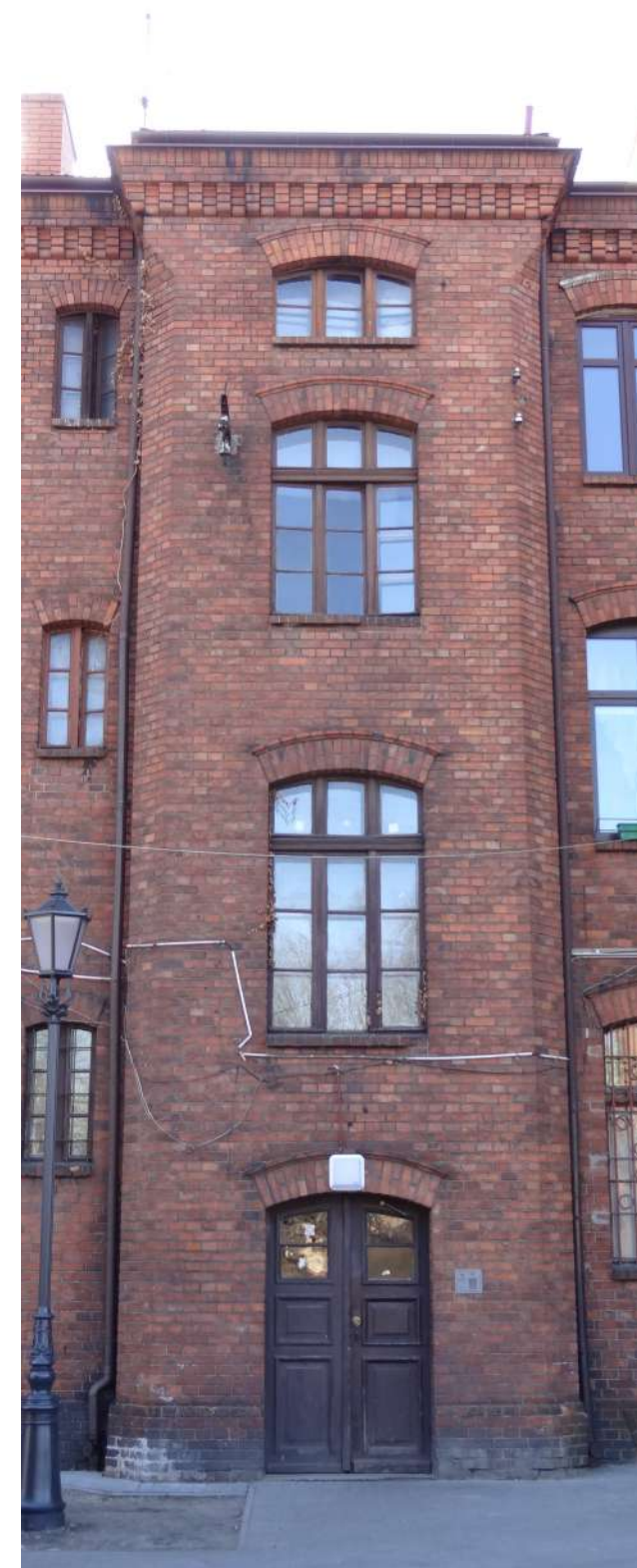
Fot. 4: Budynek, ul. 1 Maja 54. Fragment elewacji obecnie. Źródło: Fotografia. Autorzy opracowania (OUTIN Architektura).
