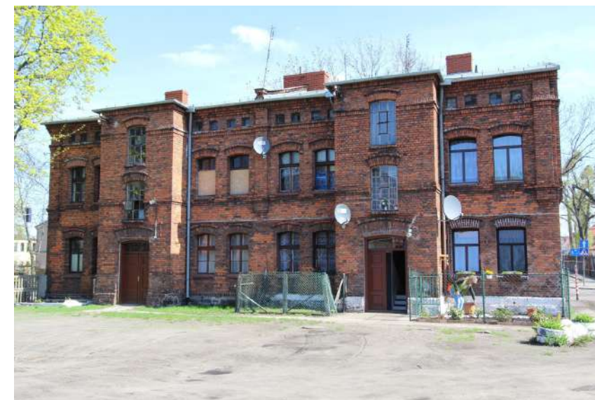
Fot. 5: Budynek, ul. Kościelna 15. Widok od zach.
