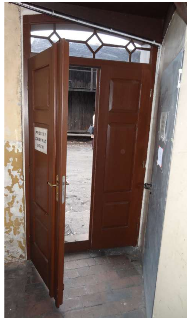
Fot. 2: Stolarka drzwiowa, typ D-03. Widok wewnętrzny. Stolarka wymieniona z odtworzeniem pierwotnych podziałów i gabarytów profilii.
