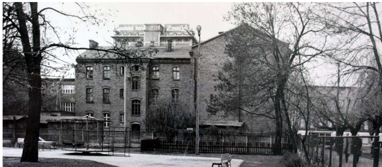
Fot. 3: Dom, ul. 1 Maja 54. Widok od strony podwórza. Źródło: Fotografia. Dokumentacja Konserwatorska PKZ Warszawa 1976. Archiwum WUOZ w Warszawie.
