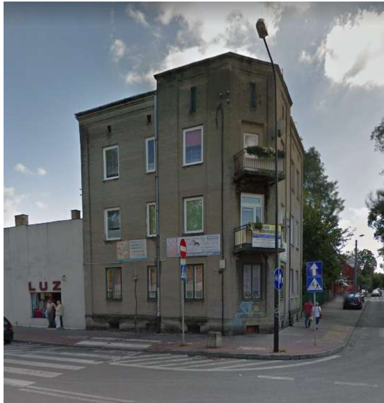
Fot. 1: Budynek przy ul. Wysockiego 28. Widok od strony ulicy
