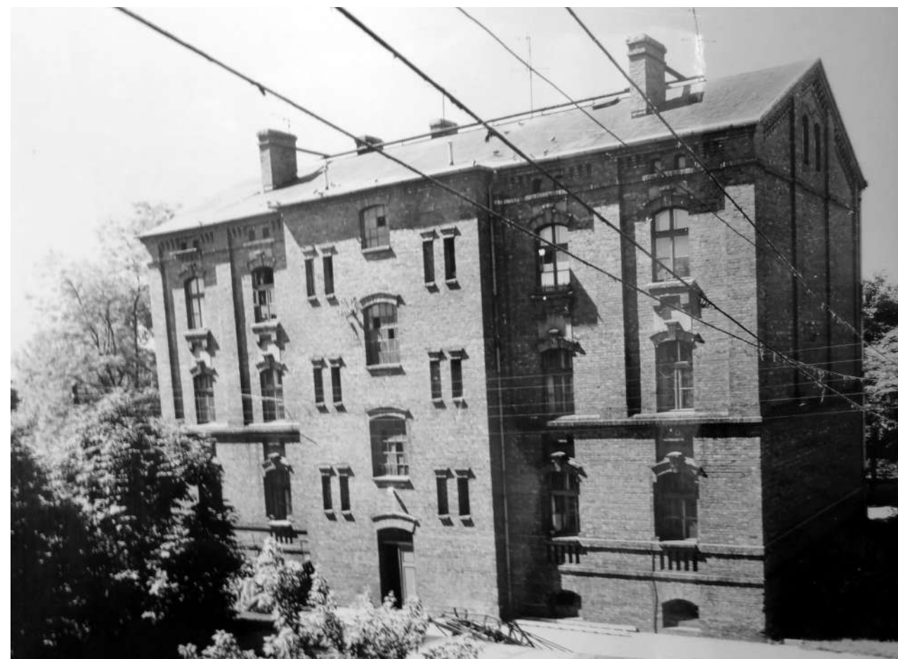
Fot. 3: Dom, ul. Żymirskiego 4 (obecna Kościelna).
