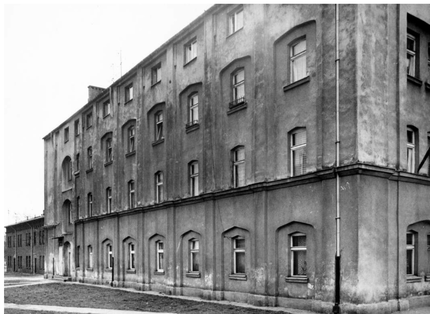
Fot. 3: Dom, ul. Mireckiego 70. Widok elewacji tylnej: północnej.
