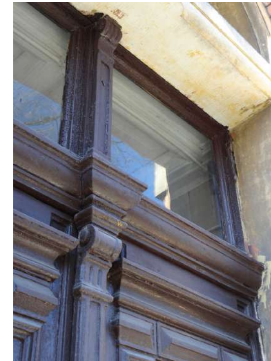
Fot. 3: Stolarka drzwiowa, typ D-02. Detal. Rzeźbiona dekoracja belki ślimiennej, listy przymykowej i słupka stałego naświetla. Źródło: Fotografia. Autorzy opracowania (OUTIN Architektura).
