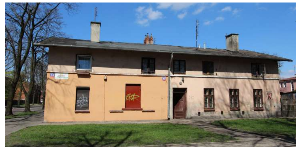
Fot. 7: Dom, ul. Kościuszki 32. Widok od strony
