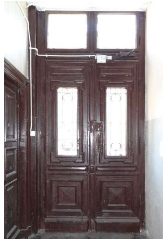
Fot. 3: Stolarka drzwiowa, typ D-02. Widok od wewnątrz.
