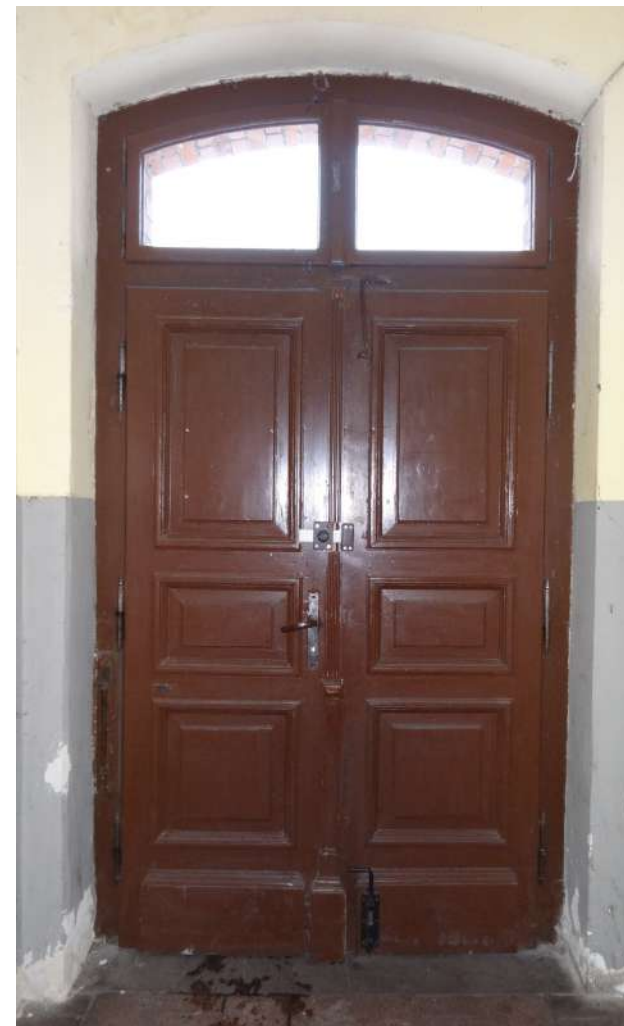
Fot. 2: Stolarka drzwiowa, typ D-09. Widok wewnętrznie. Źródło: Fotografia. Autorzy opracowania (OUTIN Architektura).
