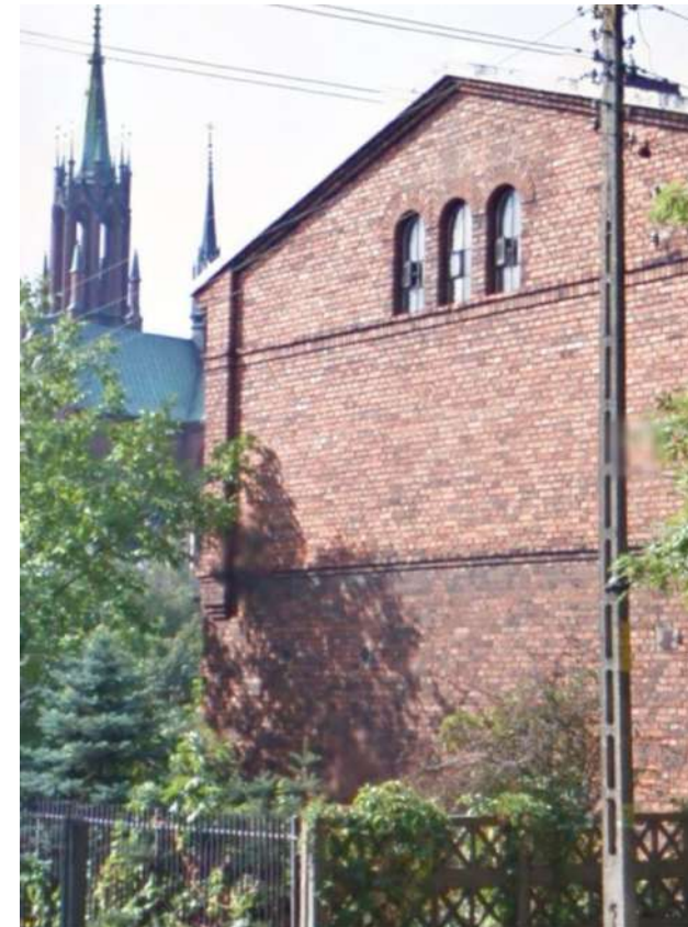
Fot. 3: Budynek, ul. Kościelna 7. Widok od strony ulicy, ściana szczytowa.
