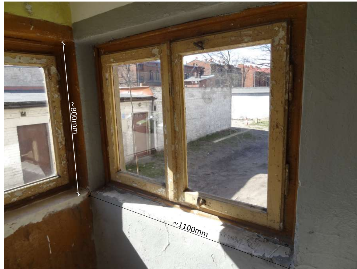
Fot. 1: Okno O-49 z podstawowymi wymiarami istniejącej stolarki okiennej. Widok od wewnątrz (otwór okienny w świetle muru).
