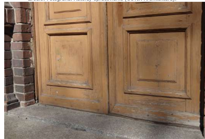
Fot. 3: Stolarka drzwiowa, typ D-16. Detal: płycina.
