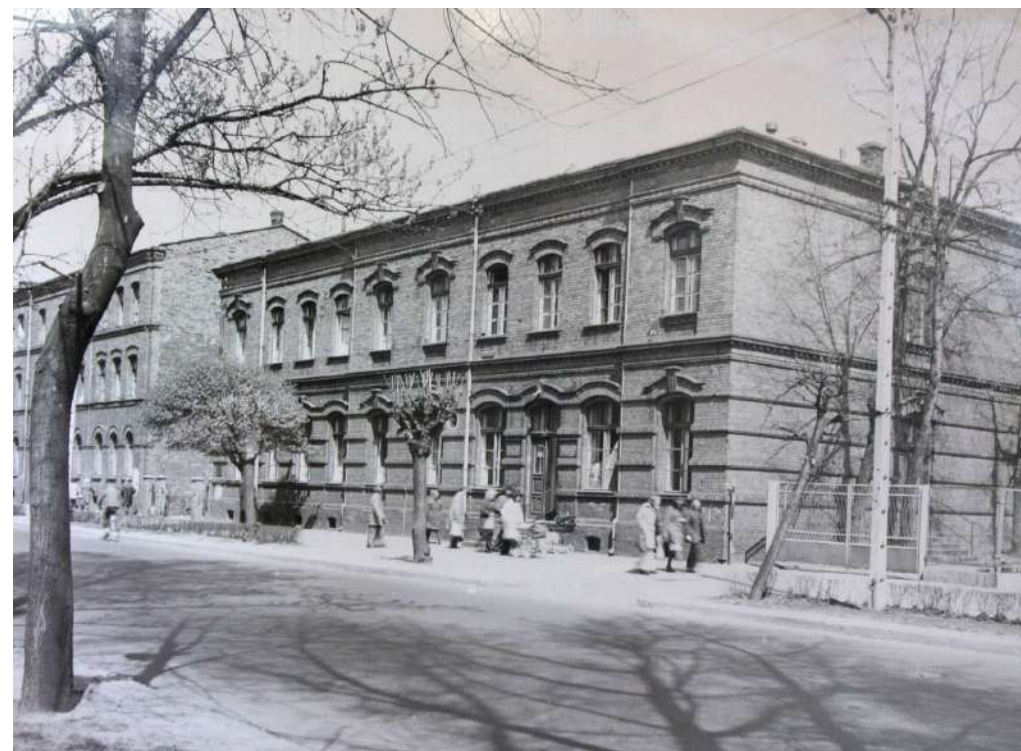
Fot. 4: Dom, ul. 1 Maja 50. Widok elewacji frontowej.
