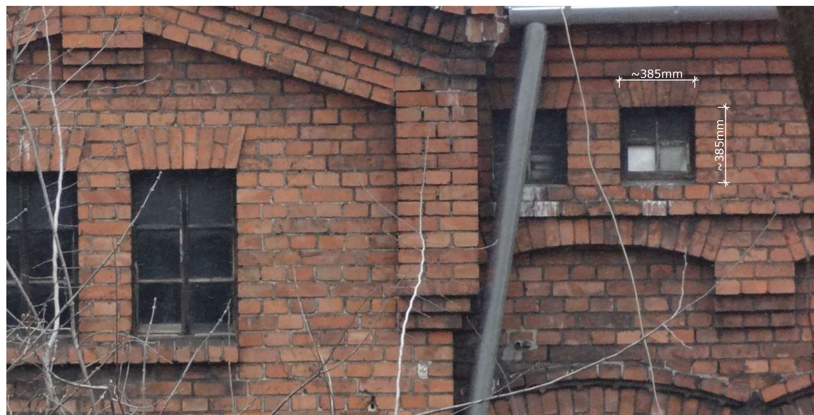
Fot. 3: Stolarka okienna, typ O-22. Widok z podstawowymi wymiarami stolarki (widok zewnętrzny). Źródło: Fotografia. Autorzy opracowania (OUTIN Architektura).
