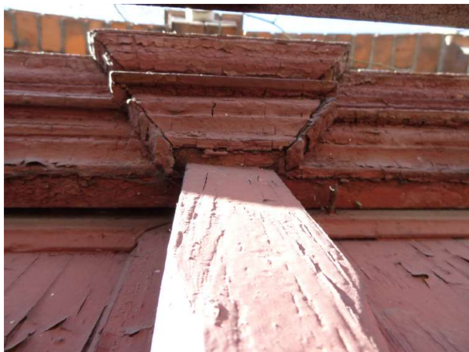
Fot. 4: Stolarka drzwiowa, typ D-13. Detal: belka ślepienna, listwa przymykowa. Źródło: Fotografia. Autorzy opracowania (OUTIN Architektura).
