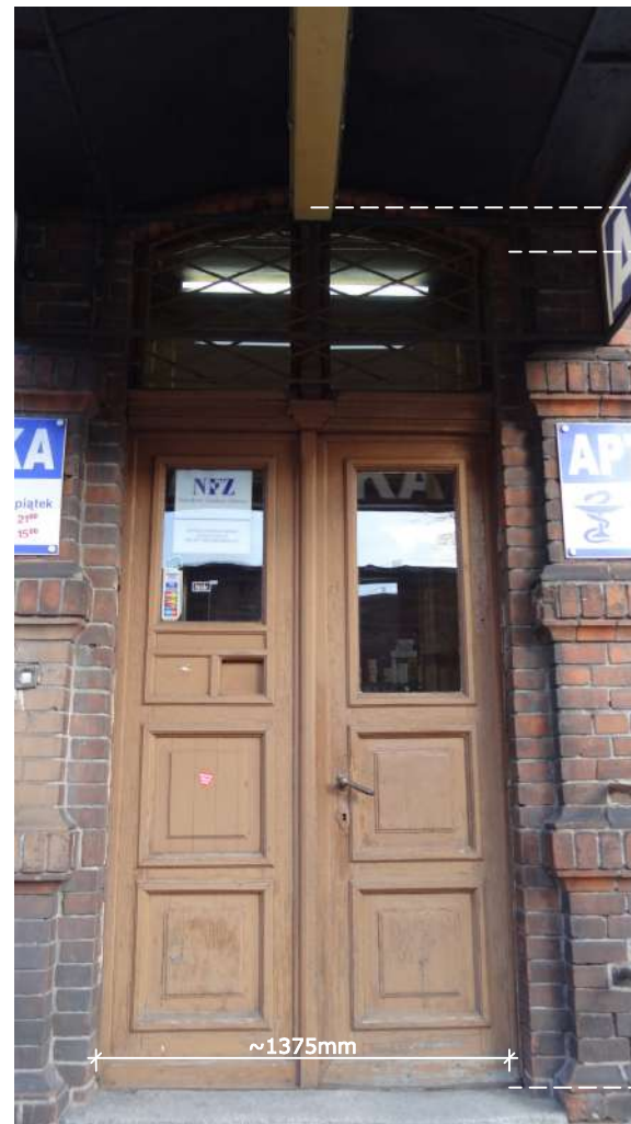
Fot. 1: Stolarka drzwiowa, typ D-16. Widok front (zewnątrzny) z podstawowymi wymiarami stolarki.
