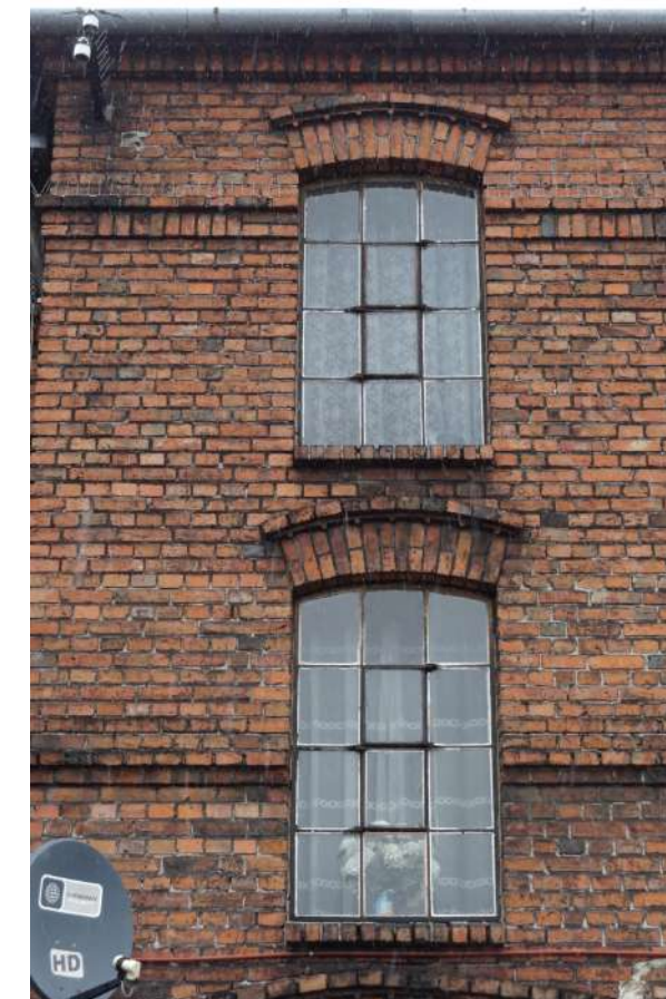
Fot. 3: Stolarka okienna, typ O-01. Fragment elewacji.
