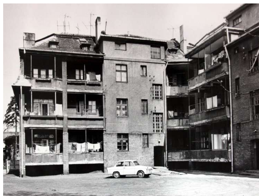
Fot. 5: Dom, ul. 1 Maja 59. Widok podwórza. Źródło: Fotografia. Dokumentacja Konserwatorska PKZ Warszawa 1976. Archiwum WUOZ w Warszawie.
