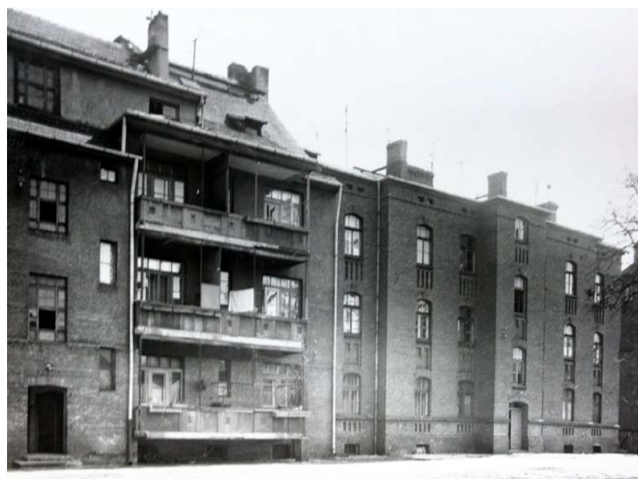
Fot. 3: Dom, ul. 1 Maja 57. Widok podwórza. Źródło: Fotografia. Dokumentacja Konserwatorska PKZ Warszawa 1976. Archiwum WUOZ w Warszawie.
