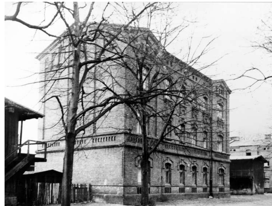
Fot. 4: Dom, ul. Ściegiennego 3.
