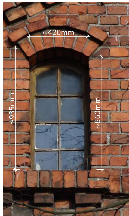
Fot. 1: Stolarka okienna, typ O-17. Widok z podstawowymi wymiarami stolarki (widok zewnętrzny).
