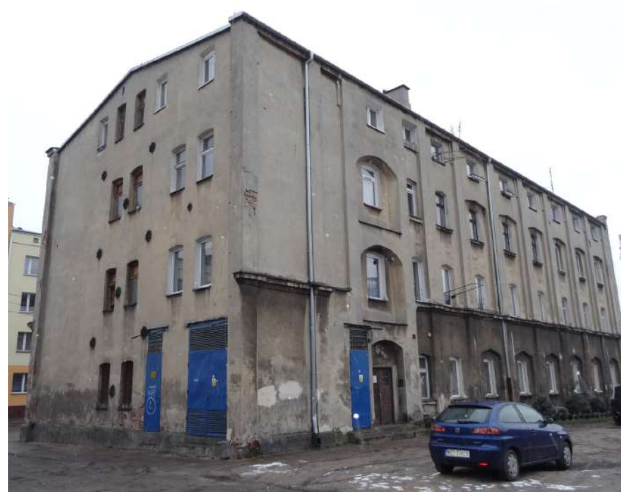
Fot. 2: Budynek przy ul. Mireckiego 70. Widok elewacji narożnik północno-wschodni.
