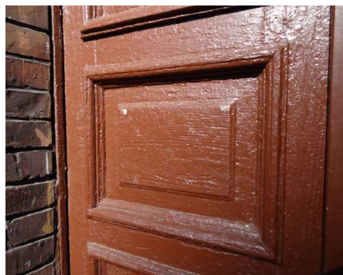
Fot. 2: Stolarka drzwiowa, typ D-04. Detal. Płycina środkowa. Widok zewnętrzny.
