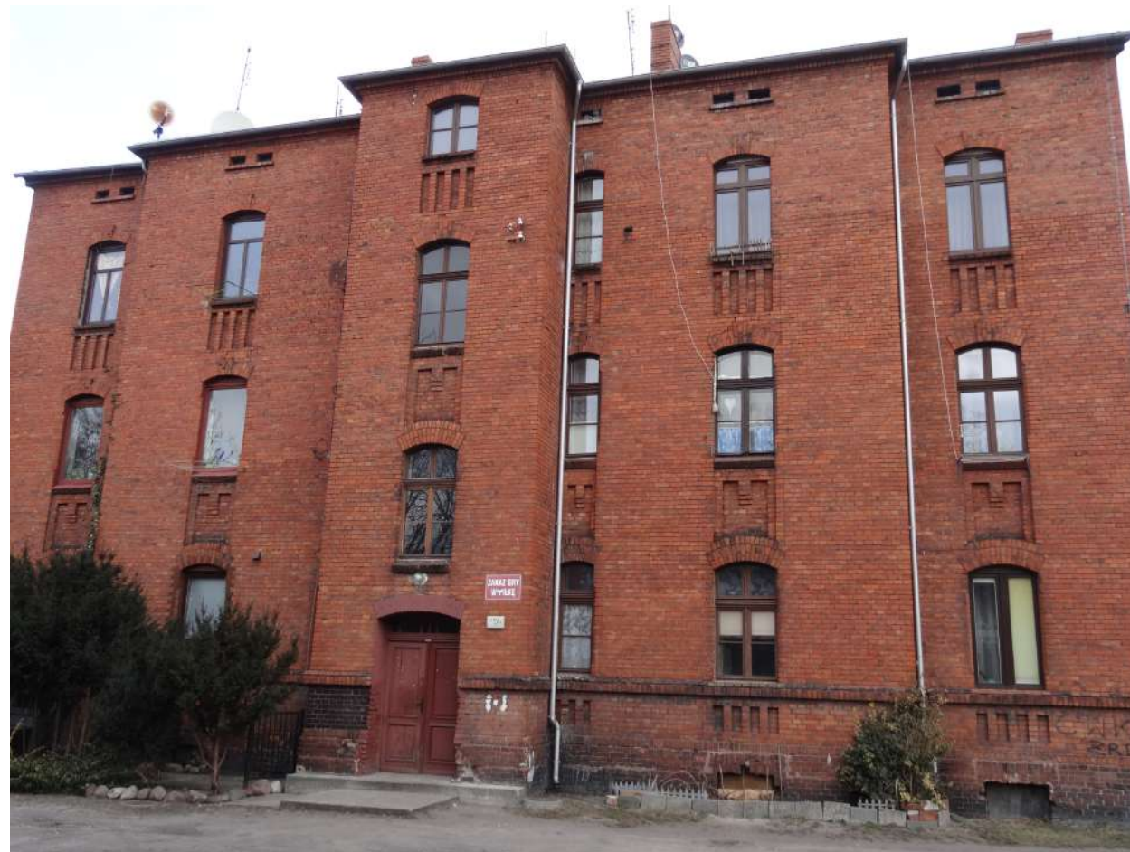
Fot. 1: Budynek przy ul. 1 Maja 55 - elewacja tylna z przykładem lokalizacji stolarki (od podwórza). Źródło: Fotografia. Autorzy opracowania (OUTIN Architektura).
