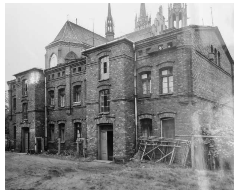
Fot. 5: Dom, ul. Wyszyńskiego 8. Widok elewacji od strony podwórza.
