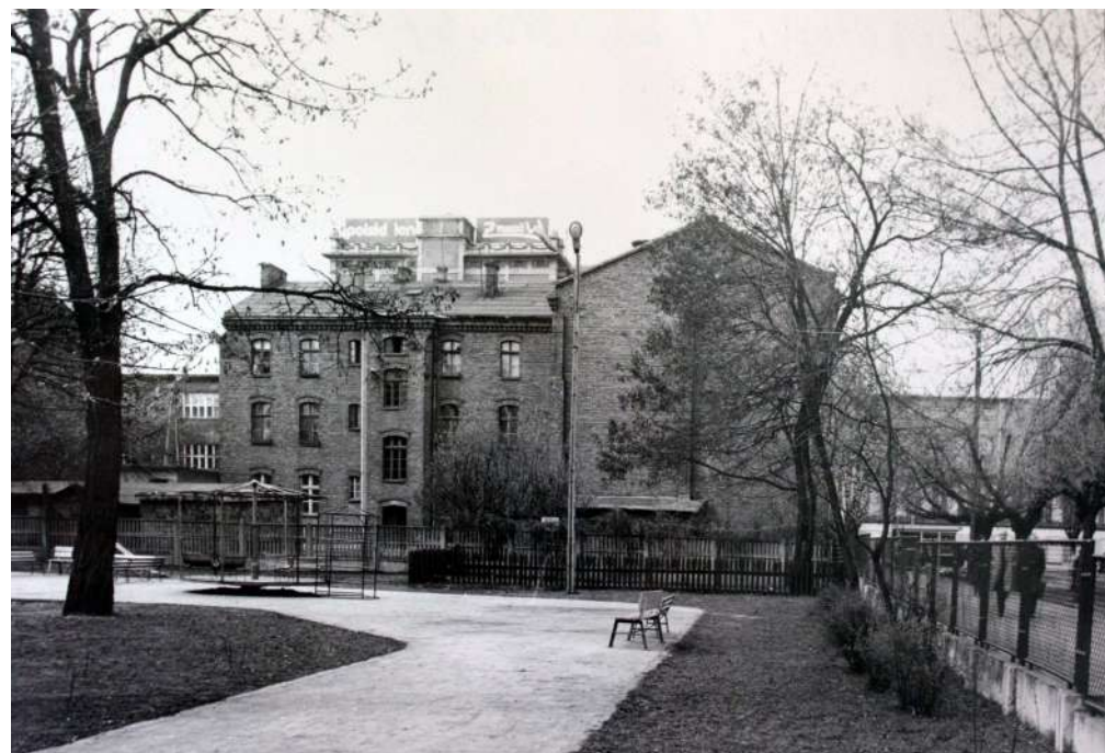
Fot. 4: Dom, ul. 1 Maja 54. Widok od strony podwórza. Źródło: Fotografia. Dokumentacja Konserwatorska PKZ Warszawa 1976. Archiwum WUOZ w Warszawie.
