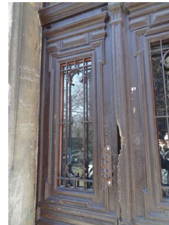
Fot. 6: Stolarka drzwiowa, typ D-02. Detal. Rzeźbiona dekoracja skrzydła: przeszlenie z kratą stalową. Źródło: Fotografia. Autorzy opracowania (OUTIN Architektura).
