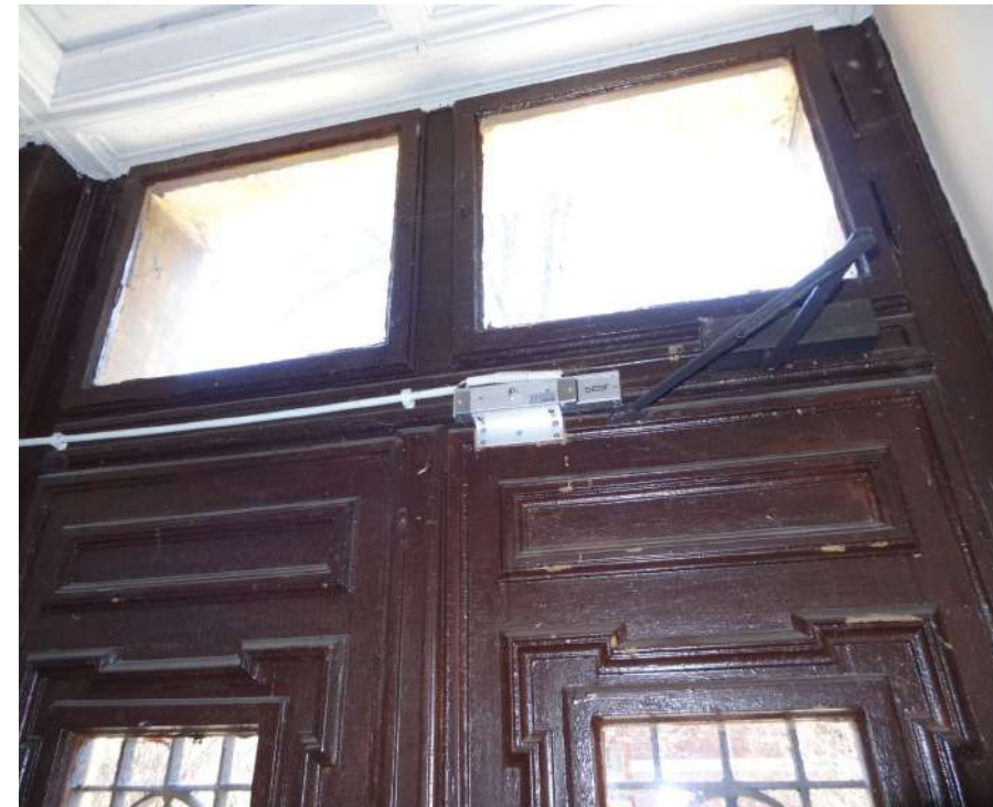
Fot. 2: Stolarka drzwiowa, typ D-02. Detal. Widok od wewnątrz. Naświetle z fragmentem skrzydła drzwiowego. Źródło: Fotografia. Autorzy opracowania (OUTIN Architektura).
