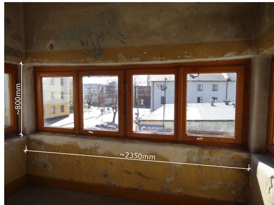
Fot. 1: Okno O-48 z podstawowymi wymiarami istniejącej stolarki okiennej. Widok od wewnątrz (otwór okienny w świetle muru). Źródło: Fotografia. Autorzy opracowania (OUTIN Architektura).
