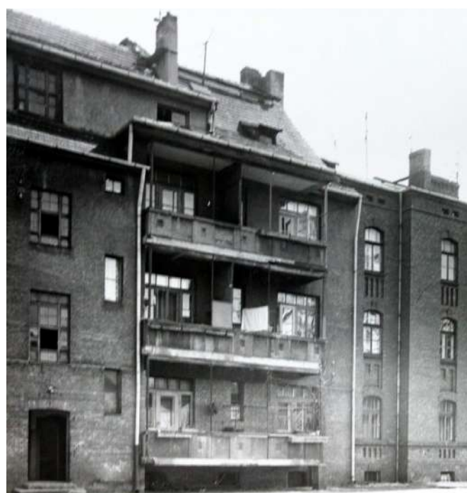
Fot. 3: Dom, ul. 1 Maja 59. Widok podwórza.
