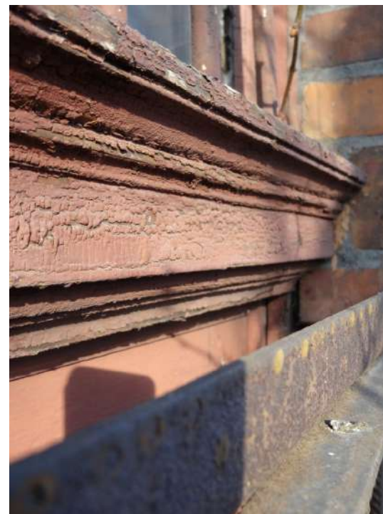
Fot. 2: Stolarka drzwiowa, typ D-13. Detal: belka ślepienna. Źródło: Fotografia. Autorzy opracowania (OUTIN Architektura).
