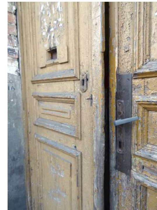
Fot. 3: Stolarka drzwiowa, typ D-01. Detal. Rzeźbiona dekoracja płyciny (filągu, kasetonu).
