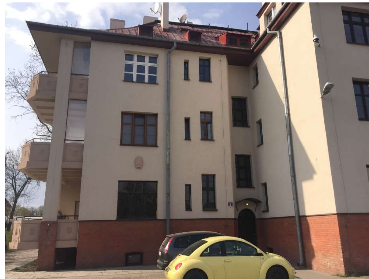
Fot. 2: Dom, ul. Farbiarska 2. Widok elewacji tylnej. Źródło: Fotografia. Autorzy opracowania (OUTIN Architektura).
