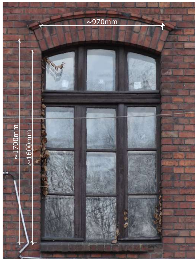
Fot. 1: Stolarka okienna, typ O-35. Widok z podstawowymi wymiarami stolarki (widok zewnętrzny). Źródło: Fotografia. Autorzy opracowania (OUTIN Architektura).
