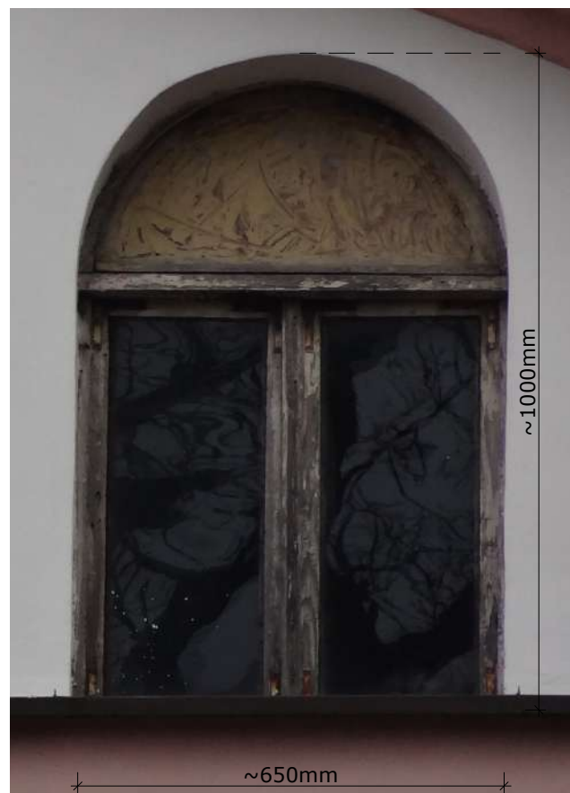
Fot. 2: Stolarka okienna, typ O-62. Widok z podstawowymi wymiarami stolarki. Źródło: Fotografia. Autorzy opracowania (OUTIN Architektura).
