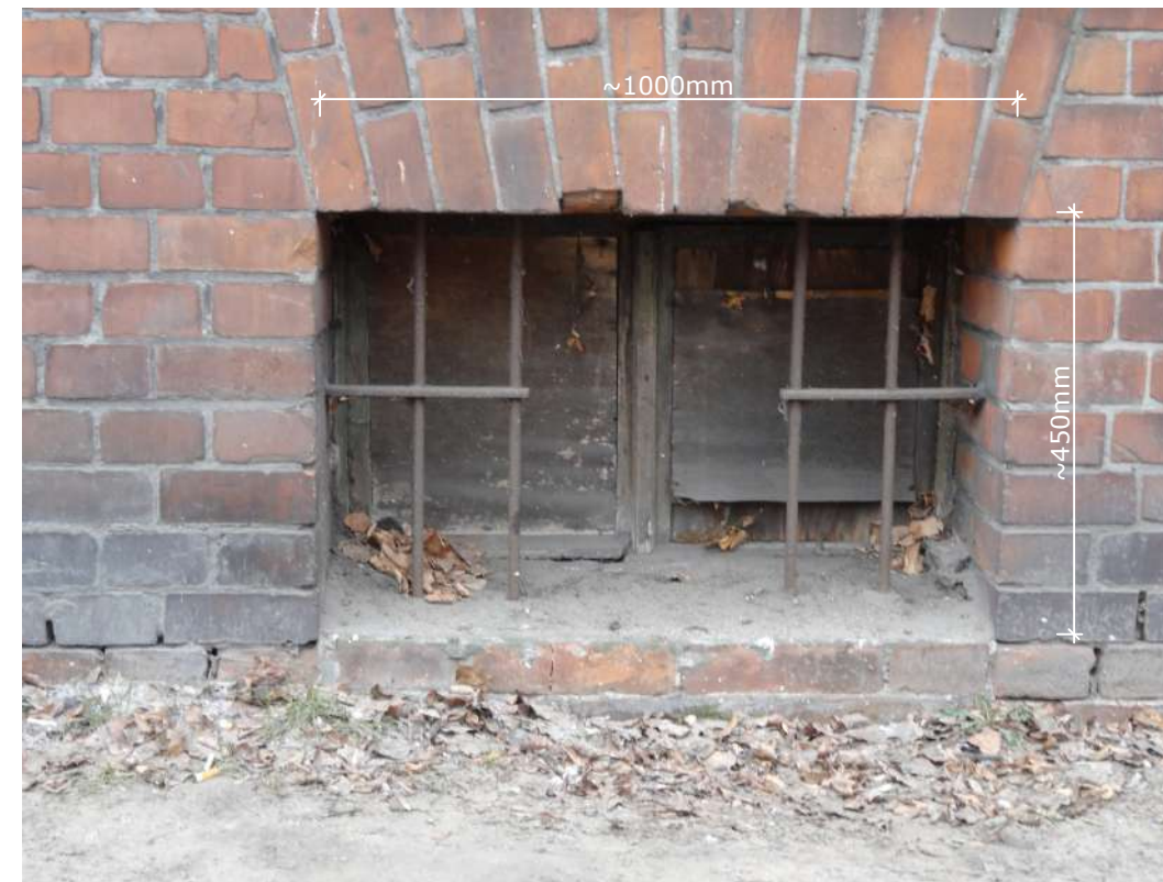
Fot. 2: Stolarka okienna, typ O-12. Widok z podstawowymi wymiarami stolarki (widok wewnętrzny).
