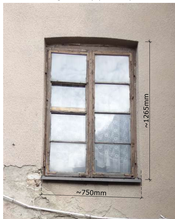
Fot. 2: Stolarka okienna, typ O-59. Widok z podstawowymi wymiarami stolarki. Źródło: Fotografia. Autorzy opracowania (OUTIN Architektura).
