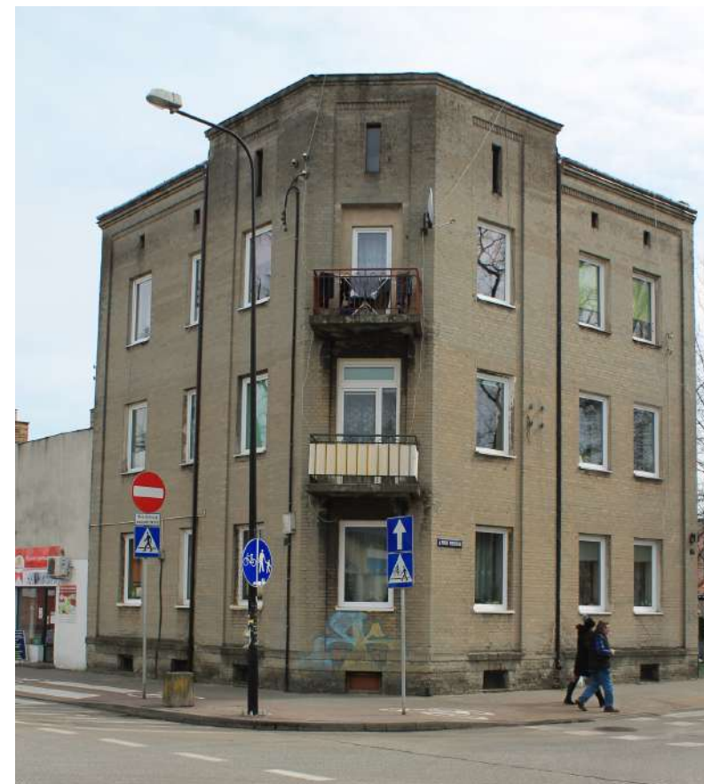
Fot. 3: Budynek przy ul. Wysockiego 28. Widok od strony ulicy
