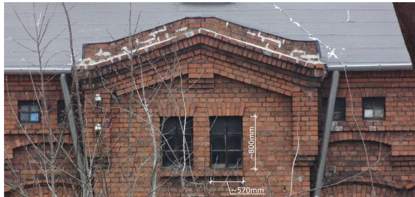
Fot. 1: Stolarka okienna, typ O-27. Widok z podstawowymi wymiarami stolarki (widok zewnętrzny).
