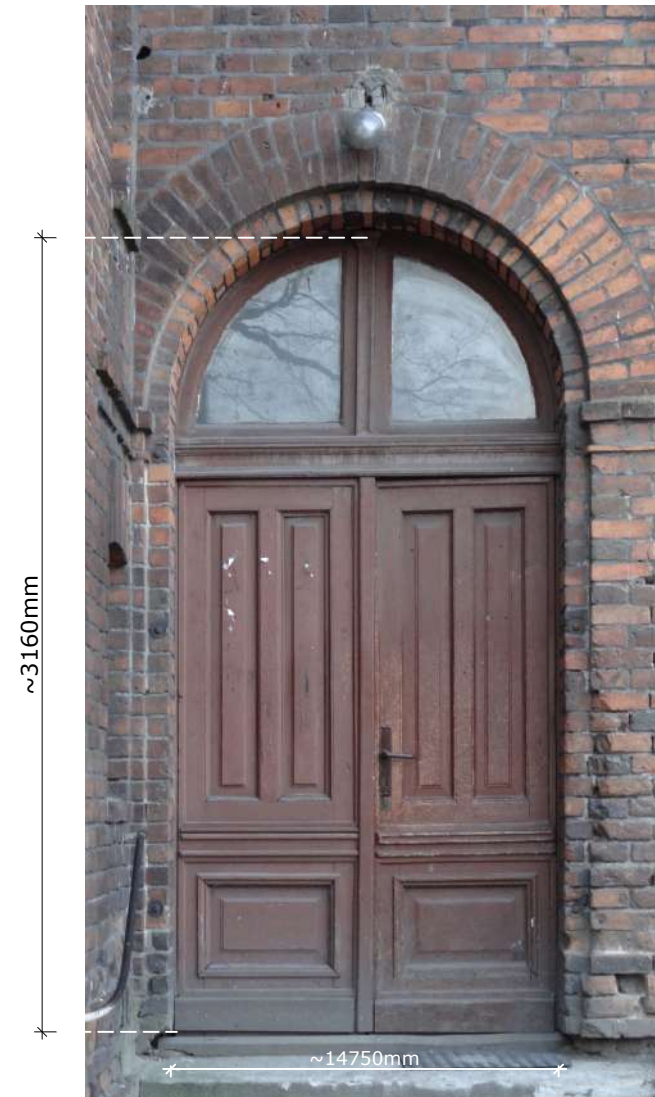
Fot. 1: Stolarka drzwiowa, typ D-05. Widok front (zewnątrzny) z podstawowymi wymiarami stolarki. Źródło: Fotografia. Autorzy opracowania (OUTIN Architektura).
