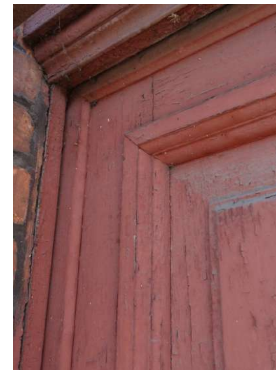
Fot. 6: Stolarka drzwiowa, typ D-13. Detal: pływina. Źródło: Fotografia. Autorzy opracowania (OUTIN Architektura).
