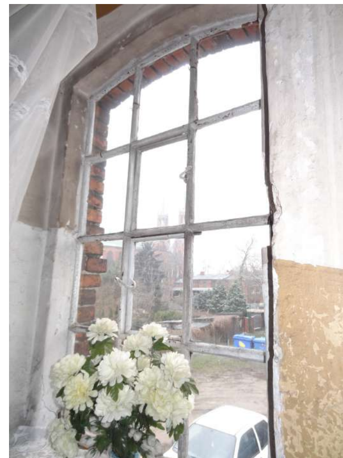
Fot. 2: Stolarka okienna, typ O-01. Widok wewnętrzny.
