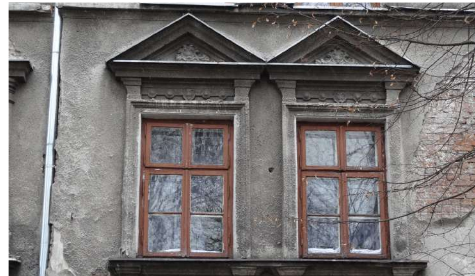
Fot. 5: Budynek, ul. Kościuszki 29. Widok obecny.
