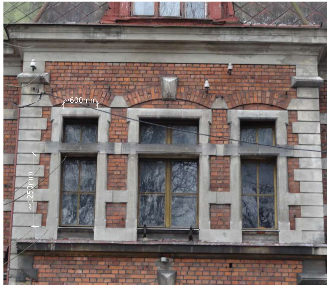
Fot. 1: Stolarka okienna, typ O-39. Widok z podstawowymi wymiarami stolarki (widok zewnętrzny). Źródło: Fotografia. Autorzy opracowania (OUTIN Architektura).
