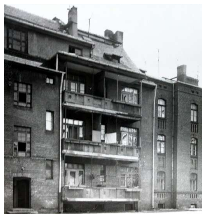
Fot. 3: Dom, ul. 1 Maja 59. Widok podwórza.
