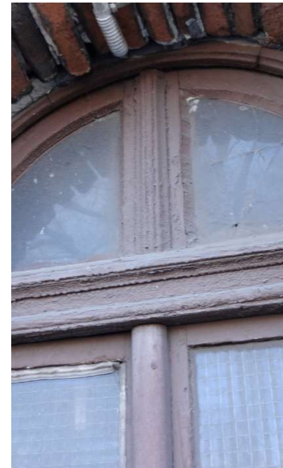
Fot. 3: Stolarka okienna, typ O-32. Detal. Źródło: Fotografia. Autorzy opracowania (OUTIN Architektura).
