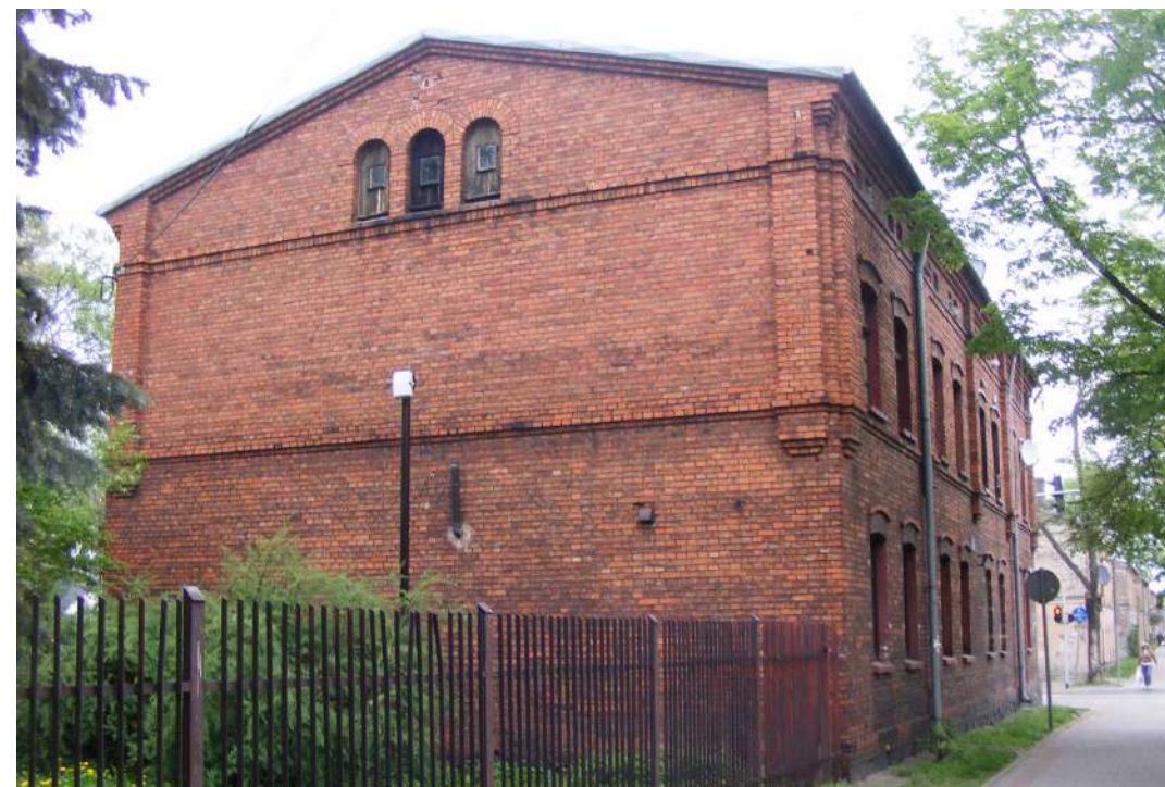
Fot. 2: Budynek, ul. Limanowskiego 28. Elewacja, ściana szczytowa.
