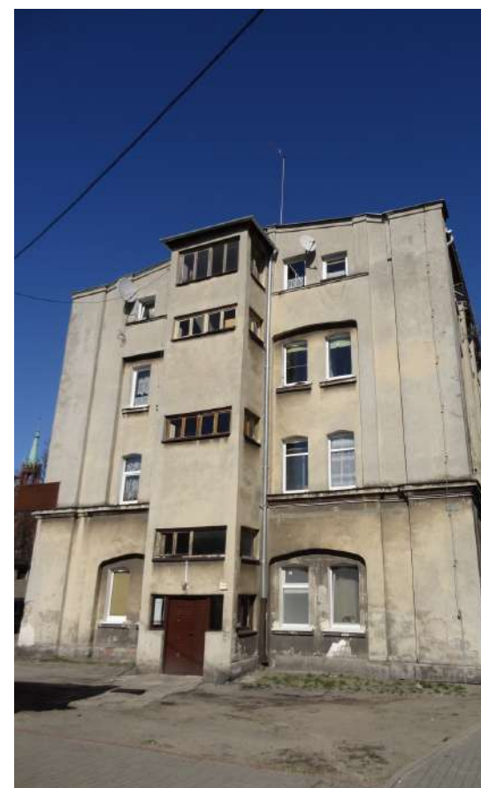
Fot. 2: Budynek przy ul. Mireckiego 70. Widok elewacji szczytowej.
