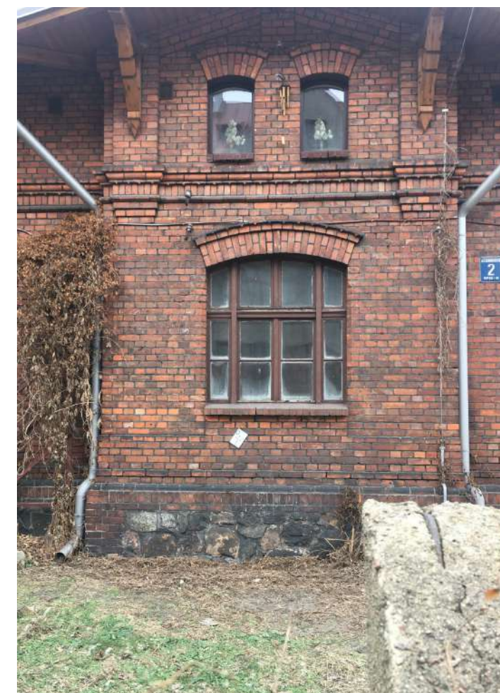
Fot. 4: Budynek, ul. Sławińskiego 2. Widok obecny.
