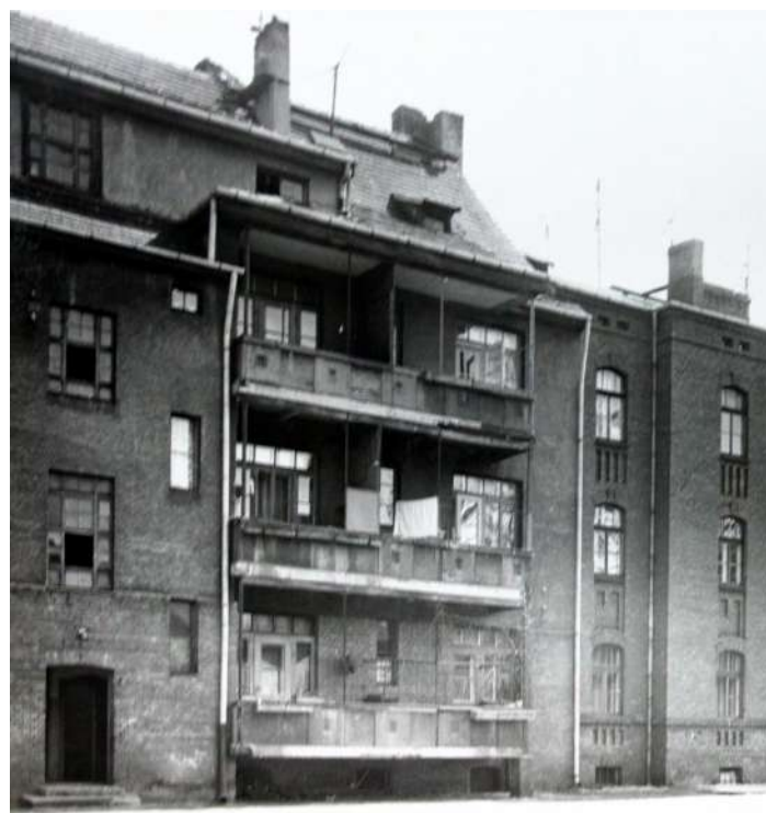
Fot. 2: Dom, ul. 1 Maja 59. Widok podwórza. Źródło: Fotografia. Dokumentacja Konserwatorska PKZ Warszawa 1976. Archiwum WUOZ w Warszawie.
