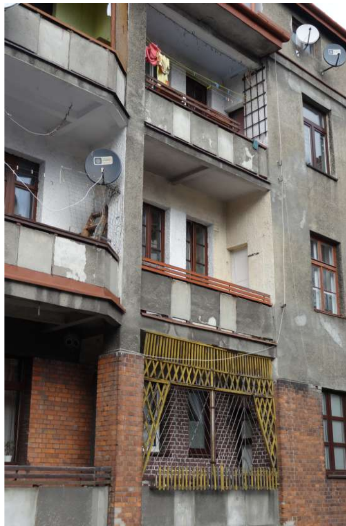
Fot. 1: Budynek przy ul. 1 Maja 59. Widok współczesny. Źródło: Fotografia. Autorzy opracowania (OUTIN Architektura).
