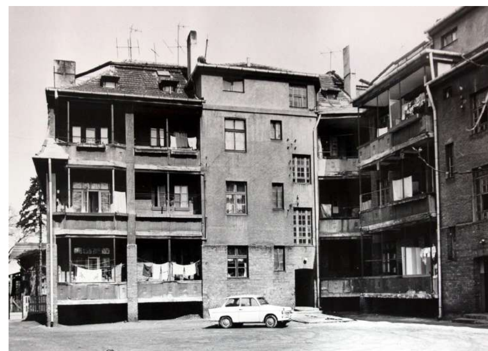
Fot. 4: Dom, ul. 1 Maja 59. Widok podwórza.
