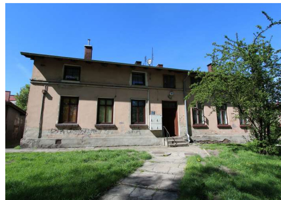
Fot. 4: Budynek, ul. 1 Kościuszki 22. Stan obecny.
