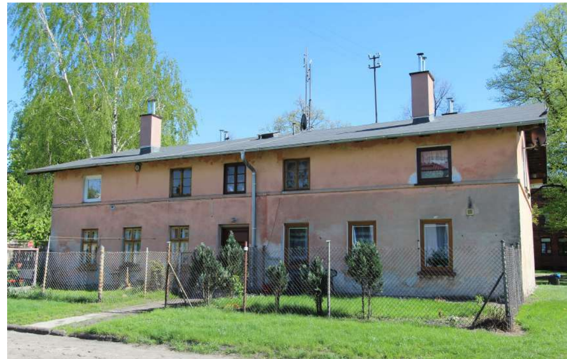
Fot. 2: Dom, ul. Kościuszki 18. Elewacja.
