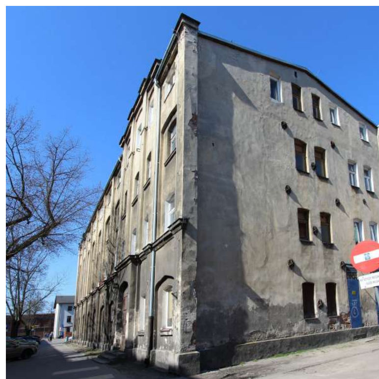
Fot. 2: Budynek przy ul. Mireckiego 70. Widok elewacji narożnik północno-wschodni.
