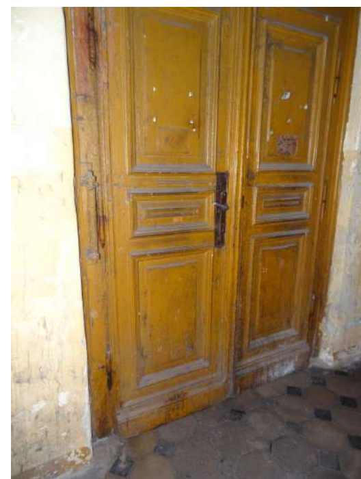
Fot. 3: Stolarka drzwiowa, typ D-01. Widok od wewnątrz.
