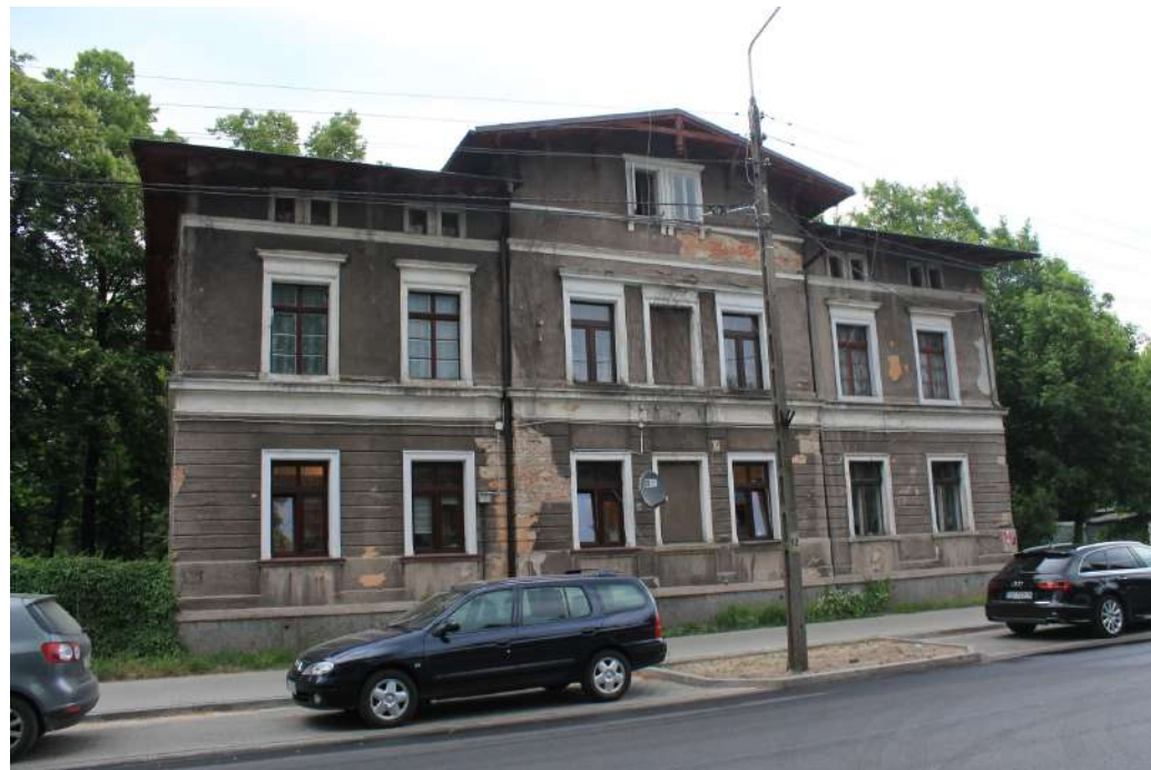
Fot. 1: Budynek przy ul. Żeromskiego 10. Elewacja południowa Źródło: Fotografia. Autorzy opracowania (OUTIN Architektura)
