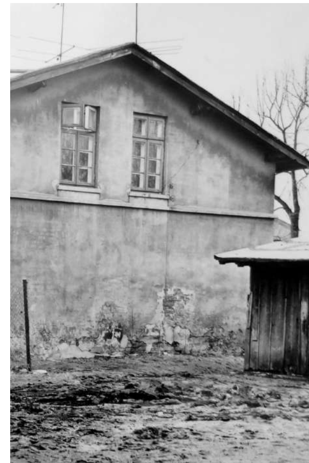
Fot. 3: Dom, ul. Kościuszki. Widok elewacji szczytowej.
