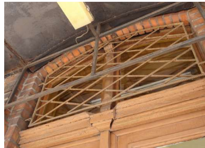
Fot. 2: Stolarka drzwiowa, typ D-16. Detal: naświetle ze słupkiem stałym, belka ślepienna.
