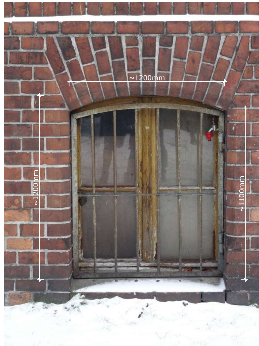
Fot. 1: Stolarka okienna, typ O-36. Widok z podstawowymi wymiarami stolarki (widok zewnętrzny).
