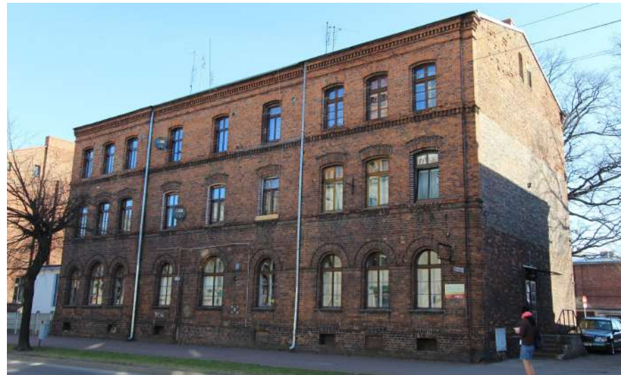
Fot. 1: Budynek, ul. 1 Maja 52. Fragment elewacji obecnie.
