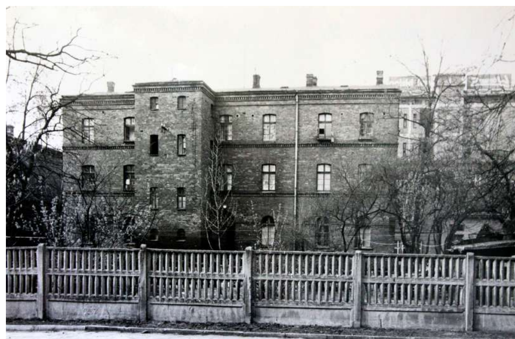
Fot. 3: Dom, ul. 1 Maja 52. Widok od strony podwórza. Źródło: Fotografia. Dokumentacja Konserwatorska PKZ Warszawa 1976. Archiwum WUOZ w Warszawie.
