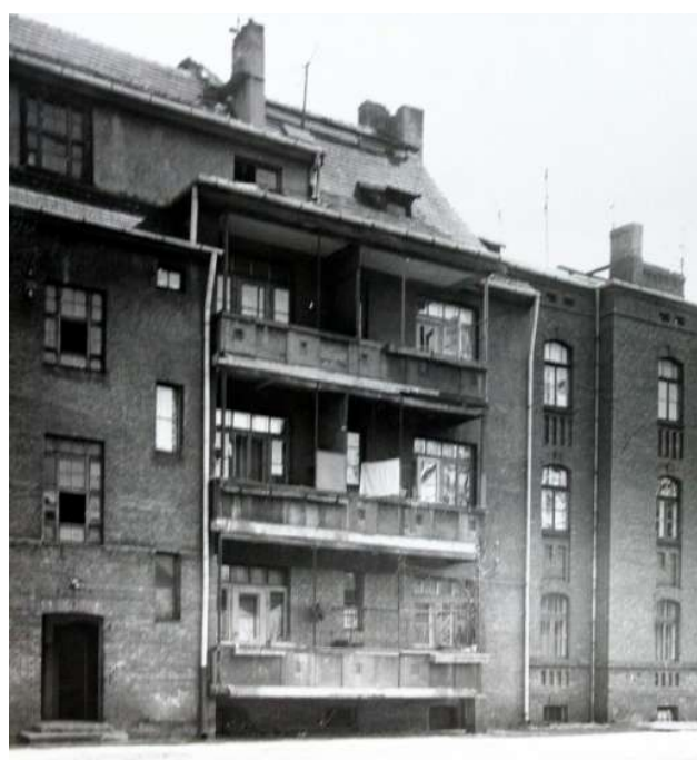
Fot. 4: Dom, ul. 1 Maja 59. Widok podwórza. Źródło: Fotografia. Dokumentacja Konserwatorska PKZ Warszawa 1976. Archiwum WUOZ w Warszawie.
