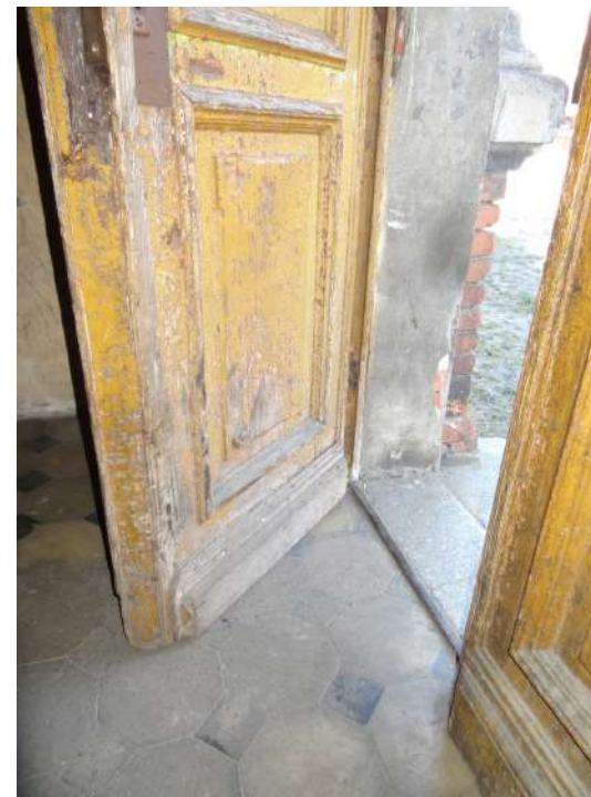
Fot. 2: Stolarka drzwiowa, typ D-01. Detal. Rzeźbiona dekoracja płyciny (filągu, kasetonu).
