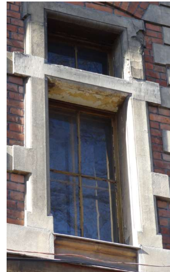
Fot. 2: Stolarka okienna, typ O-39. Widok. Źródło: Fotografia. Autorzy opracowania (OUTIN Architektura).
