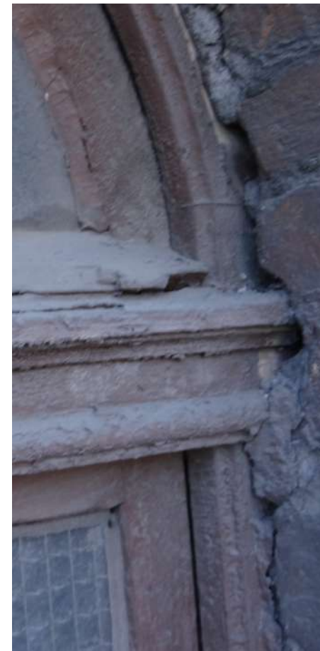
Fot. 2: Stolarka okienna, typ O-32. Detal. Źródło: Fotografia. Autorzy opracowania (OUTIN Architektura).
