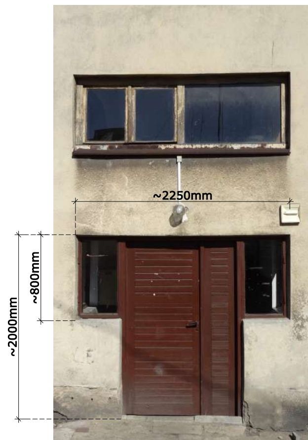
Fot. 1: Stolarka drzwiowa, typ D-20. Widok front (zewnątrzny) z podstawowymi wymiarami stolarki.
