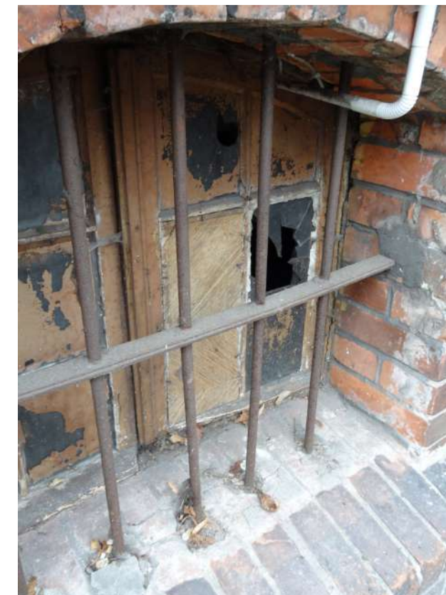
Fot. 2: Stolarka okienna, typ O-09. Detal. Źródło: Fotografia. Autorzy opracowania (OUTIN Architektura).
