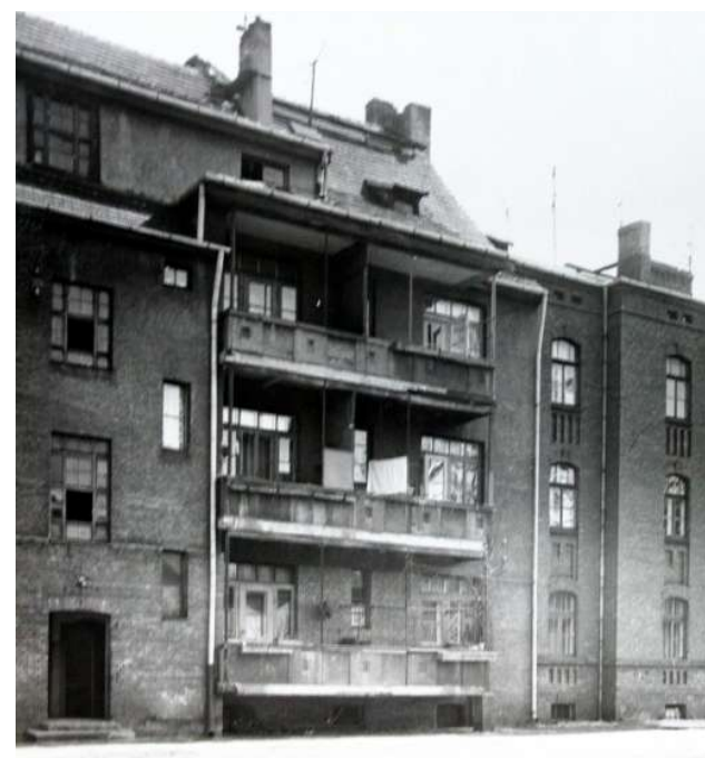
Fot. 3: Dom, ul. 1 Maja 59. Widok podwórza.
