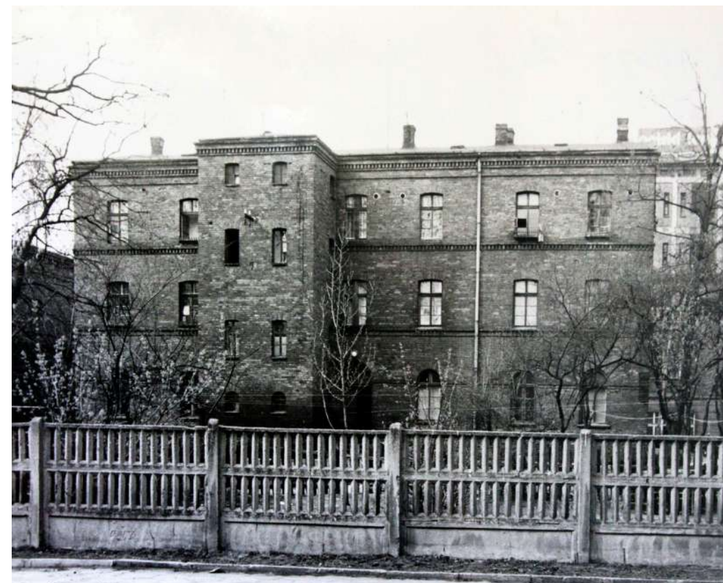
Fot. 4: Dom, ul. 1 Maja 52. Widok od strony podwórza. Źródło: Fotografia. Dokumentacja Konserwatorska PKZ Warszawa 1976. Archiwum WUOZ w Warszawie.
