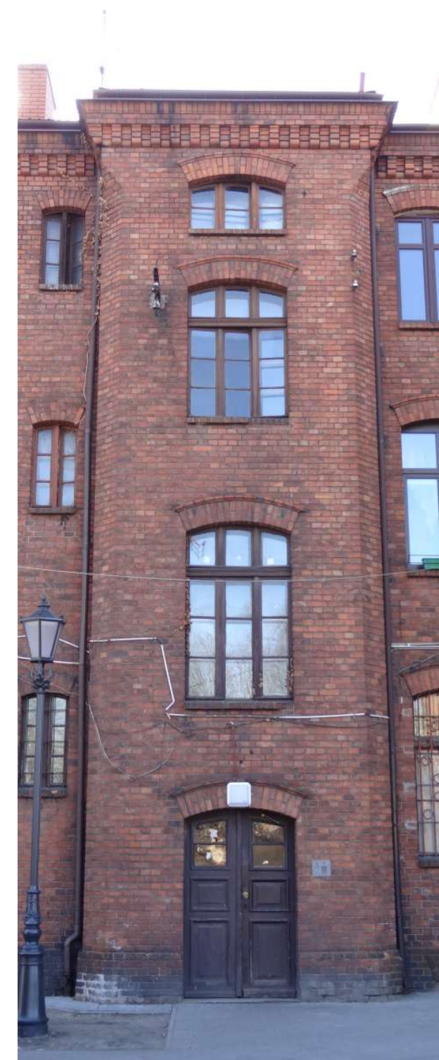
Fot. 3: Budynek, ul. 1 Maja 54. Fragment elewacji obecnie.
