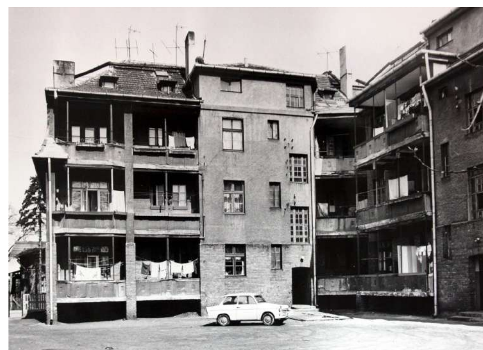
Fot. 4: Dom, ul. 1 Maja 59. Widok podwórza.
