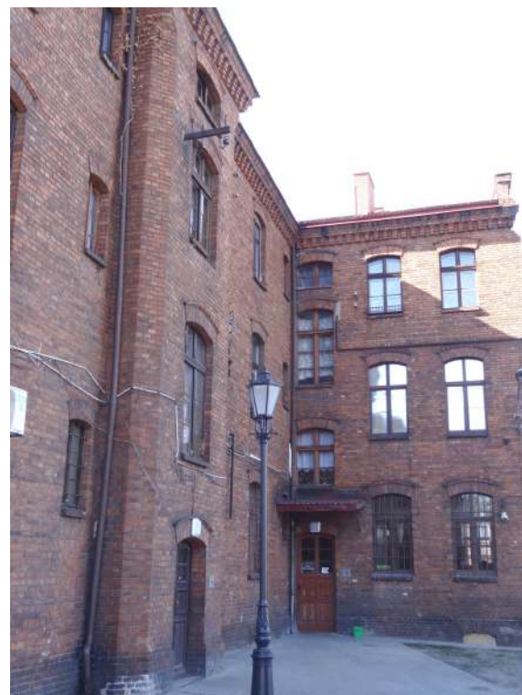
Fot. 3: Stolarka drzwiowa, typ D-07. Fragment elewacji budynku przy ul. 1 Maja 54 z lokalizacją stolarki. Widok od strony podwórza.
