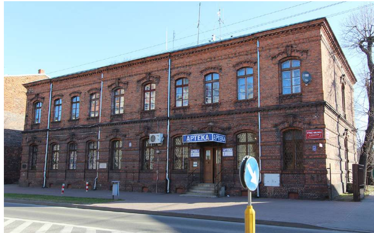
Fot. 1: Budynek, ul. 1 Maja 50. Elewacja frontowa.
