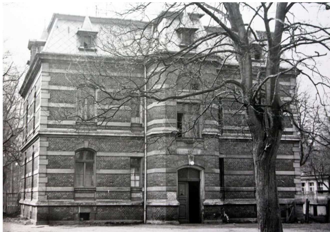
Fot. 3: Willa, stolarka drzwiowa, ul. Związku Walki Młodych 4 (obecnie Armii Krajowej). Widok od pd.-wsch.
