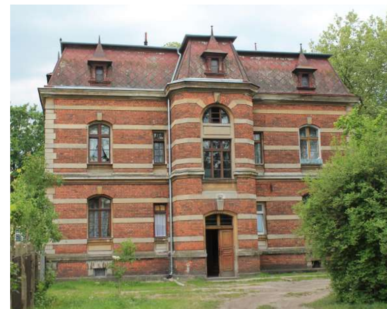
Fot. 6: Budynek, ul. Armii Krajowej 4 - widok współczesny.
