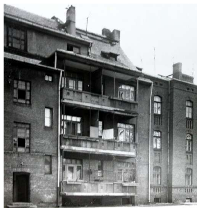
Fot. 3: Dom, ul. 1 Maja 59. Widok podwórza.
