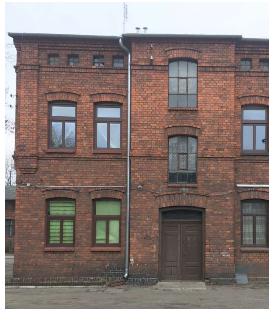
Fot. 2: Stolarka okienna, typ O-30. Widok. Źródło: Fotografia. Autorzy opracowania (OUTIN Architektura).
