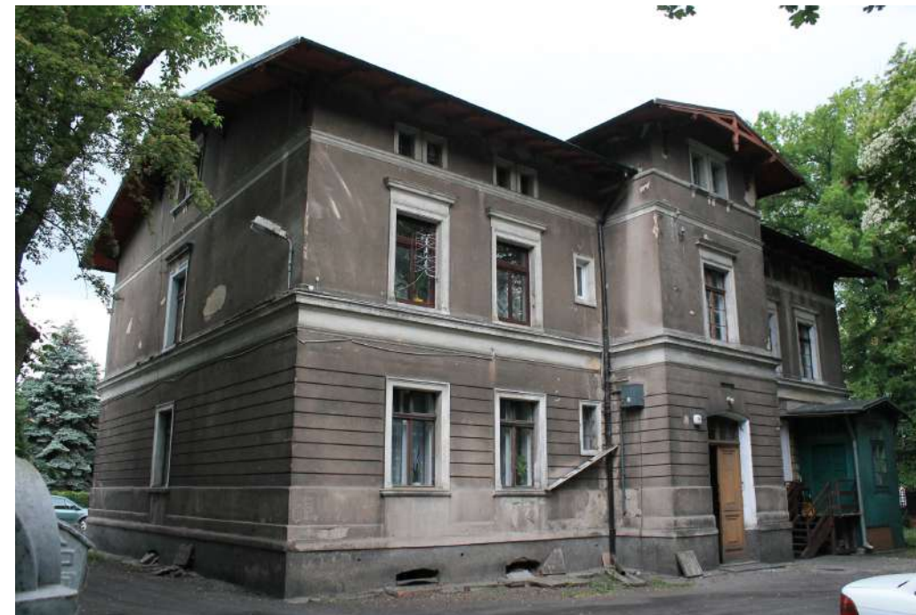
Fot. 2: Budynek przy ul. Żeromskiego 10. Elewacja północna Źródło: Fotografia. Autorzy opracowania (OUTIN Architektura)
