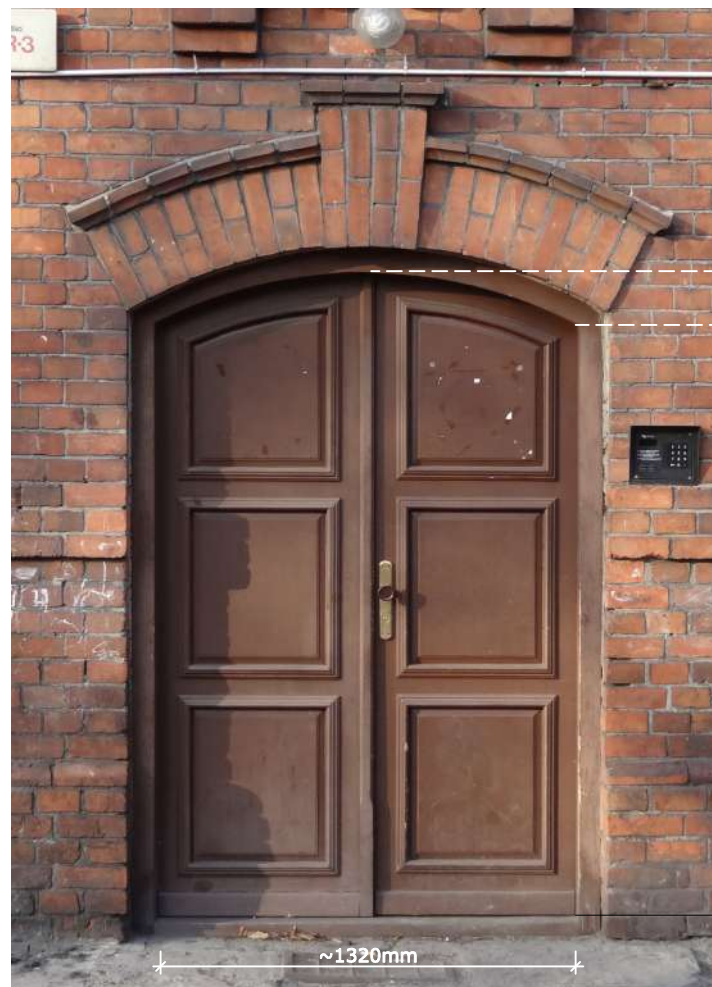
Fot. 1: Stolarka drzwiowa, typ D-11. Widok front (zewnętrzny) z podstawowymi wymiarami stolarki.
