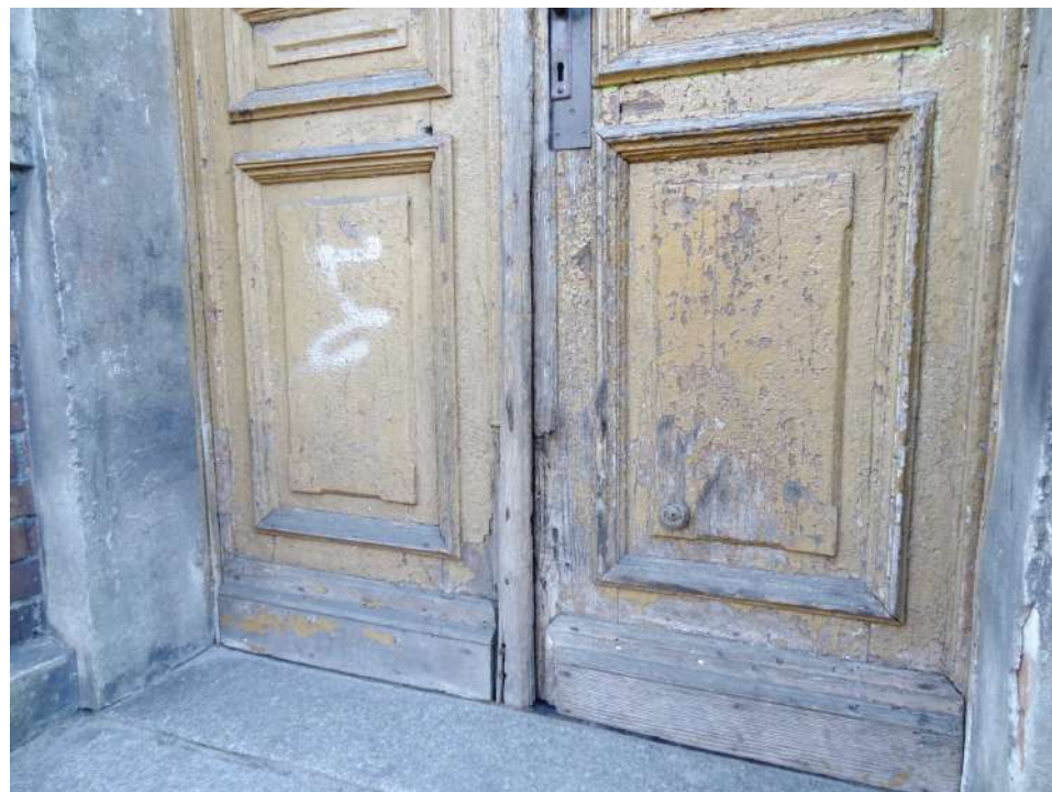
Fot. 4: Stolarka drzwiowa, typ D-01. Detal. Rzeźbiona dekoracja płyciny (filągu, kasetonu).
