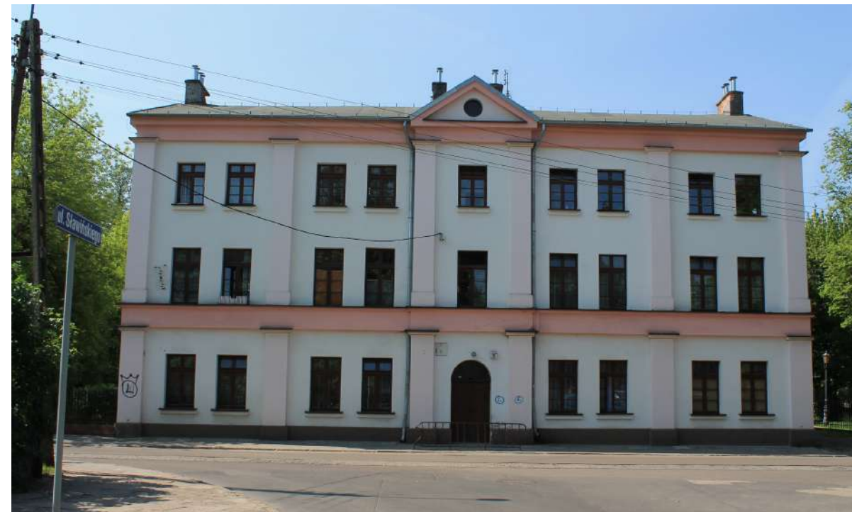
Fot. 4: Budynek, ul. Ditttricha 3. Stan obecny.
