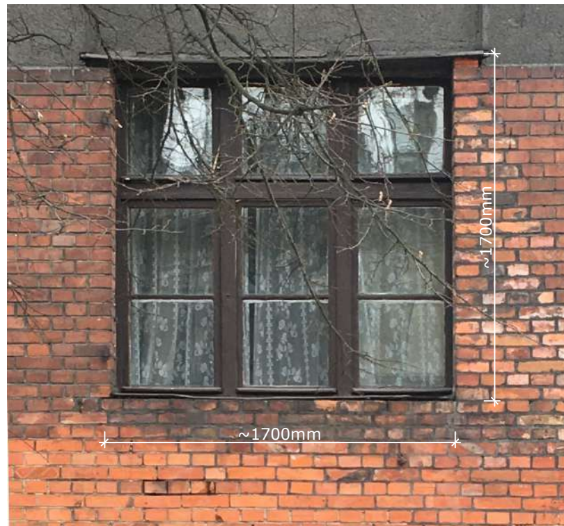
Fot. 1: Stolarka okienna, typ O-29. Widok z podstawowymi wymiarami stolarki (widok zewnętrzny).
