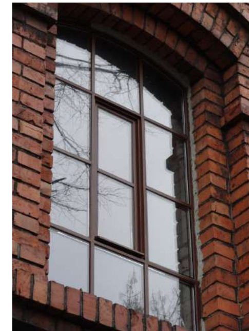
Fot. 3: Stolarzka okienna, typ O-01. Przykład wymienionej stolarzki okiennej z odtworzeniem podziałów.
