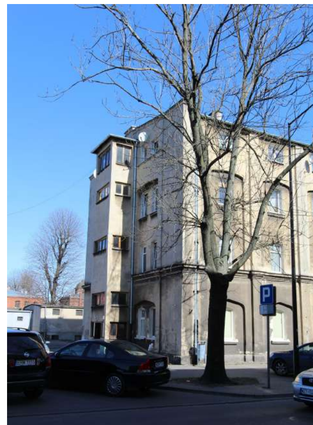
Fot. 3: Budynek przy ul. Mireckiego 70 - narożnik południowo-zachodni z przykładem lokalizacji stolarki. Widok współczesny.
