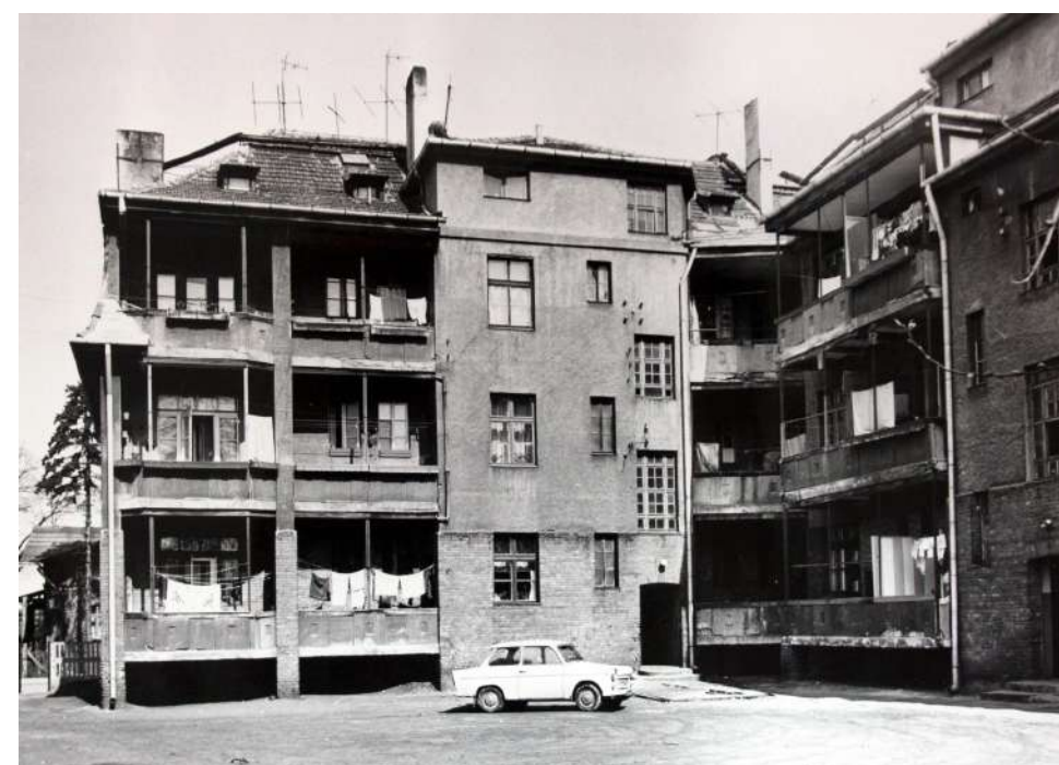
Fot. 4: Dom, ul. 1 Maja 59. Widok podwórza.
