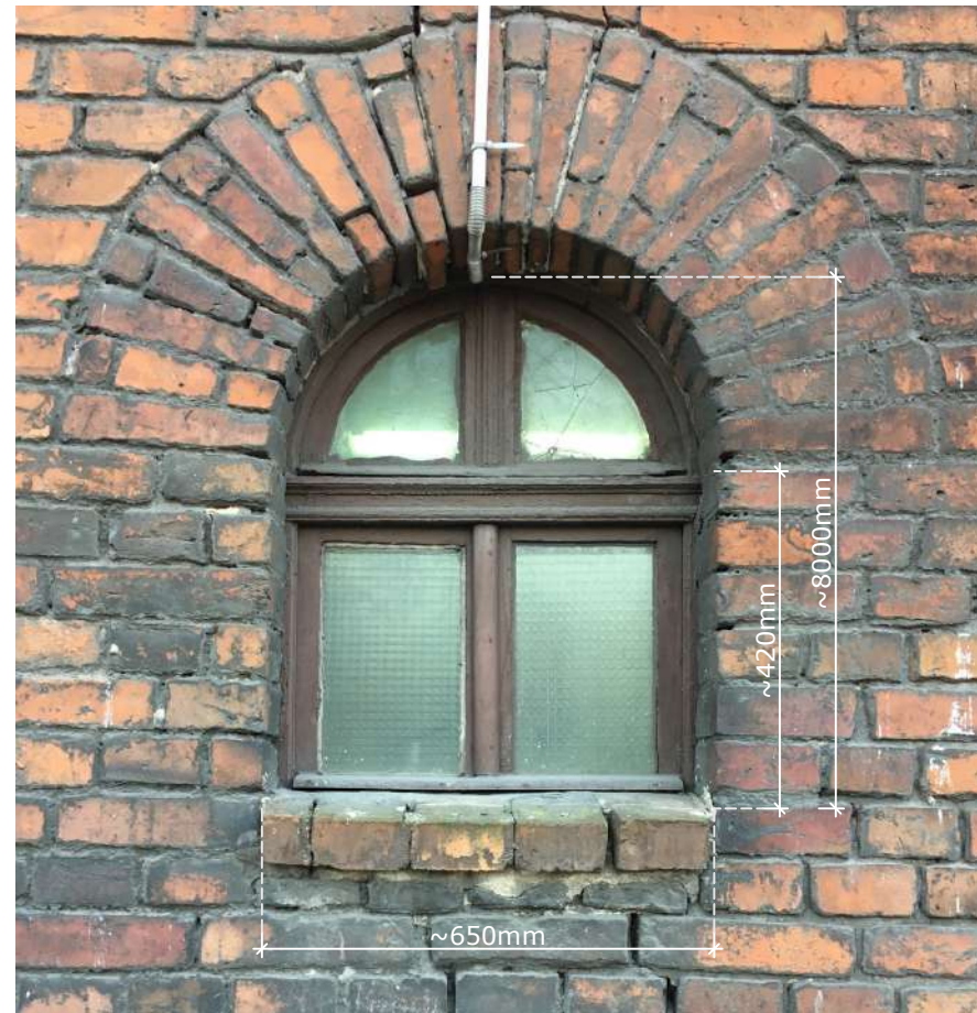
Fot. 1: Stolarka okienna, typ O-32. Widok z podstawowymi wymiarami stolarki (widok zewnętrzny). Źródło: Fotografia. Autorzy opracowania (OUTIN Architektura).
