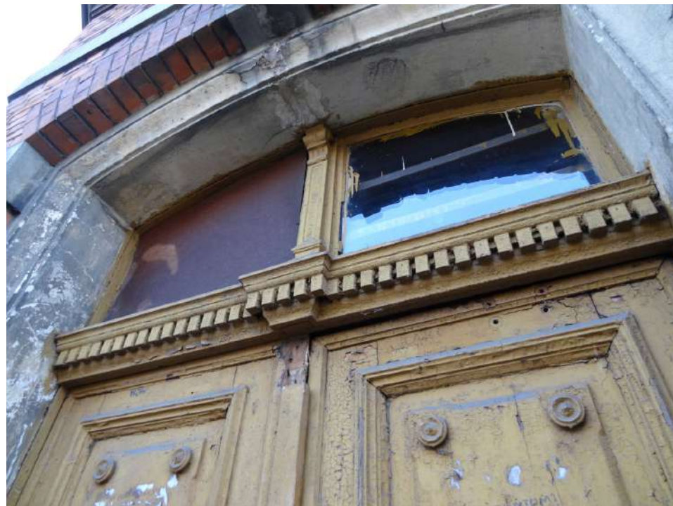
Fot. 1: Stolarka drzwiowa, typ D-01. Detal. Rzeźbiona dekoracja płyciny, belki ślimiennej i stałego słupka naswietla.
