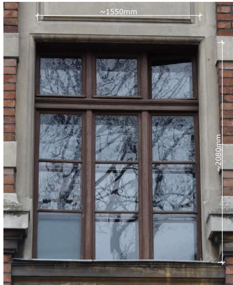
Fot. 1: Stolarka okienna, typ O-24. Widok z podstawowymi wymiarami stolarki (widok zewnętrzny).
