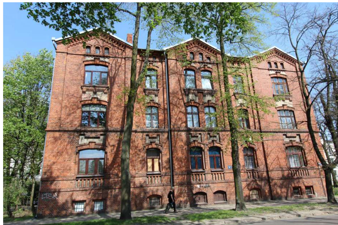
Fot. 2: Dom, ul. Żymirskiego 4 (obecna Kościelna). Źródło: Fotografia. Dokumentacja Konserwatorska PKZ Warszawa 1976. Archiwum WUOZ w Warszawie.
