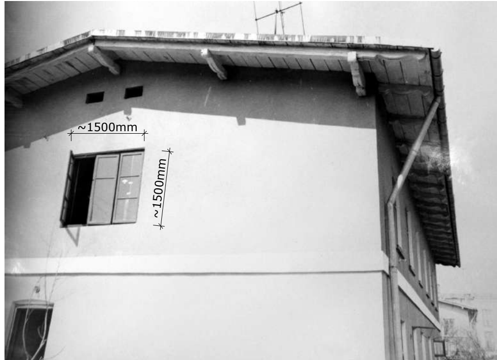
Fot. 1: Dom, ul. 1 Maja 66. Widok elewacji szczytowej; południowa. Okno typ O-53. Źródło: Fotografia. Dokumentacja Konserwatorska PKZ Warszawa 1976. Archiwum WUOZ w Warszawie.
