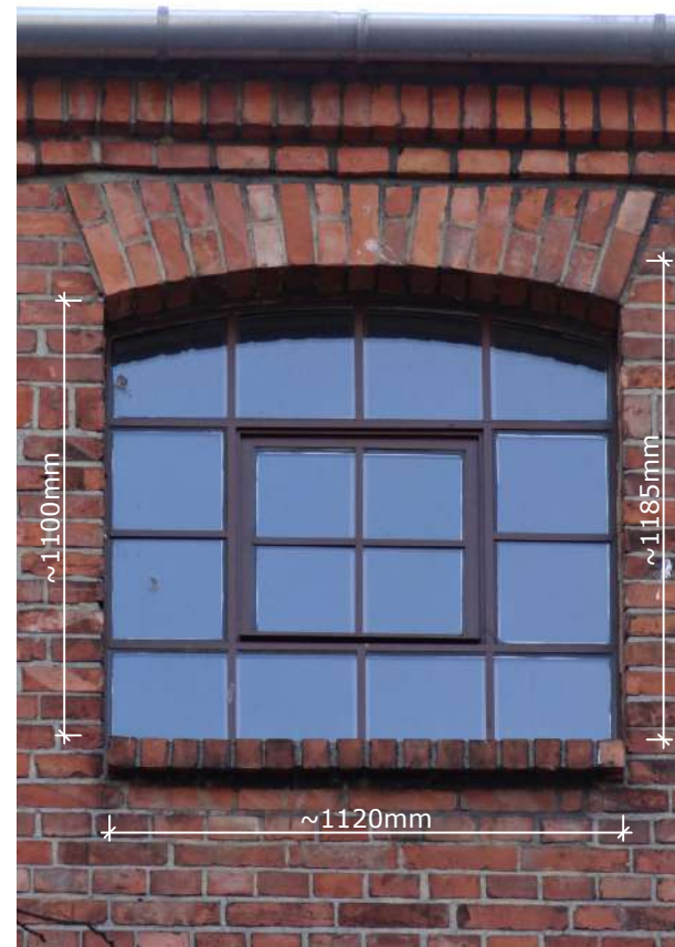
Fot. 1: Stolarka okienna, typ O-11. Widok z podstawowymi wymiarami stolarki (widok zewnętrzny).
