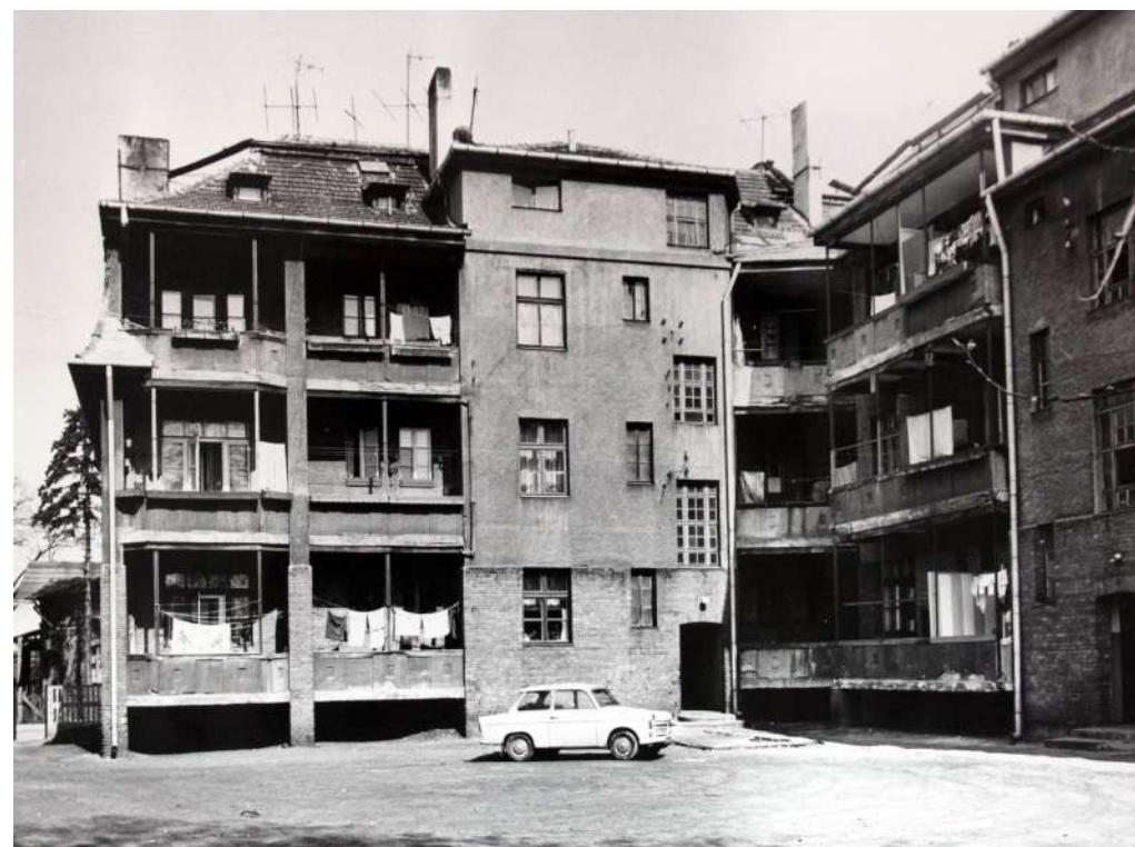
Fot. 3: Dom, ul. 1 Maja 59. Widok podwórza. Źródło: Fotografia. Dokumentacja Konserwatorska PKZ Warszawa 1976. Archiwum WUOZ w Warszawie.
