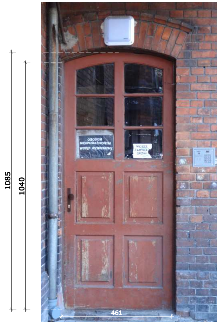
Fot. 1: Stolarka drzwiowa, typ D-07. Widok front (zew.) z podstawowymi wymiarami stolarki.
