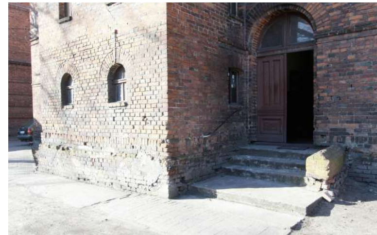
Fot. 2: Stolarka drzwiowa, typ D-05. Fragment elewacji budynku z lokalizacją stolarki. Widok od strony podwórza. Źródło: Fotografia. Autorzy opracowania (OUTIN Architektura).
