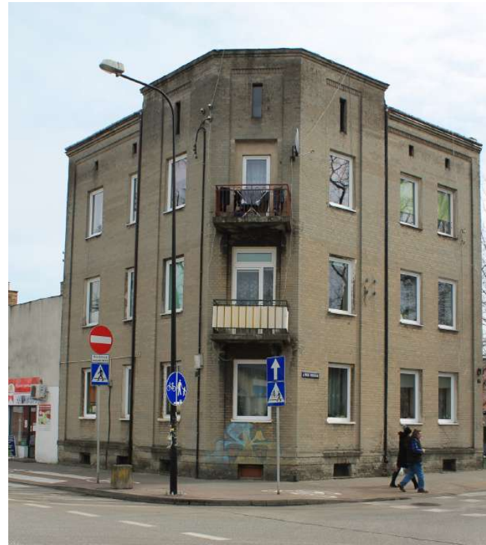
Fot. 2: Budynek przy ul. Wysockiego 28. Widok od strony ulicy
