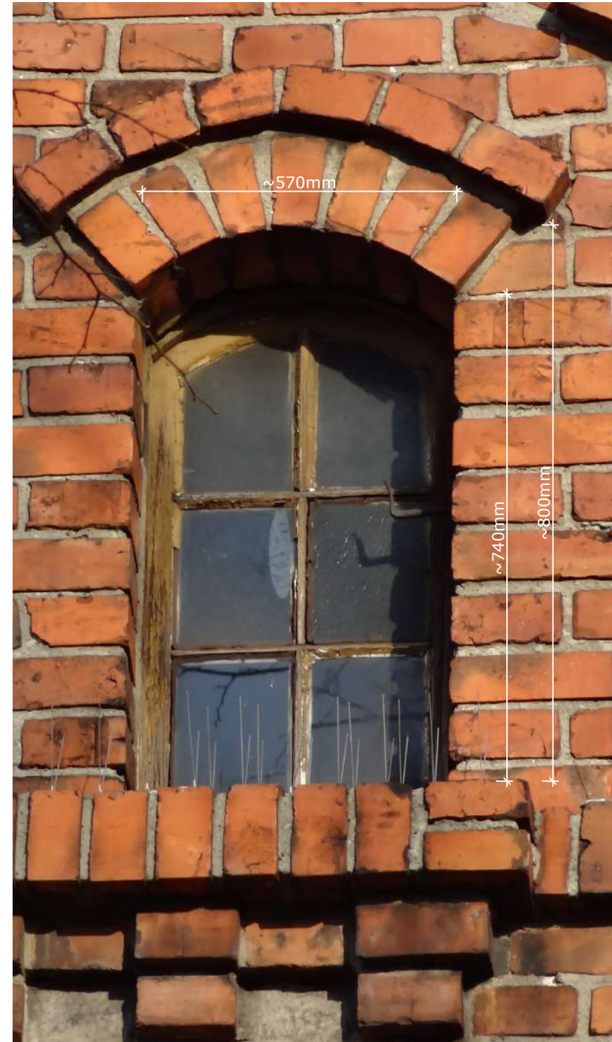
Fot. 3: Stolarka okienna, typ O-23. Widok z podstawowymi wymiarami stolarki (widok zewnętrzny). Źródło: Fotografia. Autorzy opracowania (OUTIN Architektura).
