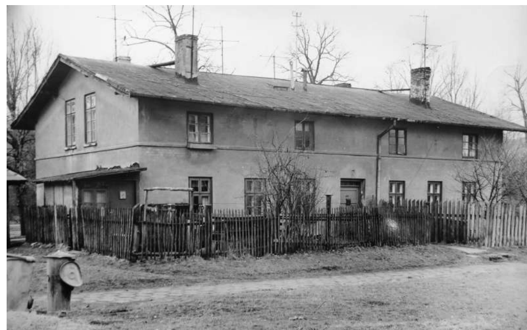
Fot. 3: Dom, ul. Kościuszki. Widok elewacji.
