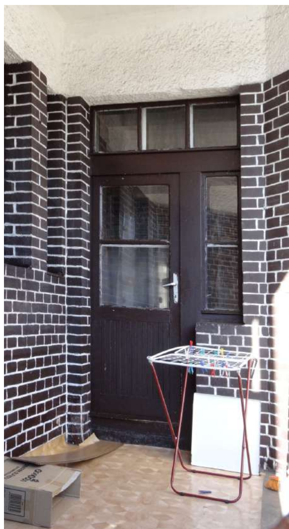
Fot. 1: Stolarka drzwiowa, typ D-17. Widok front (zewnątrzny). Źródło: Fotografia. Autorzy opracowania (OUTIN Architektura).
