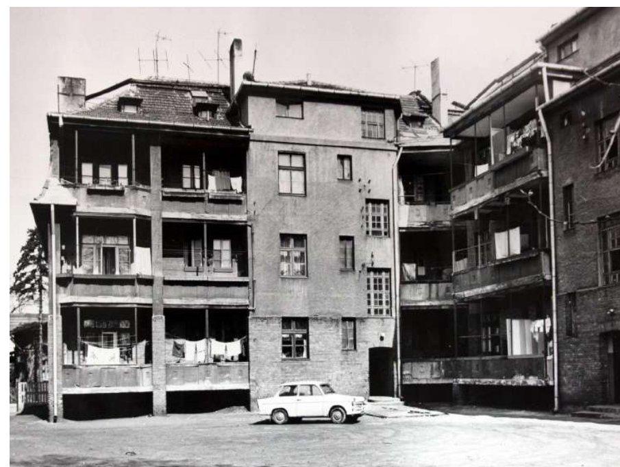
Fot. 4: Dom, ul. 1 Maja 59. Widok podwórza.
