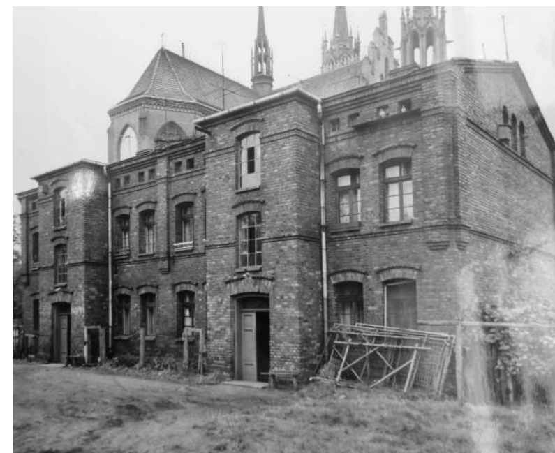
Fot. 6: Dom, ul. Wyszyńskiego 8. Widok elewacji od strony podwórza.
