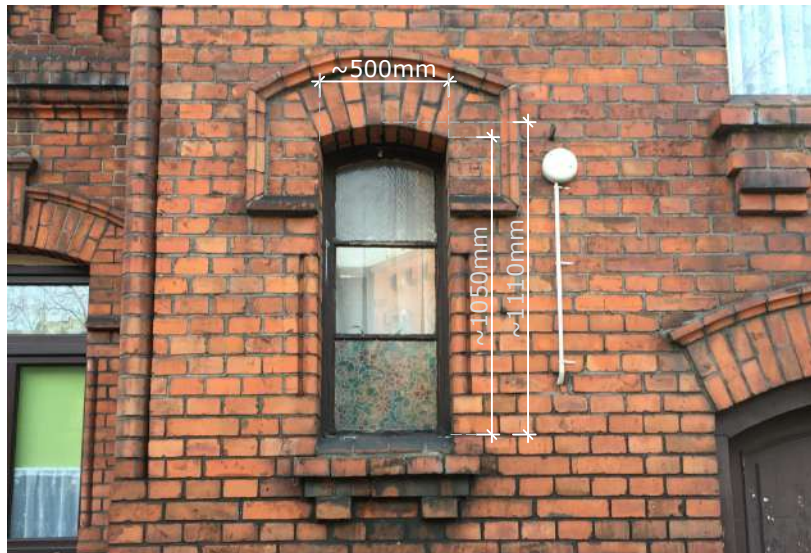
Fot. 1: Stolarka okienna, typ O-40. Widok z podstawowymi wymiarami stolarki (widok zewnętrzny).
