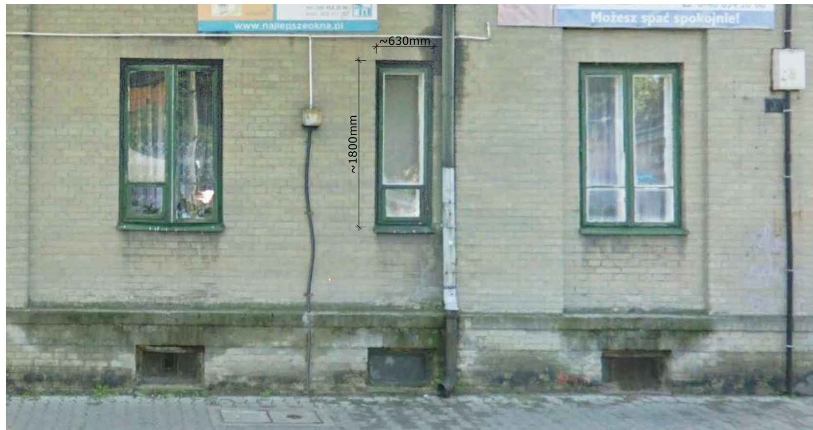
Fot. 3: Stolarka okienna, typ O-66. Widok z podstawowymi wymiarami stolarki. Źródło: Google Street View. Wrzesień 2012r.
