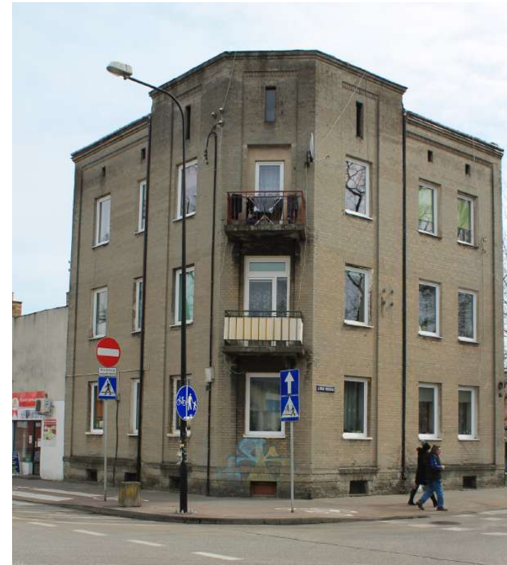
Fot. 2: Budynek przy ul. Wysockiego 28. Widok od strony ulicy Źródło: Fotografia. Autorzy opracowania (OUTIN Architektura). Wrzesień 2018
