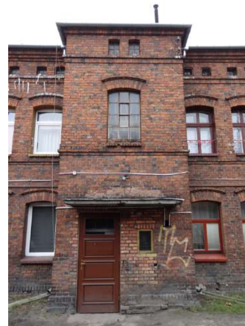
Fot. 2: Budynek, ul. Kościuszki. Stan obecny.
