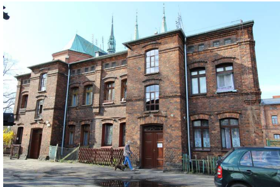
Fot. 1: Budynek, ul. Wysińskiego 8. Stan obecny. Stolarzka okienna wymieniona z odtworzeniem podziałów i gabarytów profili.
