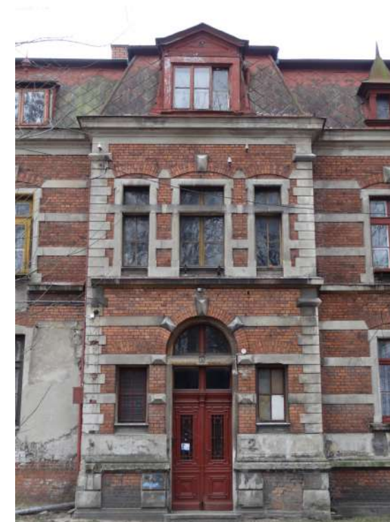
Fot. 4: Stolarka okienna, typ O-39. Fragment elewacji. Źródło: Fotografia. Autorzy opracowania (OUTIN Architektura).
