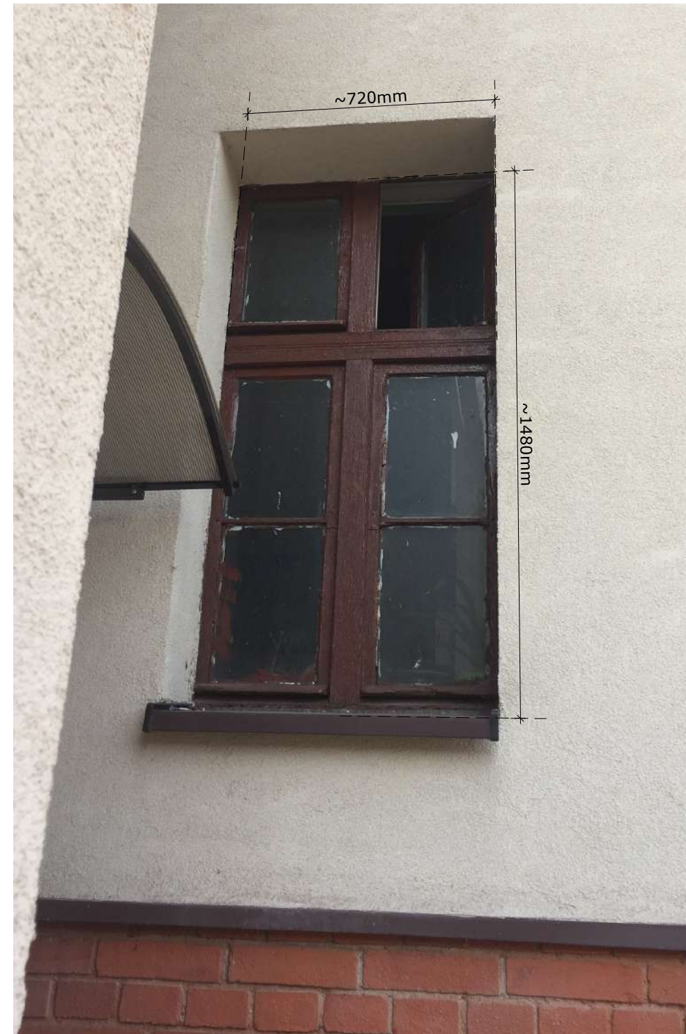
Fot. 3: Stolarka okienna, typ O-69. Widok z podstawowymi wymiarami stolarki. Źródło: Fotografia. Autorzy opracowania (OUTIN Architektura)
