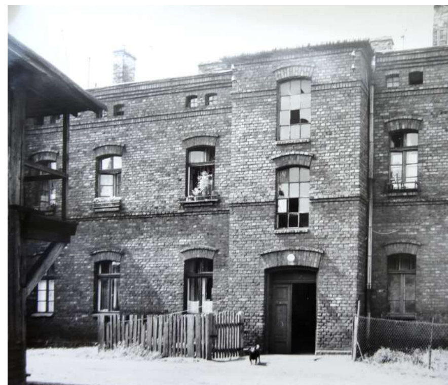
Fot. 4: Dom, ul. Wyszyńskiego. Widok elewacji od strony podwórza.
