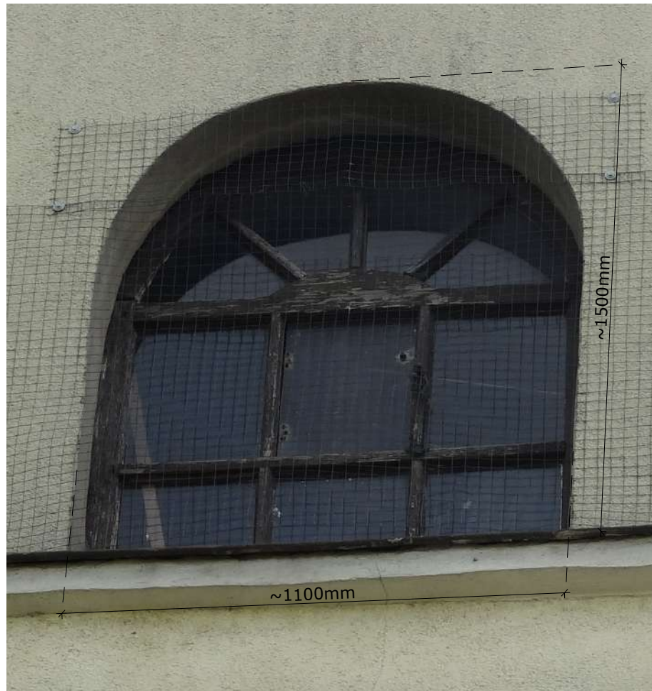
Fot. 1: Stolarka okienna, typ O-61. Widok z podstawowymi wymiarami stolarki. Źródło: Fotografia. Autorzy opracowania (OUTIN Architektura).
