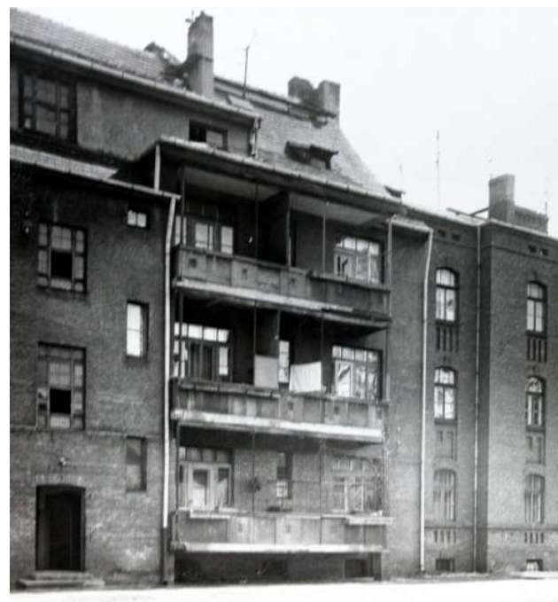
Fot. 4: Dom, ul. 1 Maja 59. Widok podwórza. Źródło: Fotografia. Dokumentacja Konserwatorska PKZ Warszawa 1976. Archiwum WUOZ w Warszawie.
