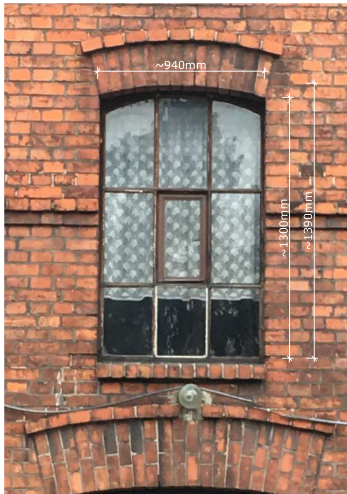
Fot. 1: Stolarka okienna, typ O-30. Widok z podstawowymi wymiarami stolarki (widok zewnętrzny). Źródło: Fotografia. Autorzy opracowania (OUTIN Architektura).
