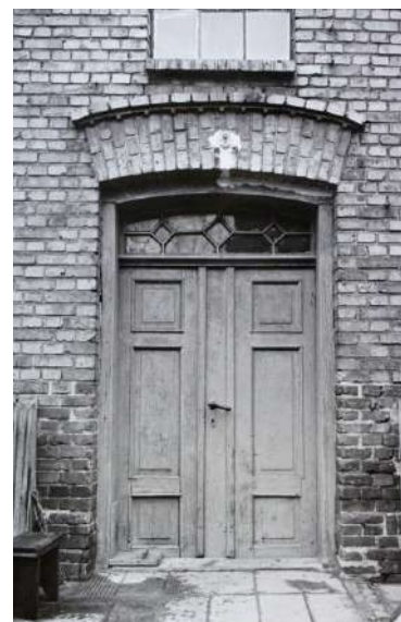
Fot. 3: Dom, stolarka drzwiowa (typ D-03 niniejszego opracowania), ul. Żymirskiego 5, (obecnie Kościelna). Widok od zach.
