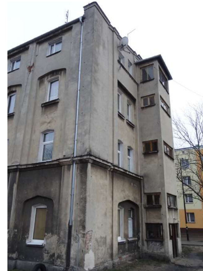
Fot. 2: Budynek przy ul. Mireckiego 70. Fragment elewacji ściany szczytowej z lokalizacją stolarki okiennej.
