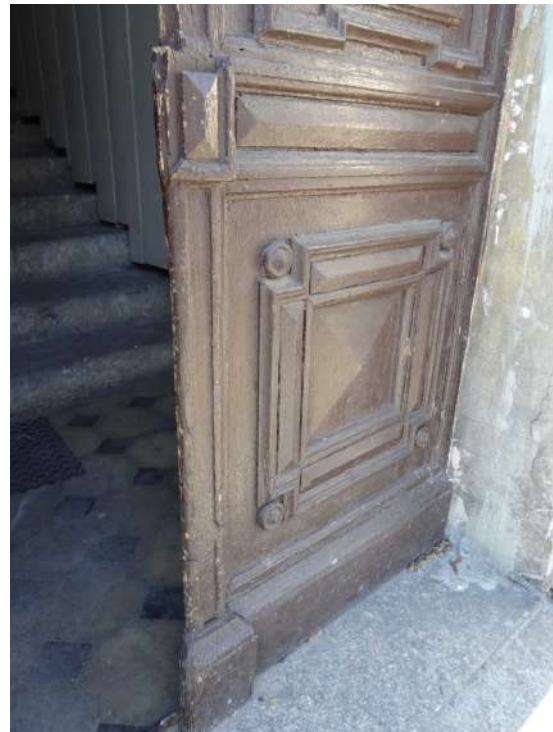
Fot. 1: Stolarka drzwiowa, typ D-02. Detal. Rzeźbiona dekoracja płyciny (filągu, kasetonu) o charakterze geometrycznym. Źródło: Fotografia. Autorzy opracowania (OUTIN Architektura).
