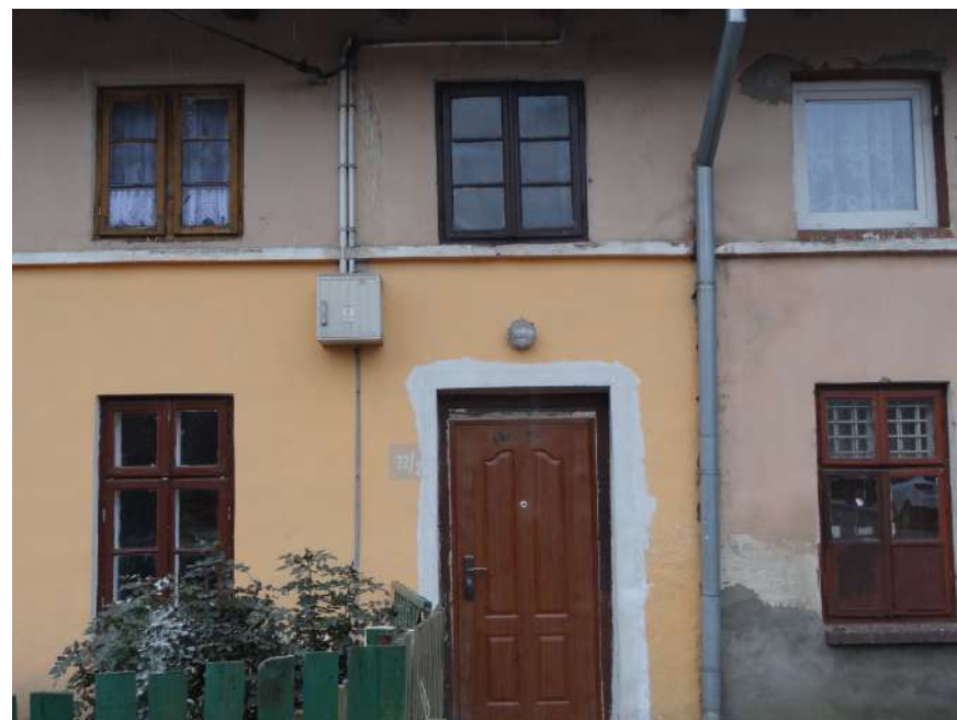
Fot. 3: Dom, ul. Kościuszki 32. Elewacja.
