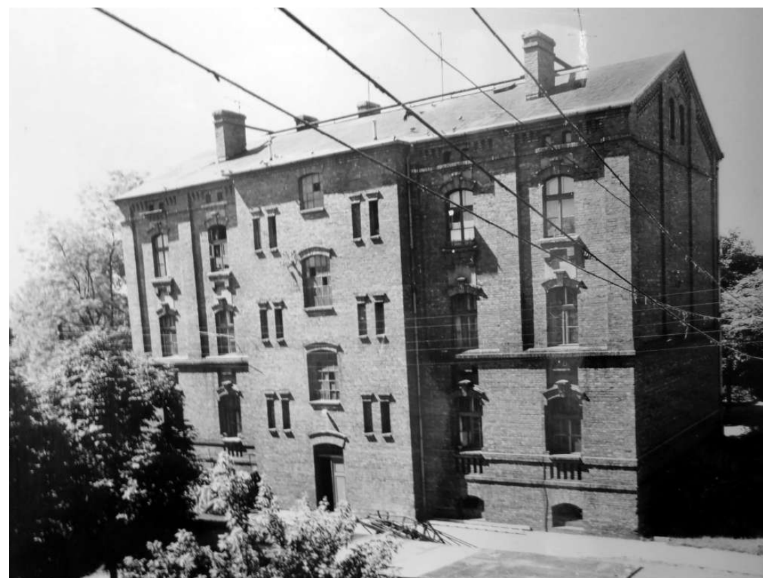
Fot. 3: Dom, ul. Żymirskiego 4 (obecna Kościelna). Źródło: Fotografia. Dokumentacja Konserwatorska PKZ Warszawa 1976. Archiwum WUOZ w Warszawie.
