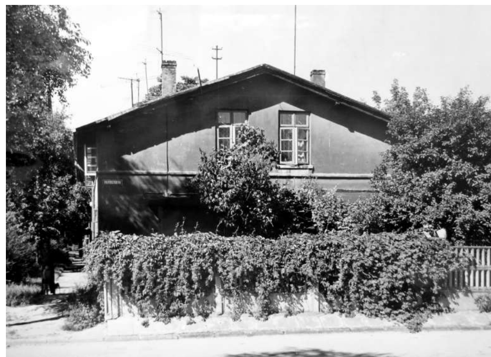
Fot. 4: Dom, ul. Kościuszki 26. Elewacja od strony wschodniej.
