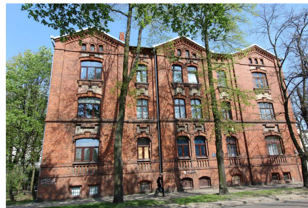
Fot. 4: Budynek, ul. Kościelna 4. Widok obecny.
