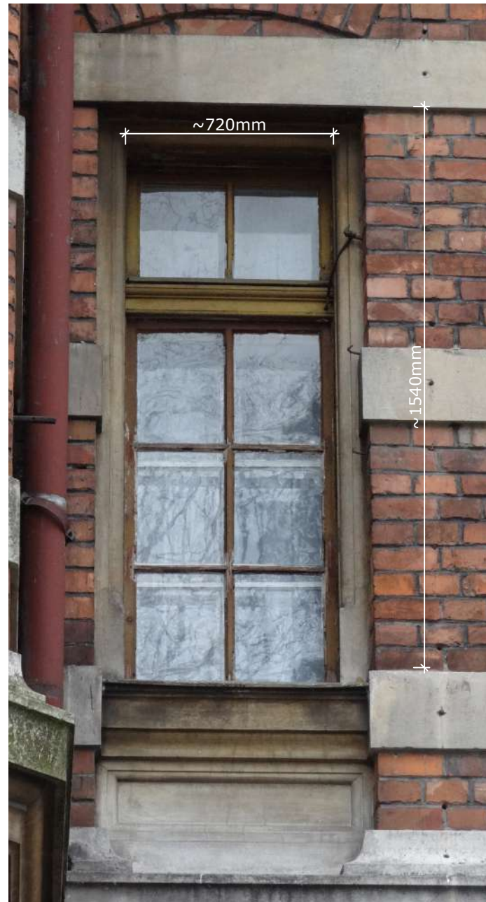
Fot. 1: Stolarka okienna, typ O-26. Widok z podstawowymi wymiarami stolarki (widok zewnętrzny). Źródło: Fotografia. Autorzy opracowania (OUTIN Architektura).
