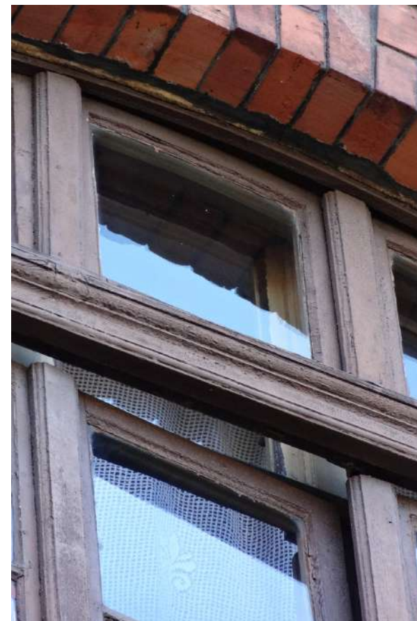
Fot. 2: Stolarka okienna, typ O-35. Detal. Źródło: Fotografia. Autorzy opracowania (OUTIN Architektura).
