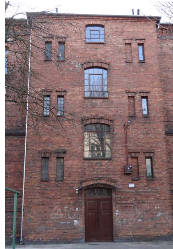
Fot. 2: Budynek, ul. Kościelna 4. Fragment elewacji. Źródło: Fotografia. Autorzy opracowania (OUTIN Architektura).
