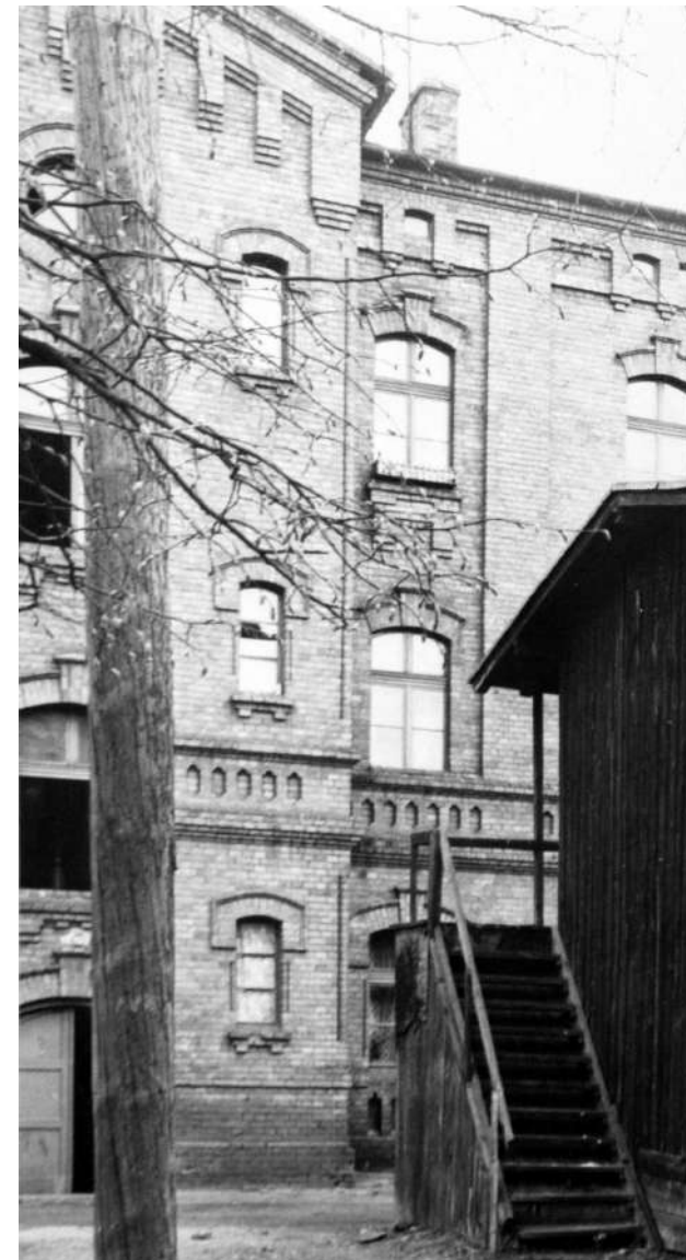
Fot. 4: Dom, ul. Ściegiennego 3.
