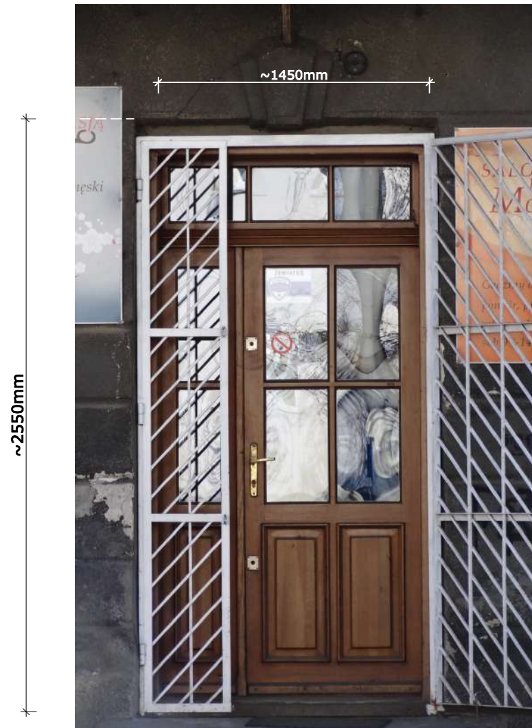
Fot. 1: Stolarka drzwiowa, typ D-08. Widok front (zewnątrz) z podstawowymi wymiarami stolarki. Drzwi współcześnie wymienione. Źródło: Fotografia. Autorzy opracowania (OUTIN Architektura).
