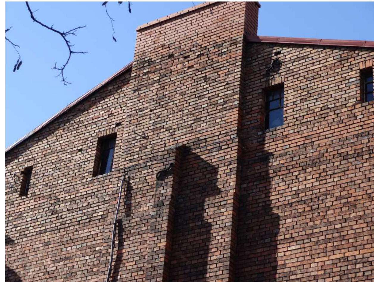
Fot. 2: Budynek przy ul. 1 Maja 54. Widok elewacji szczytowej.
