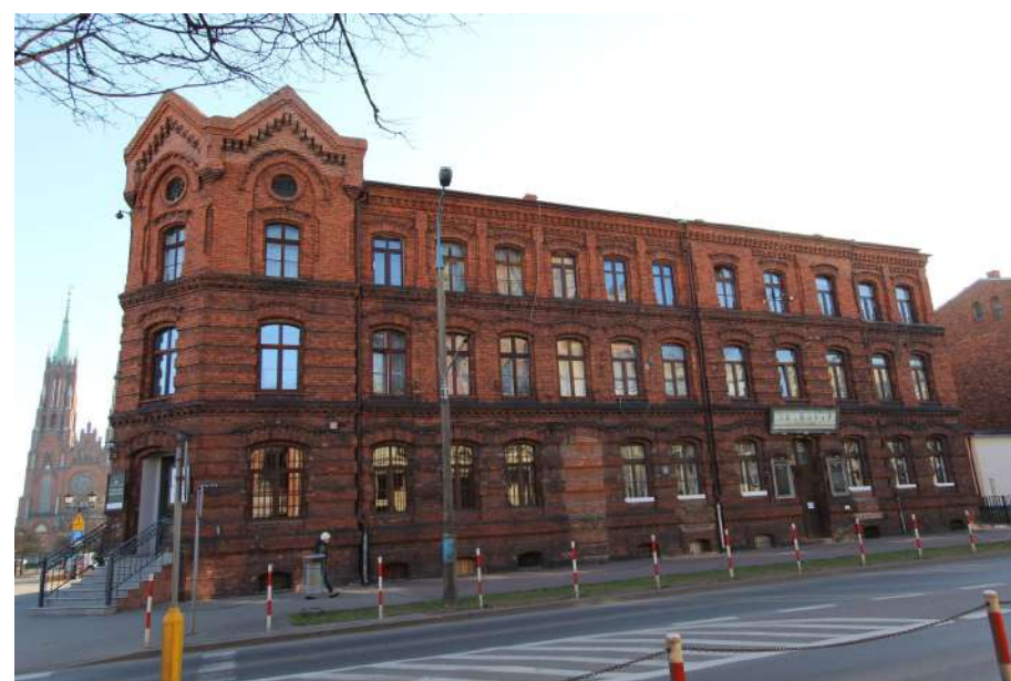
Fot. 4: Budynek, ul. 1 Maja 54. Stan obecny. Źródło: Fotografia. Autorzy opracowania (OUTIN Architektura).
