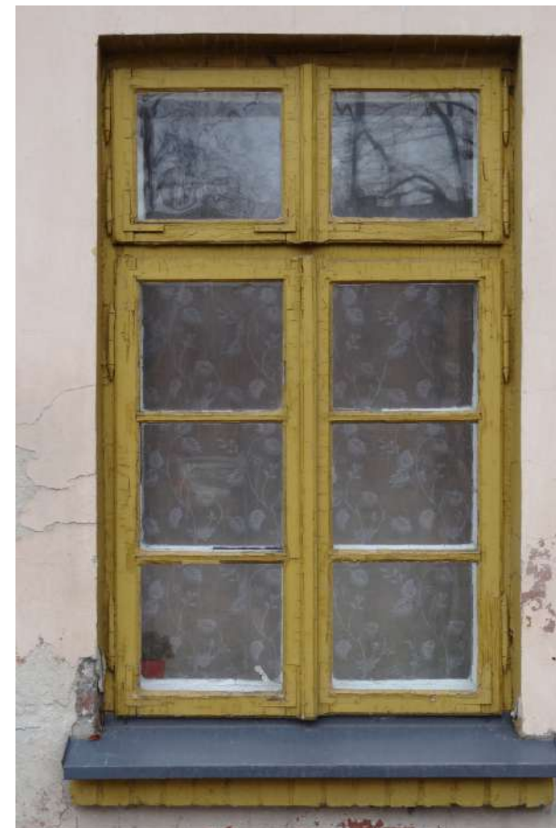
Fot. 2: Stolarka okienna, typ O-05. Widok front, zewnętrzny.
