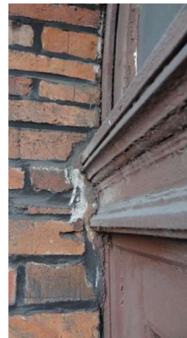
Fot. 5: Stolarka drzwiowa, typ D-05. Detal: belka ślepienna. Źródło: Fotografia. Autorzy opracowania (OUTIN Architektura).
