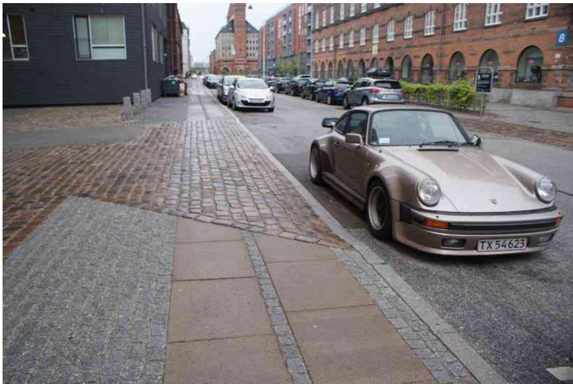
Fotografia 3: Zjazd z drogi publicznej na prywatną posesję. Chodnik i krawężnik lekko obniżone. Dla wszystkich uczestników ruchu nawierzchnia zmienia się na unikalną, informującą podświadomie o kolizji w ruchu. Fot. Krzysztof Jaraszkiewicz, Kopenhaga 2015
