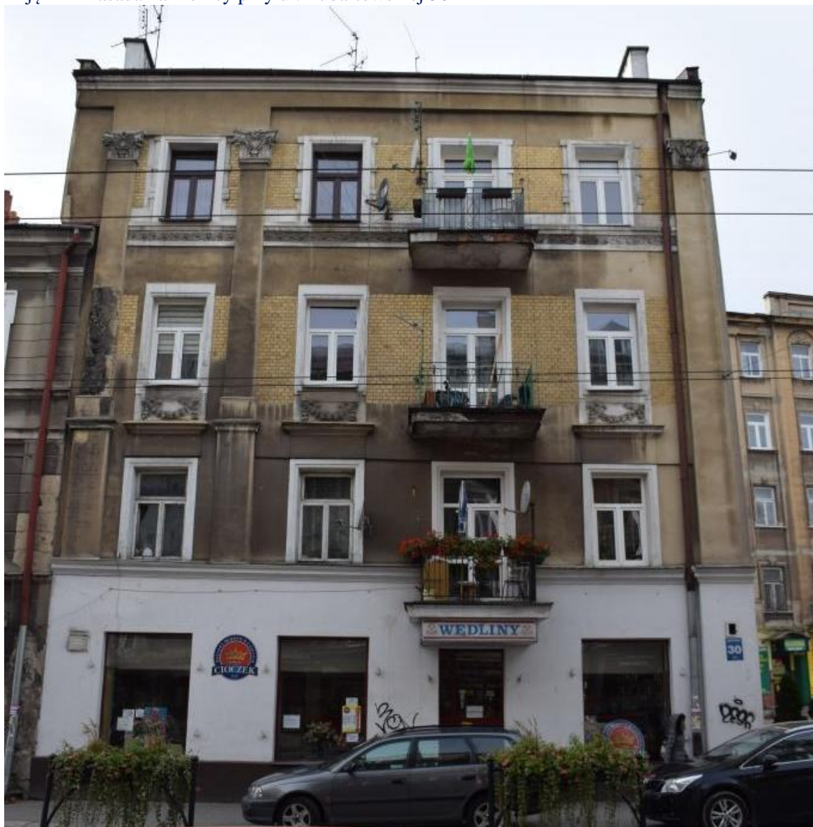
Zdjęcie 1 Fasada kamienicy przy ul. Lubartowskiej 30
