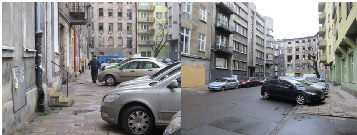
12_Po lewej widok z ul. Lipowej w kierunku północnym. Po prawej: widok z ul. Próchnika w kierunku ul. Lipowej. Widoczne parkowanie na chodnikach oraz zły stan zabudowy. Fot. Anna Jasińska.
