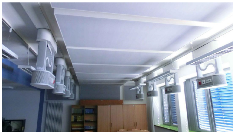
Fot. 14. Sala do fizyki z sufitowymi panelami dźwiękochłonnymi i opuszczanymi mediami Źródło: Sanierung Max – Steenbeck – Gymnasium Cottbus. Schlussbericht, Cottbus, September 2015: s. 32; https://web.archive.org/web/20180315134705/https://projektinfos.energiwende-bauen.de/projekt/energetische-sanierung-einer-plattenbau-typenschule .
