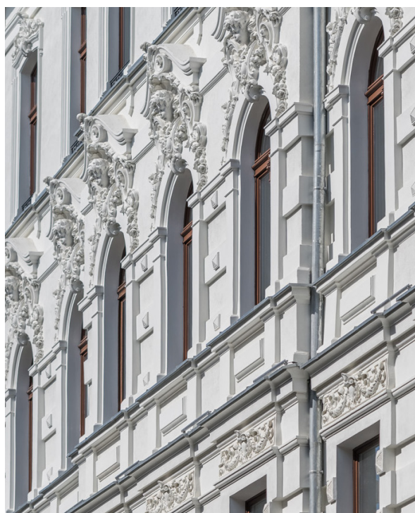
Fot. 7. Modernizacja elewacji budynku wraz z wymianą stolarki okiennej w Łodzi Źródło: Miasto Łódź.
