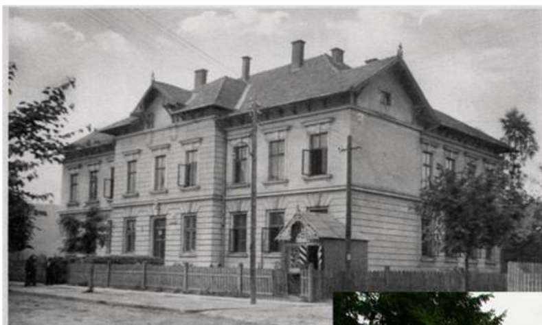
Fotografia 6. Budynek Sądu Rejonowego w Rozwadowie
