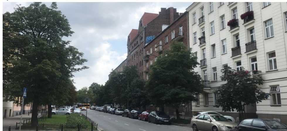
Źródło: Wizja lokalna przeprowadzona przez EY
