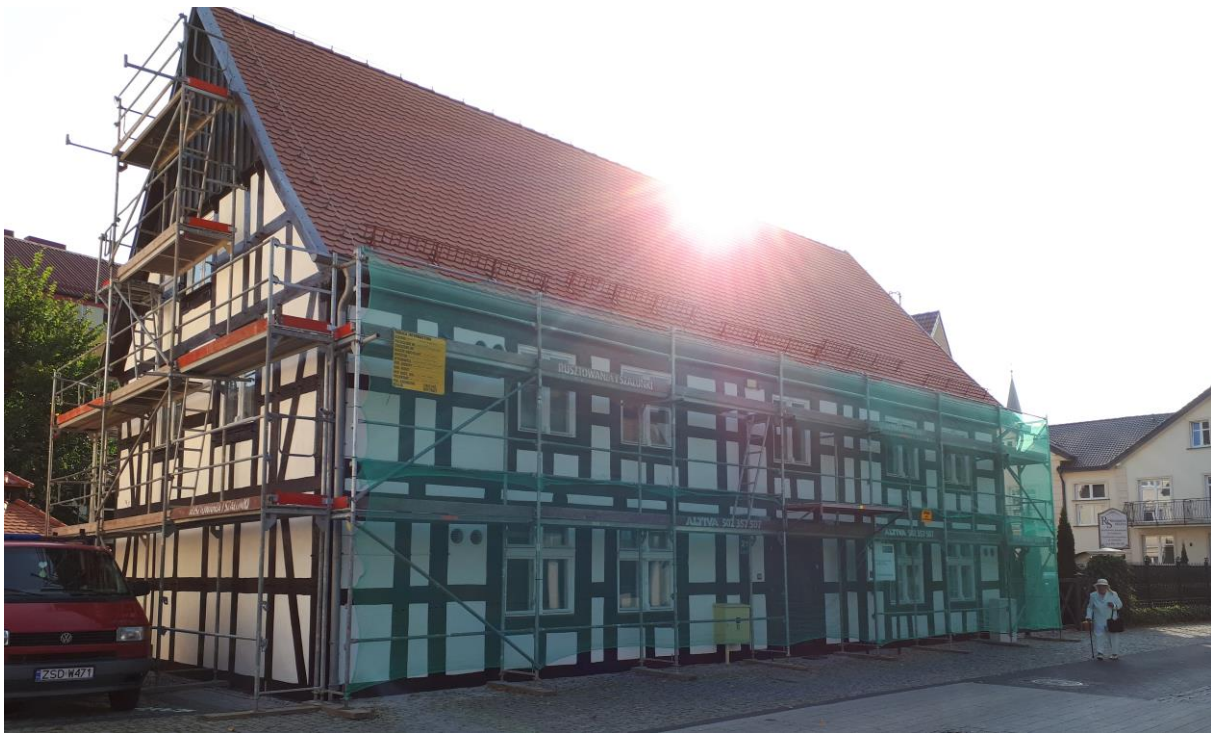
Budynki szachulcowe w Ustce podczas budowy. Fot. AJS.
