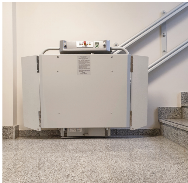
Fot. 10 Podnośnik schodowy poruszający się przy ścianie na specjalnej szynie, archiwum Global Lift Polska
