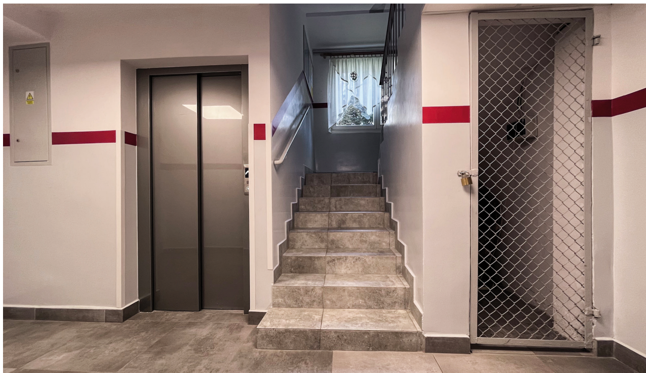
Fot. 4 Dodatkowy poziom zatrzymywania się windy wykonany dzięki wykorzystaniu pomieszczenia na kontenery na śmieci pod dawnym zsysem, fot. Archiwum Jeleniogórskiej Spółdzielni Mieszkaniowej
