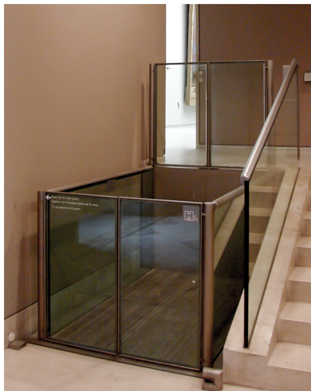
Fot.8 Podnośnik pionowy wewnętrzny, umożliwiający pokonanie schodów w środku budynku. Archiwum Fundacji Integracja
