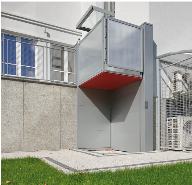
Fot. 9 Kilka schodów przy wejściu do budynku pokona podnośnik pionowy zewnętrzny, archiwum Global Lift Polska
