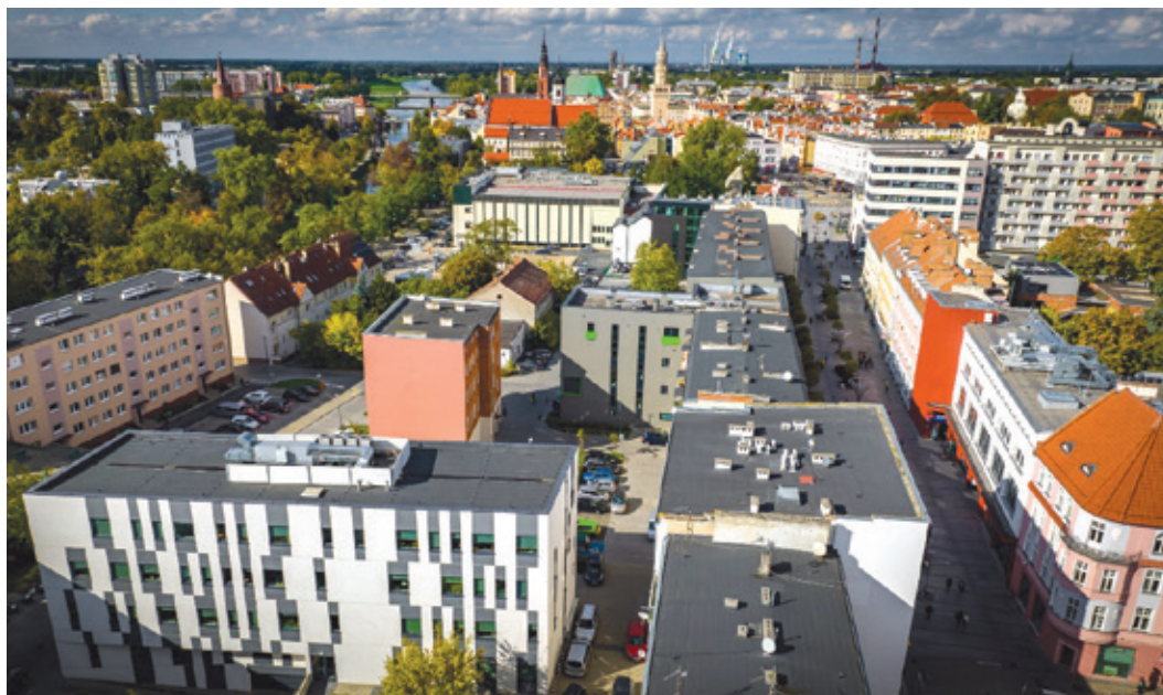
Fot. 4. Widok na ulicę Krakowską po rewitalizacji
