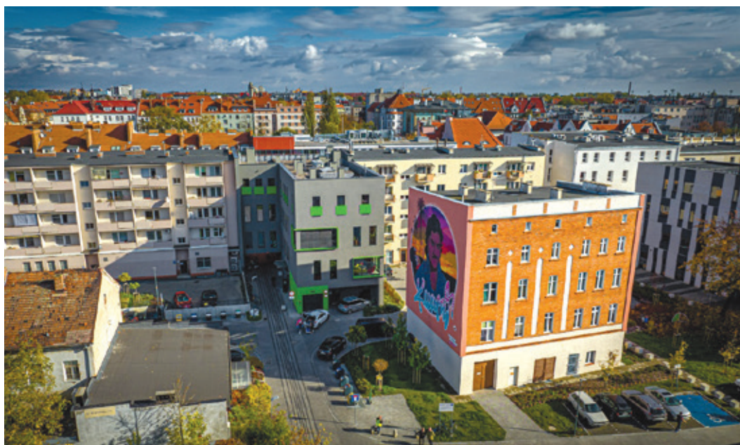
Fot. 5. Widok na budynek CAS przy ul. Krakowskiej
