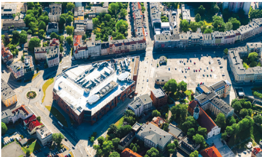
Fot. 9. Plac Mikołaja Kopernika przed rewitalizacją
