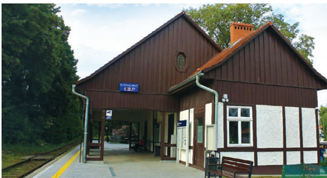
Fot. 13. Wyremontowany budynek dworca w Głuchołazach
