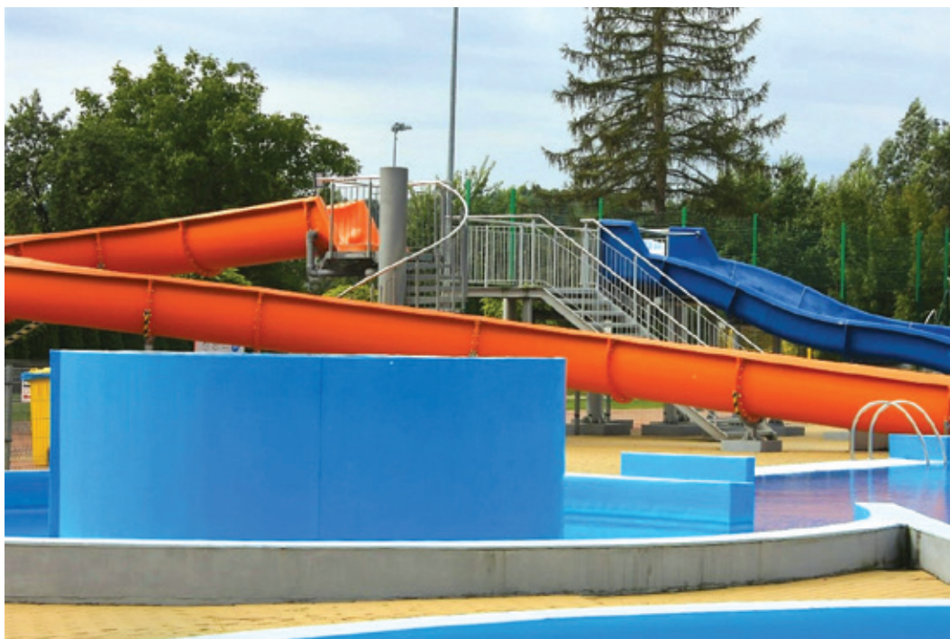
Fot. 16. Zmodernizowany basen w Głuchołazach
