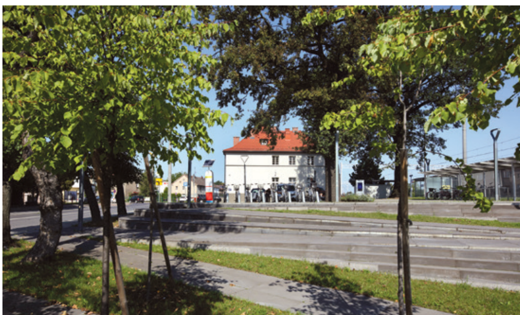
Fot. 8. Wielofunkcyjne Centrum Komunikacji w Oleśnie
