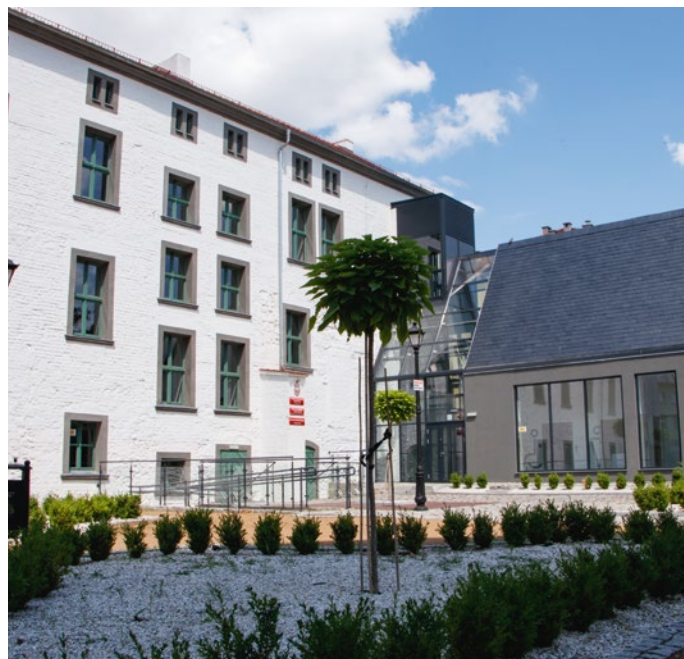
Przebudowa z rozbudową dawnego budynku Klasztoru Magdalenek przy placu Kościelnym 2 w Szprotawie na Centrum Aktywności Społecznej, © IRMiR
