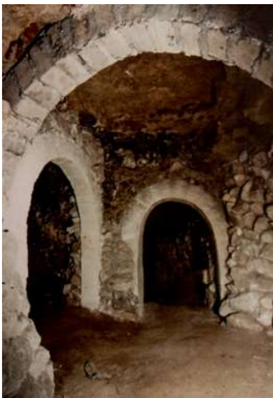
Fot.12. Obudowa ostateczna w Grotach Przy Pałacowych w Puławach /fot. M.Walaszek/
