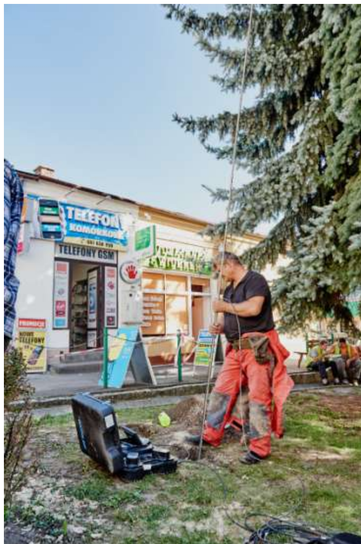
Fot.4. Sondowanie optyczne z zapisem cyfrowym profili otworów badawczych zieleniec przed budynkiem „BGŻ BNP Paribas” /fot. P.Drechsler/
