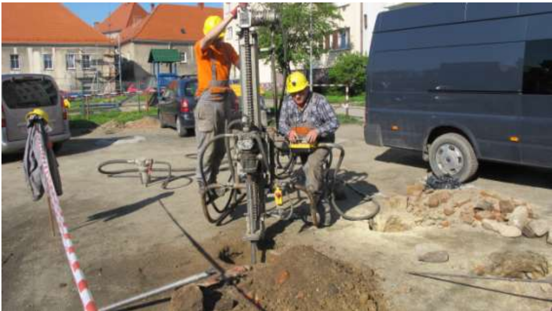
Fot.3. Wykonywanie sondażowych otworów wiertniczych w zabytkowej zabudowie Śródmiejskiej w Bystrzycy Kłodzkiej /fot. P.Drechsler/
