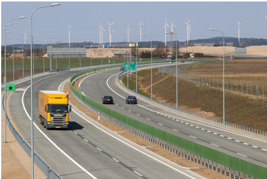
Obwodnica Suwałk – jeden z gotowych fragmentów drogi ekspresowej S61 „Via Baltica”
