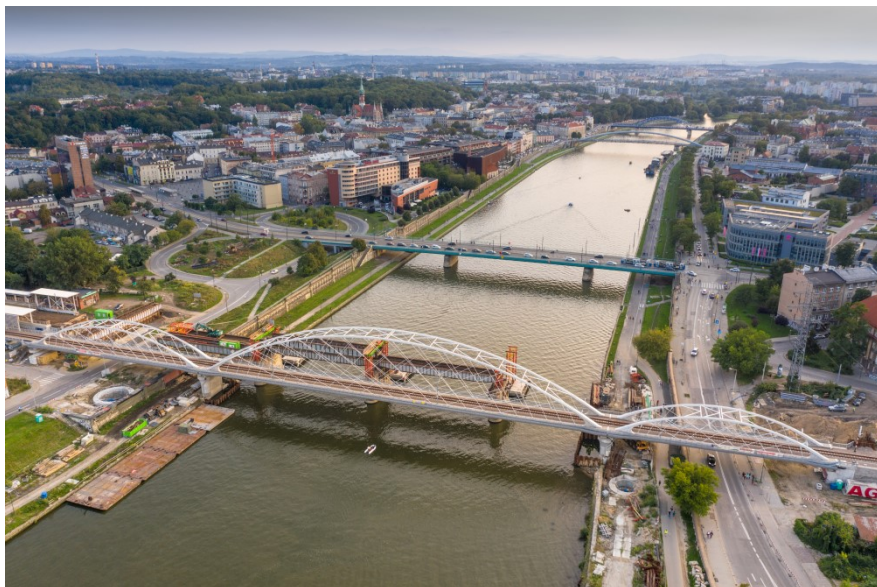
Budowa nowego mostu w Krakowie
