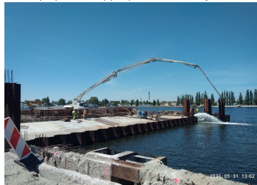
Prace przy łożu rampy w porcie w Świnoujściu
