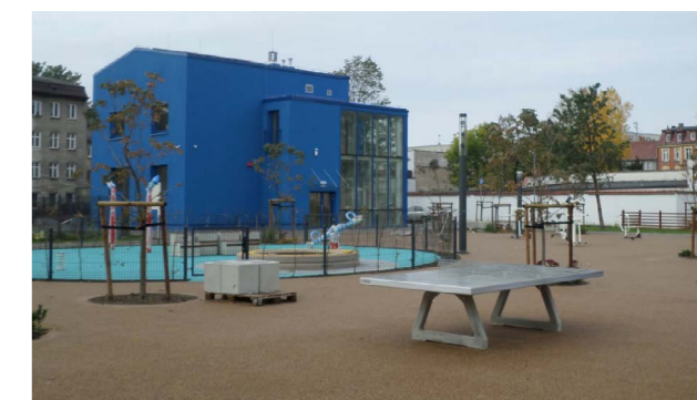
Dom Sąsiedzki - placówka wsparcia dziennego po rozbudowie i adaptacji
