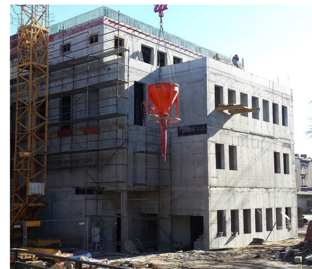
Budowa Centrum Inicjatyw Społecznych i Artystycznych
