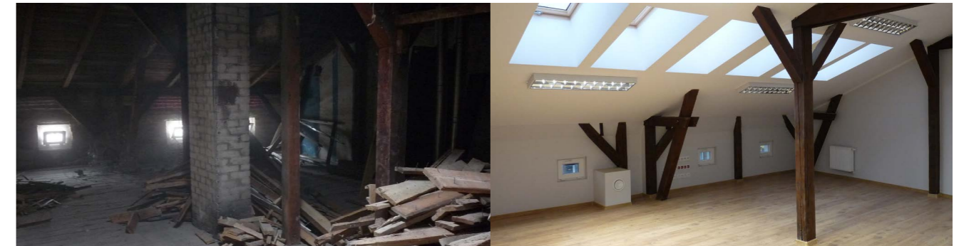
Dom Start - upów przed i po remoncie
