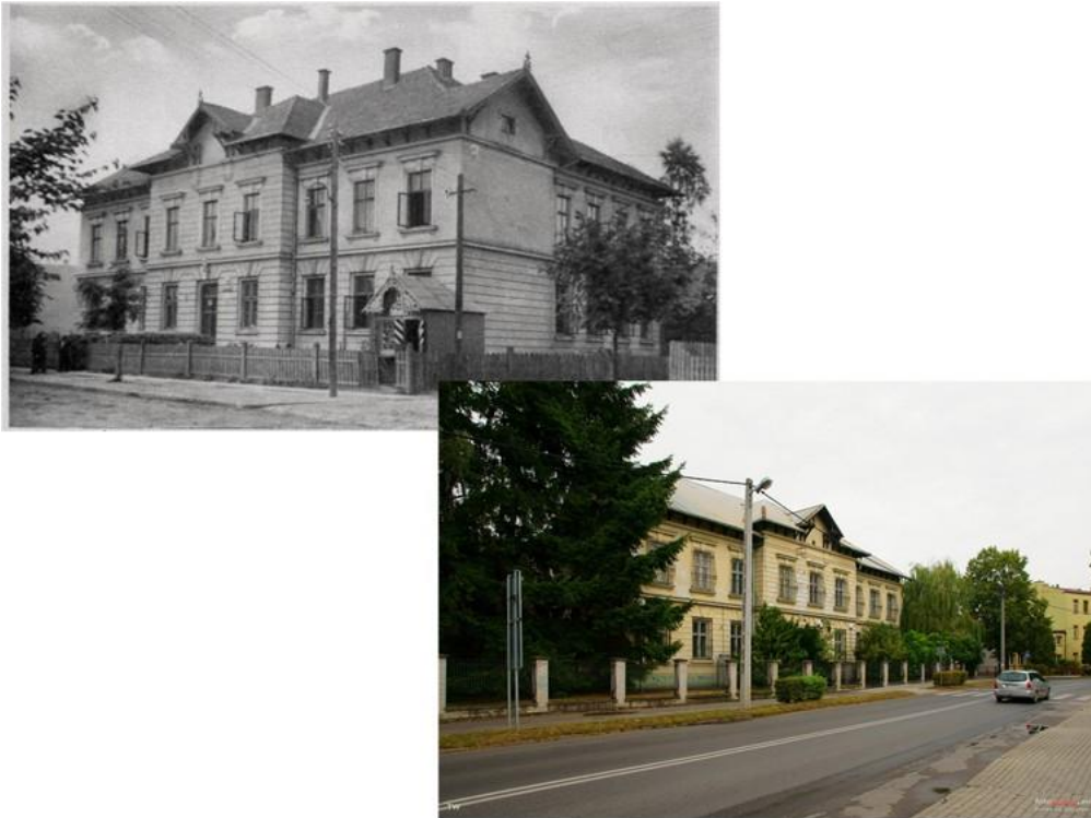
Fotografia 6. Budynek Sądu Rejonowego w Rozwadowie
