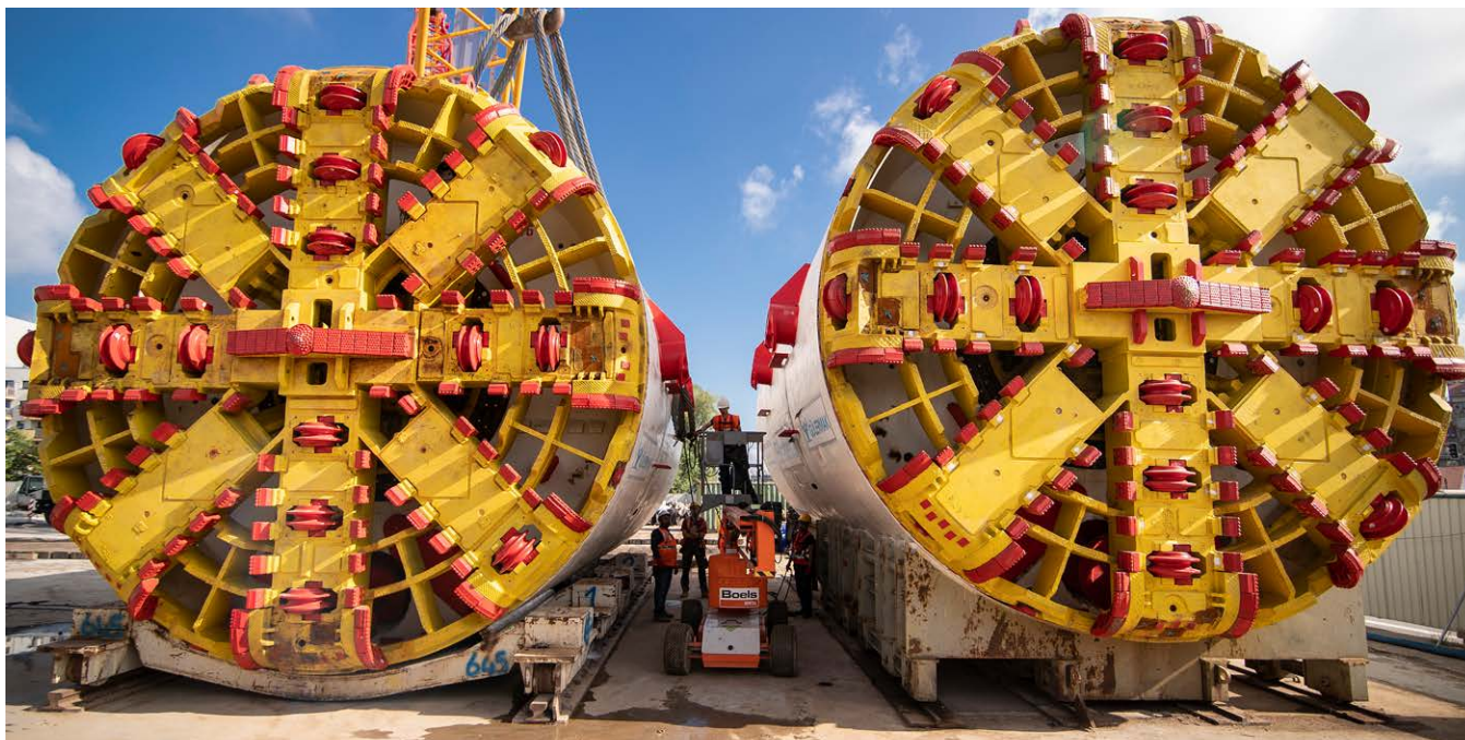
Maszyny TBM pracujące przy budowie drugiej linii metra w Warszawie / fot. Metro Warszawskie
