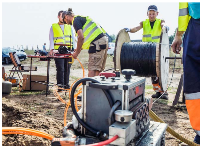
Układanie światłowodu / fot. ASTA-NET
