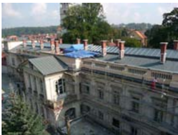
Ryc. 43 Remont budynku Nowego Zamku I etap (fot. www.starostwo.zywiec.pl 8.11.2010)
