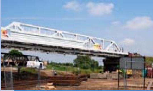
Prace przy wymianie wiaduktu
