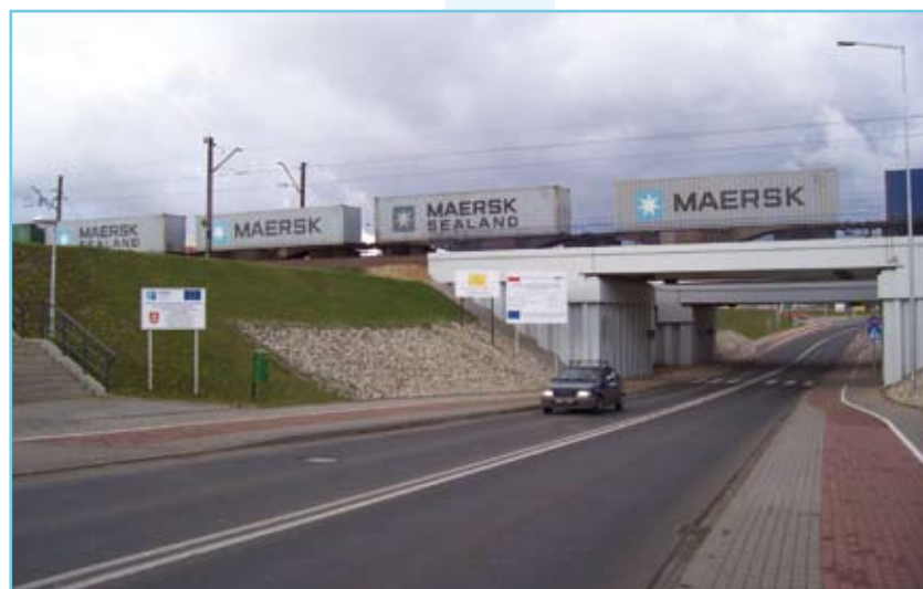
Dwupoziomowe skrzyżowanie czyli bezkolizyjny przejazd
