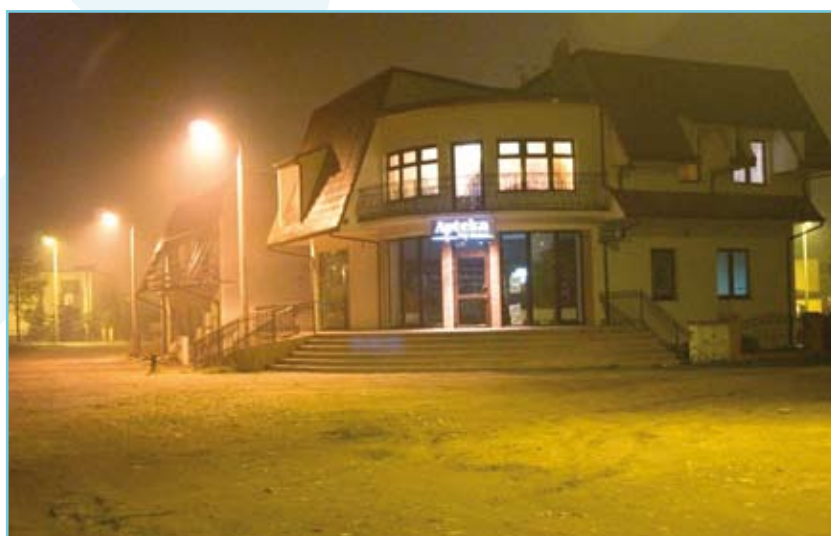
Już nie ma błota, pozostało położyć nawierzchnię
