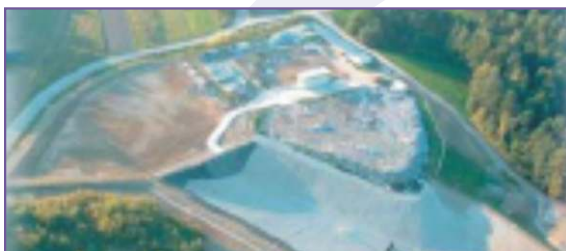
Sułkowice – składowisko odpadów komunalnych
